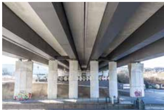
2 Ansicht der Pfeilerachse 30 im Bestand © Hochtief Infrastructure GmbH
