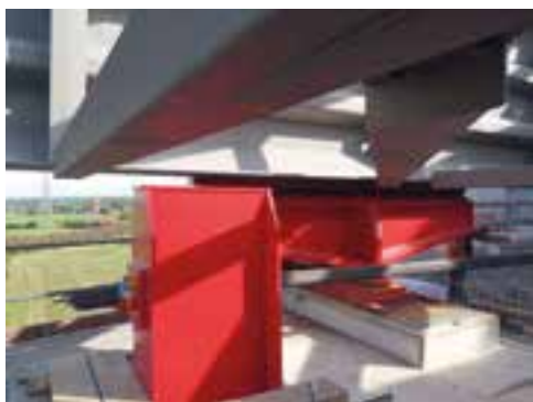
23 Querverschiebbliche Vershubwippe im Bereich des Widerlagers © Plauen Stahl Technologie GmbH
