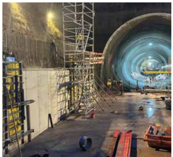
10 Tunnel Berkersklamm im Bau © Hessen Mobil
