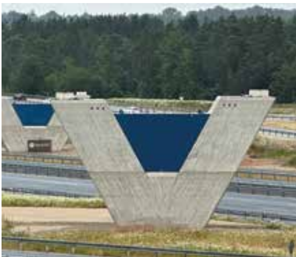
9 Pfeiler in Achse 4 © Bung Ingenieure AG
