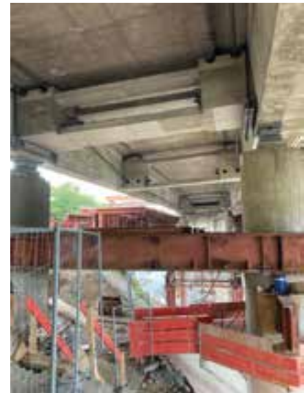
4 Steckträgerauflagerung am Bestandspfeiler © Implenia Civil Engineering GmbH
