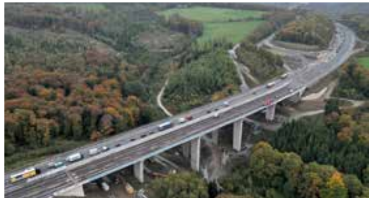
Erstes Teilbauwerk nach Fertigstellung © Gebr. Echterhoff GmbH & Co. KG
