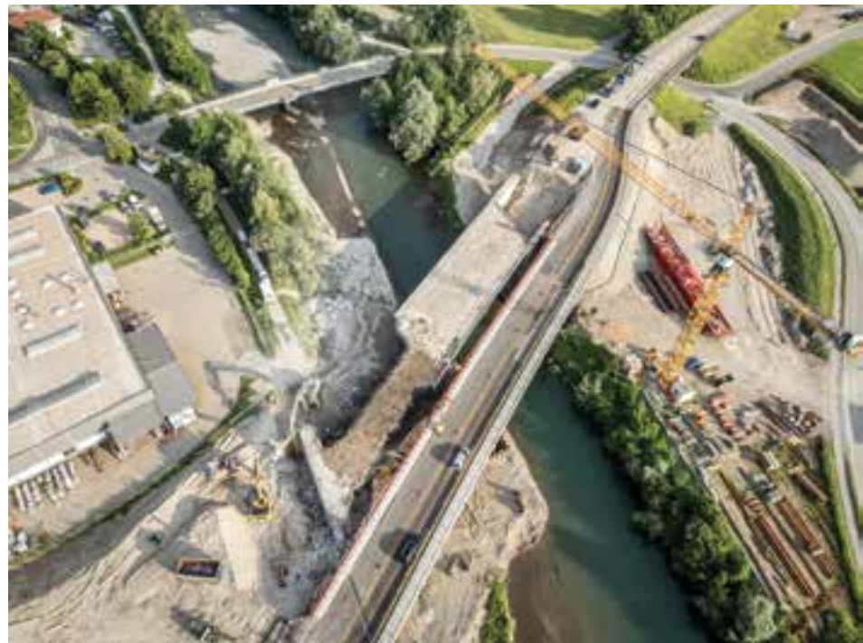
11 Impression vom Bestandsabbruch © Kögl Recycling e. K.
