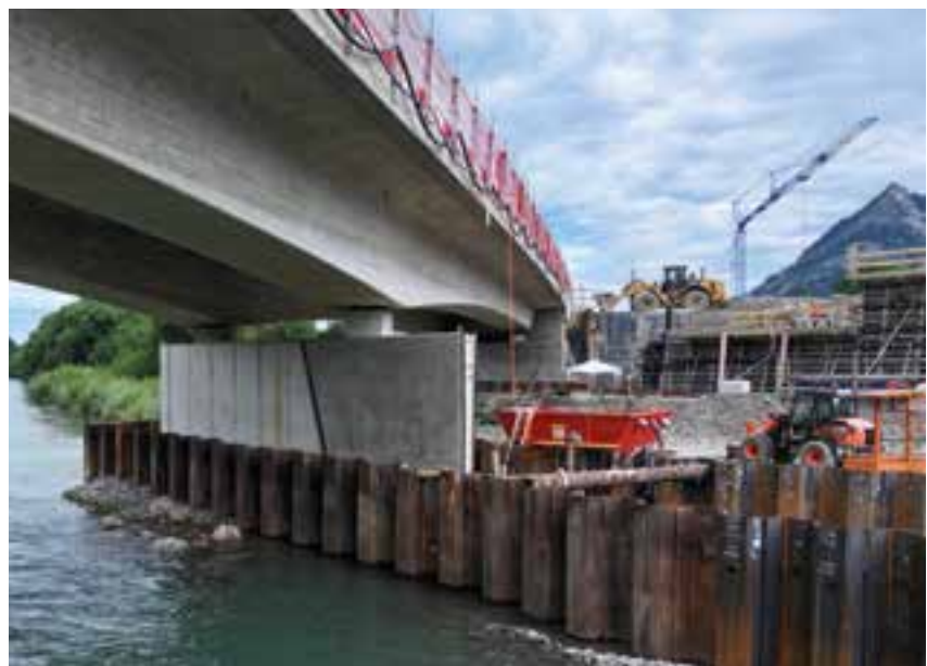
13 Pfeiler in provisorischer Lage © Dr. Schütz Ingenieure
