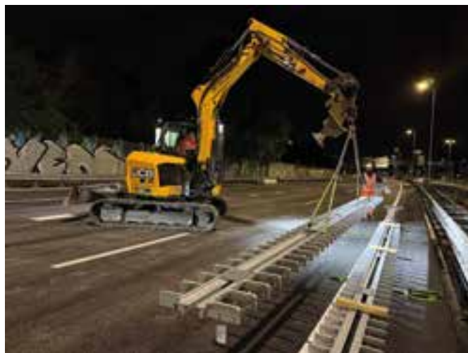
Bereitstellung der neuen Fahrbahnübergänge © Maurer SE
