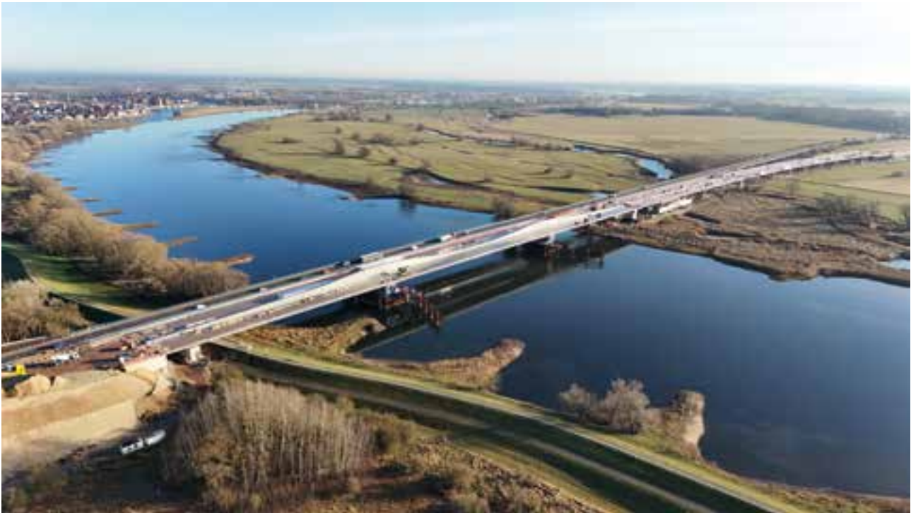
20 Drohnenaufnahme des Brückenzugs von Dezember 2025 © DSD Brückenbau GmbH
