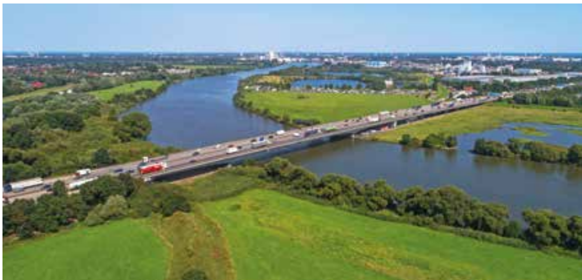
1 Weserbrücke im Bestand © René Legrand/DEGES GmbH
