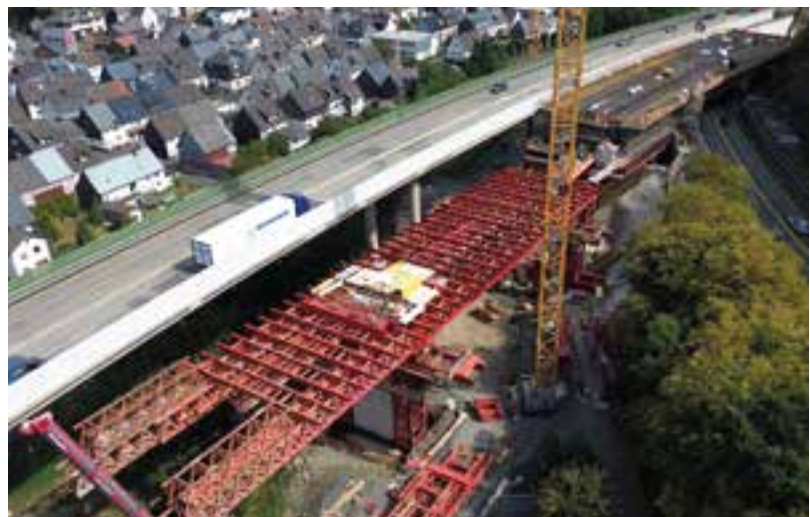
21 Neubau mit Vorschubrüstung © Implenia Civil Engineering GmbH
