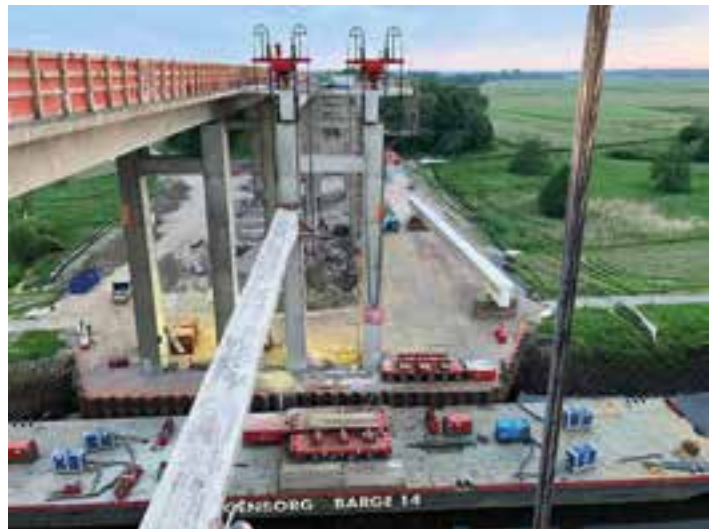
9 Absenken der Träger im Huntefeld und Ablage auf dem Ponton © Moß GmbH
