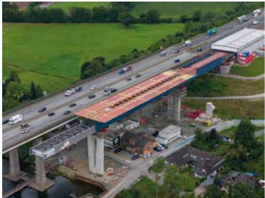
22 Überbau Nord nach Vershub (Takt N 03) mit Vorbauschnabel im Bereich des Pfeilers in Achse 30 © DEGES GmbH
