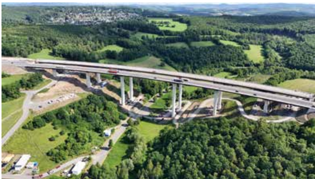
6 Luftbild der Talbrücke vor dem Querverschub © Die Autobahn GmbH
