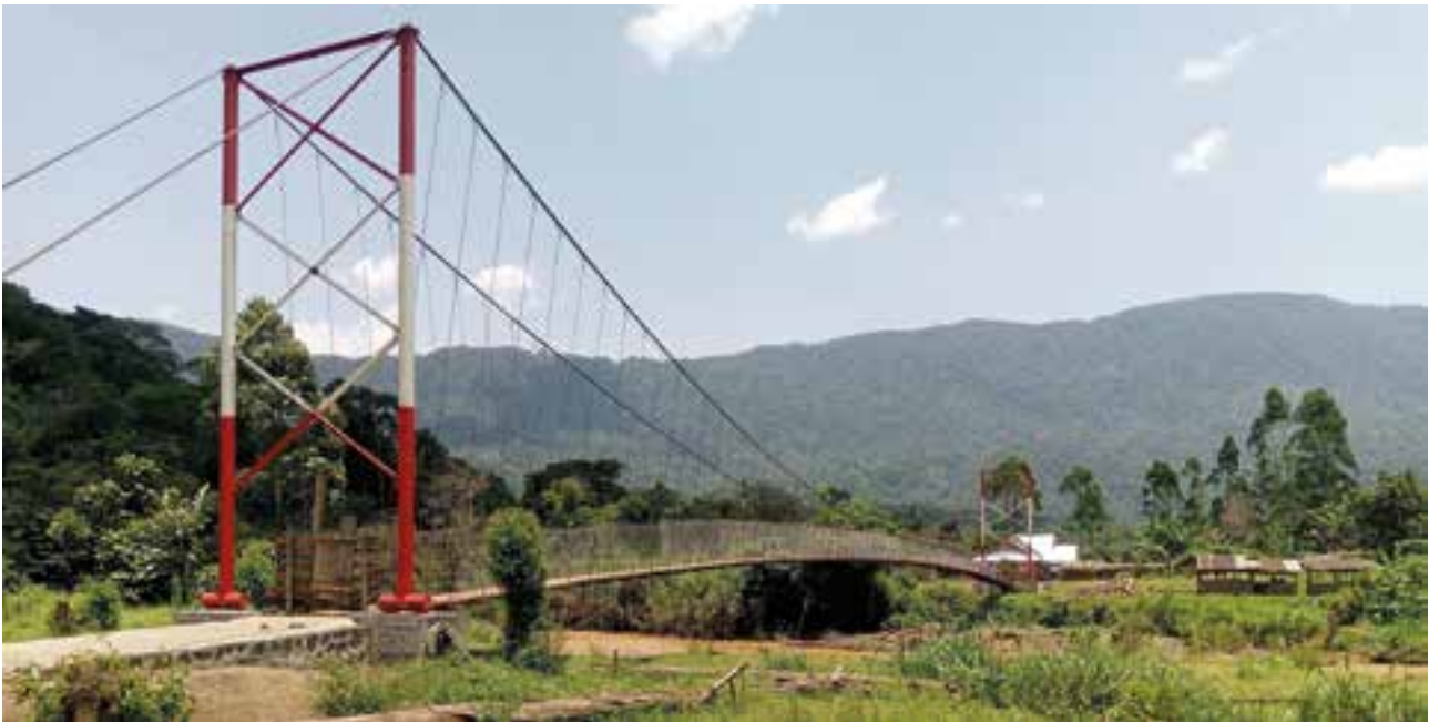
20 Neue Fußgängerbrücke Lukweti vor der Eröffnung © Gaspard
