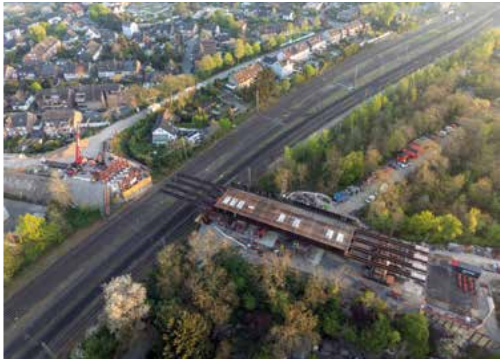
1 Überbau zu Beginn des horizontalen Verschts inklusive Vorbau- und Nachlaufsnabel © Teupe-Gruppe
