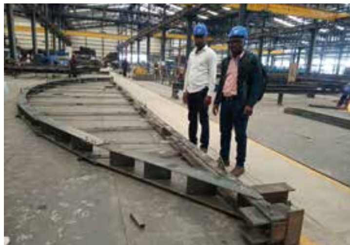
13 Vormontage der Stahlblechelementbögen in der Werkstatt © Dady Kasereka
