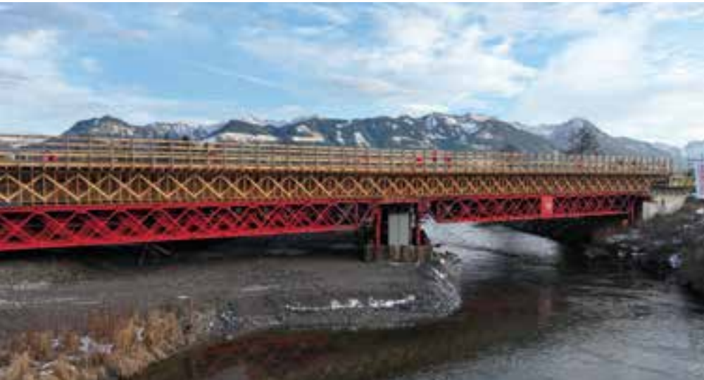
17 Ansicht von Westen: Traggerüst mit Schalung © Dr. Schütz Ingenieure
