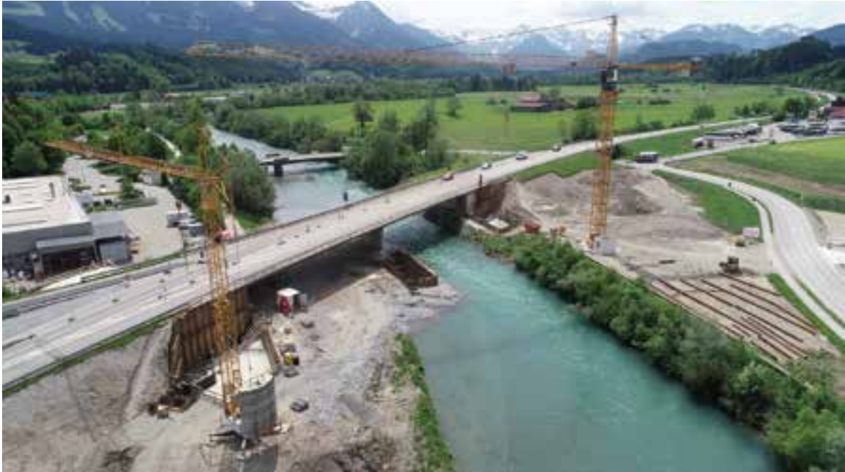
3 Überbau West in Seitenlage: Blick in Richtung Osten © Dr. Schütz Ingenieure
