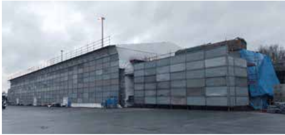
28 Mittelsegment im Hafen Rendsburg mit Schutzeinhausung im Dezember 2025 © Plauen Stahl Technologie GmbH
