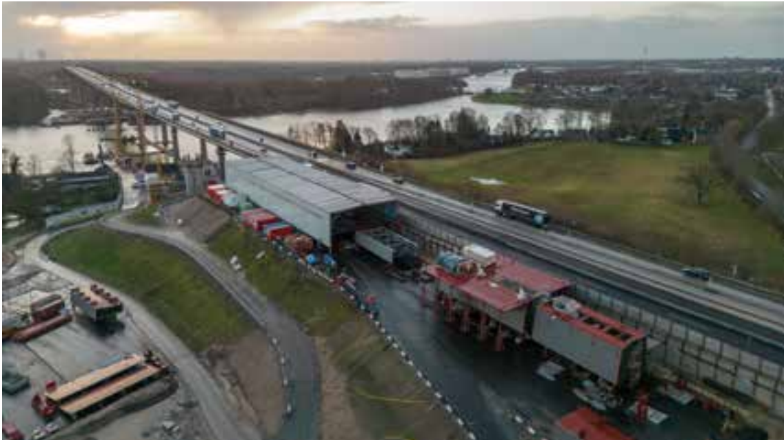
21 Beginn der Stahlbaumontage: Korrosionsschutzeinhausung nach Fertigstellung, Montage von Vorbauschubnabel und Takt N 01 © DEGES GmbH
