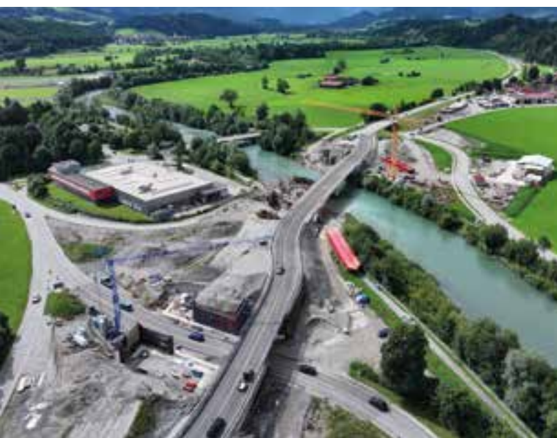
19 Übersicht über den Bauzustand: Verkehr auf dem Überbau West © Dr. Schütz Ingenieure
