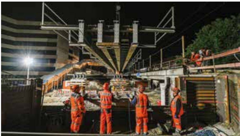
7 Absenken einer Hilfsbrücke in Hamburg-Rothenburg © DB Bahnbau GmbH/Max Lautenschläger
