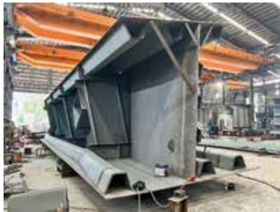
11 Stahlfertigung des Überbaus © KSECO
