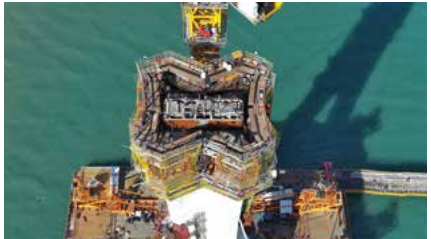
15 Oberer Pylonquerschnitt mit Verankerungsboxen der Schrägkabel © KSECO
