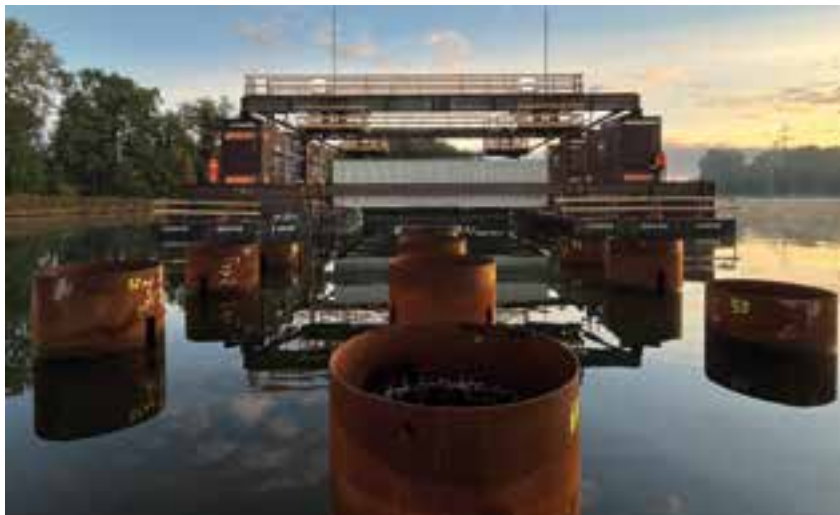
9 Stahlhülensrohre der Bohrpfähle mit Katamaranpontoon © Implenia Civil Engineering GmbH
