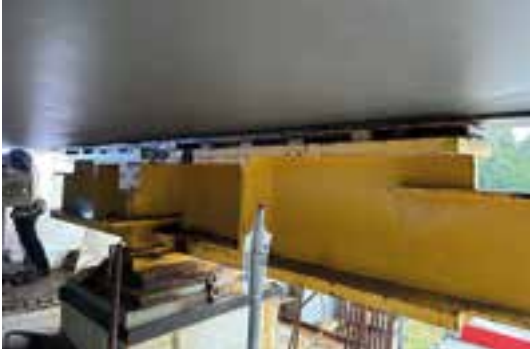
18 19 Längsschub des Fahrbahnträgers in Takt 1 © Bung Ingenieure AG/Donges Steeltec GmbH
