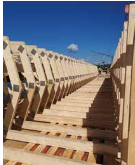
18 Schalungskonstruktion im Pfeilerbereich © Dr. Schütz Ingenieure
