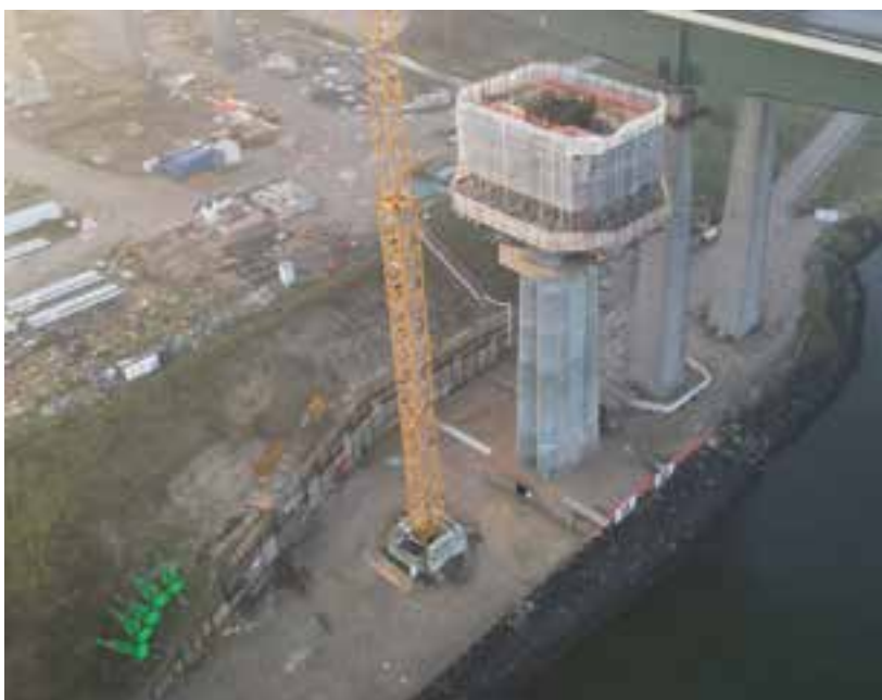
14 Herstellung der Hammerkopfschalung © Implenla Civil Engineering GmbH
