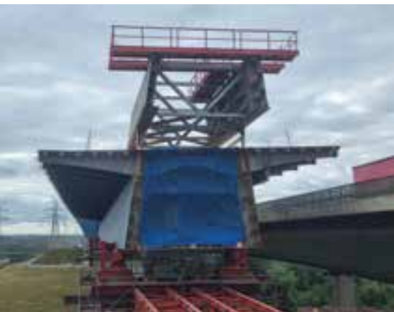
30 Südlicher Überbau mit vormontiertem Derrick für die Hubmontage des Mittelsegments während des Endeinschubs im August 2025 © Plauen Stahl Technologie GmbH
