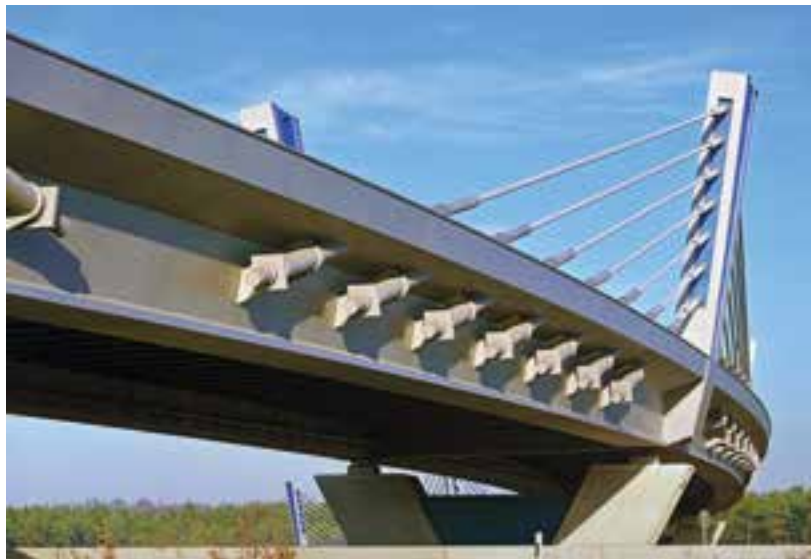
1 Extradosed-Brücke nach Fertigstellung © Jan R. Schäfer/J1 Fotografie
