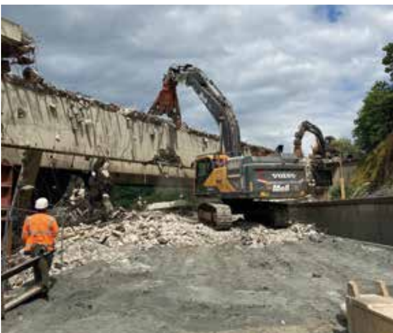
5 6 Abbruch des Bundesstraßenfelds © Implenia Civil Engineering GmbH
