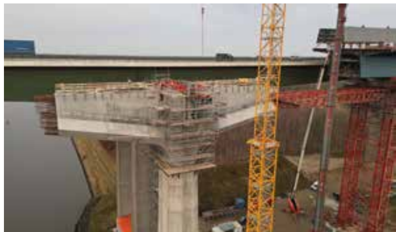
20 Hammerkopf und Vouten © Implenia Civil Engineering GmbH
