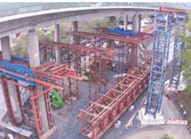
9 10 Hubgerüst für die Montage der Vorschubrüstung © Implenja Civil Engineering GmbH
