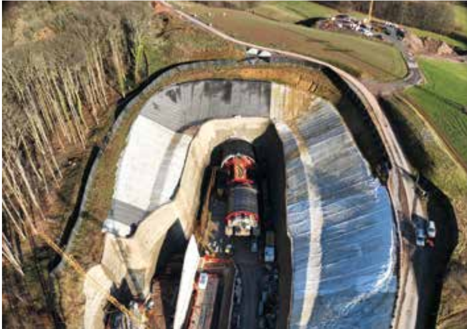
8 Baufeld südliches Tunnelportal mit Gewölbeschwalgen © Bung Baumanagement GmbH
