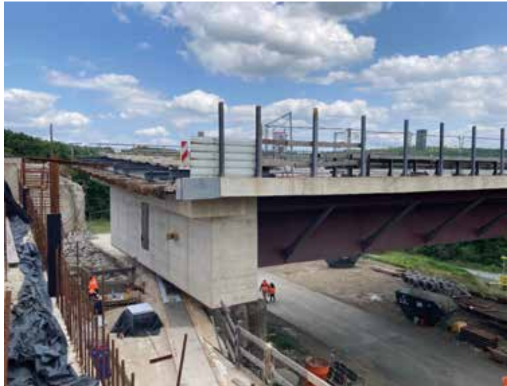
8 Vershubdetail am Widerlager © Ingenieurgemeinschaft Krebs+Kiefer/Meyer+Schubart
