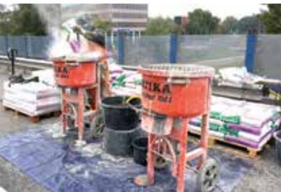
Vorbereitung des speziellen Stahlfaserbetons © Maurer SE
