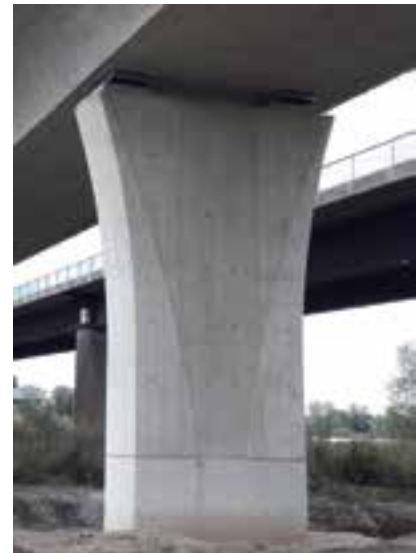
9 Vorlandpfeiler nach Fertigstellung © Leonhardt, Andrä und Partner AG
