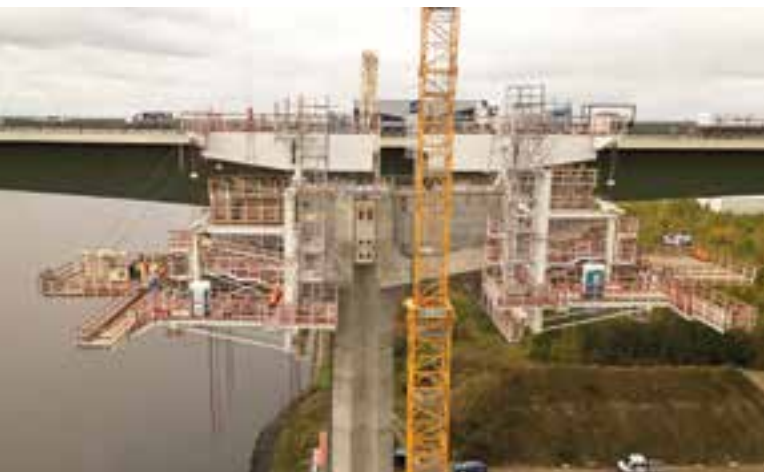
19 Freivorbau- und Schalwagen im Einsatz © Implenia Civil Engineering GmbH
