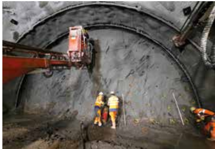
14 Tunnel Kisselhöhe im Bau © Bung Baumanagement GmbH
