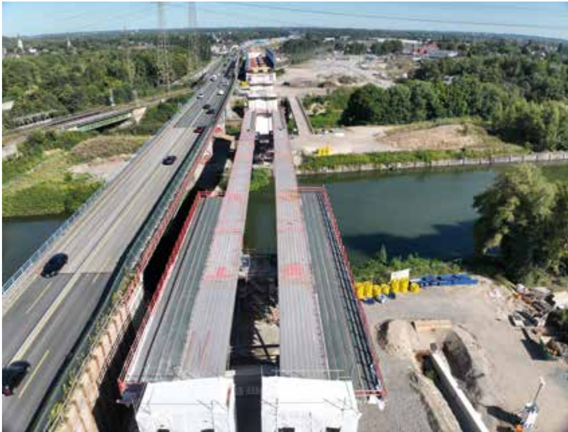
10 Bauzustand im August 2025 © Schübler-Plan Ingenieurgesellschaft mbH
