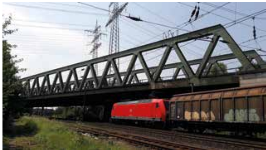
4 Bestandsbrücke über die Gleisanlagen der Deutschen Bahn © Schübler-Plan Ingenieurgesellschaft mbH
