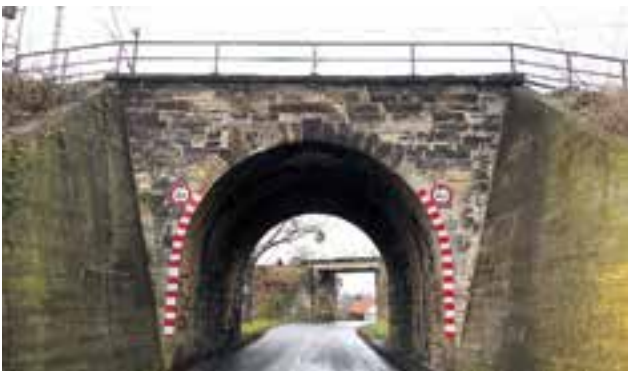
4 Gewölbebrücke vor der Instandsetzung © Walter Pelka
