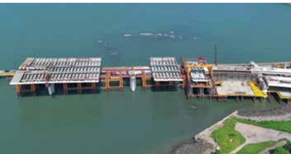
16 Überbaumontage in den Seitenfeldern © KSECO
