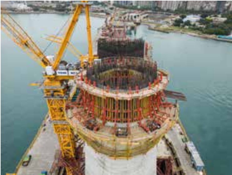
13 Herstellung des Pylons mit Kletterschalung © Peri SE
