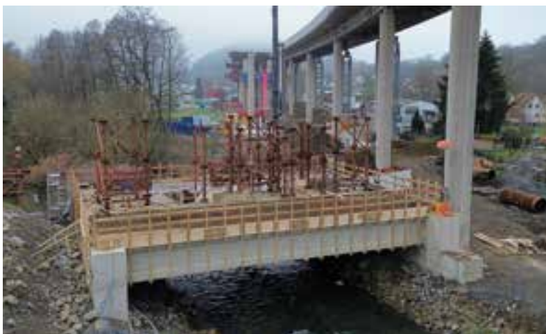
22 Auflager für die Dillquerung © Implenia Civil Engineering GmbH
