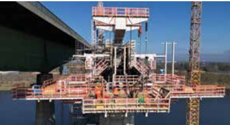
17 18 Freivorbau- und Schalwagen © Implenia Civil Engineering GmbH
