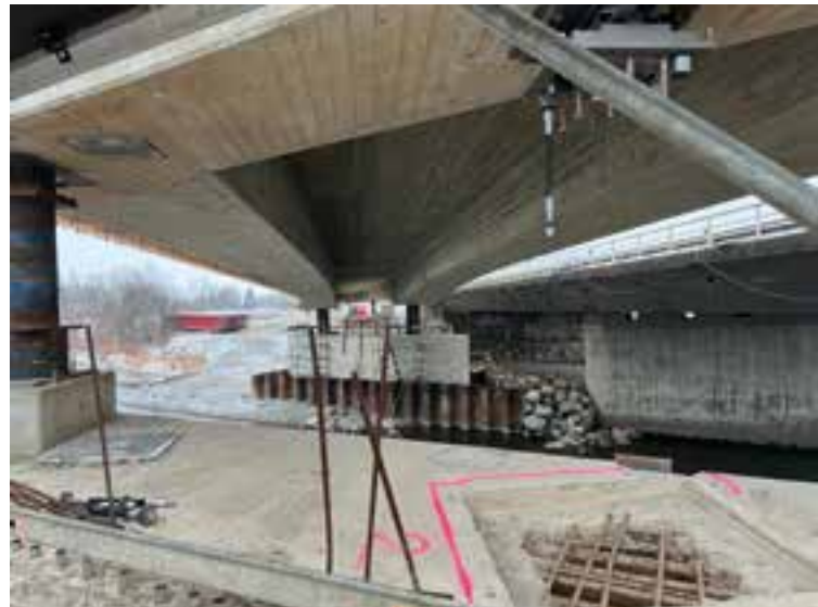
16 Überbau West nach Ausschalung noch in Hochlage © Dr. Schütz Ingenieure
