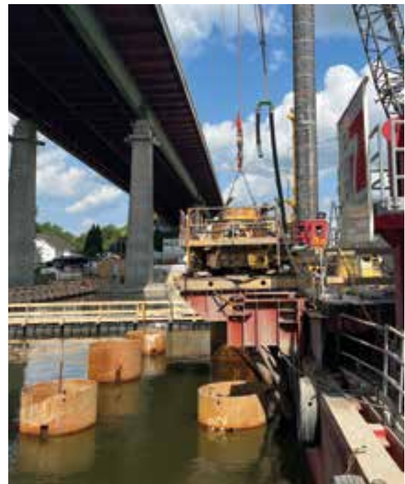
6 Kragarmkonstruktion an Bordwand © Implenia Civil Engineering GmbH
