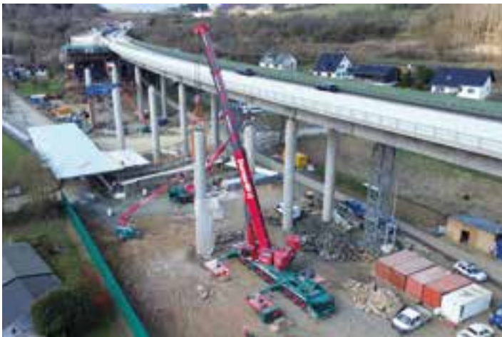
14 15 Abbruch der Bestands Pfeiler © Implenia Civil Engineering GmbH
