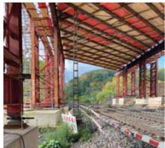
23 Schutzgerüst über der DB-Strecke © Implenia Civil Engineering GmbH
