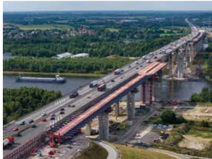
26 Endeinschub der südlichen Vorlandbrücke im August 2025 © DEGES GmbH
