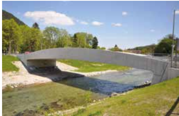
11 Die gegen das Eigengewicht nach oben gekrümmte Huyckbrücke als Spannbetontrog © Michael Kleiser
