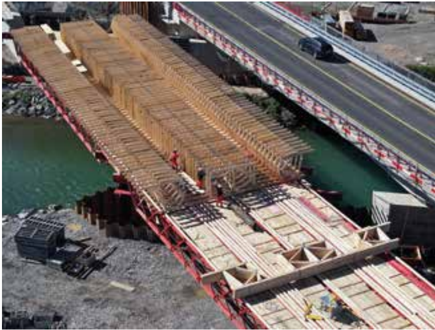
14 Überbau Ost während des Schalungsaufbaus © Dr. Schütz Ingenieure
