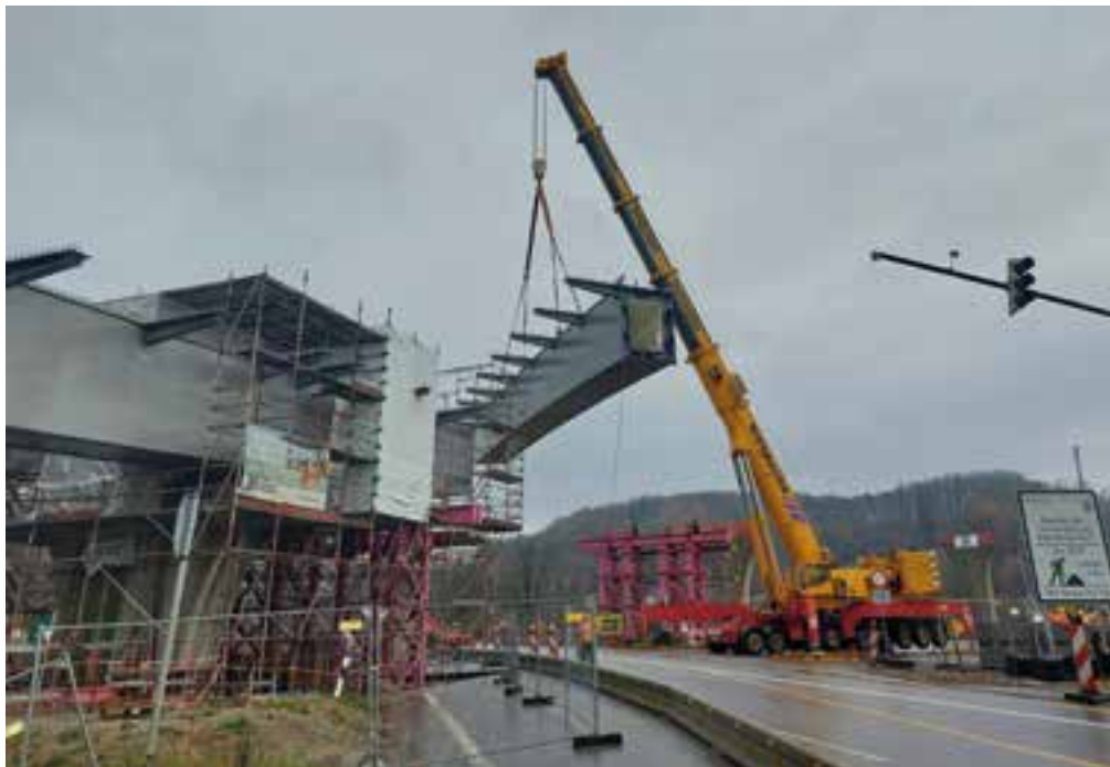
7 Hubmontage der Stahlbauelemente bei der Talbrücke Reisen © Hessen Mobil
