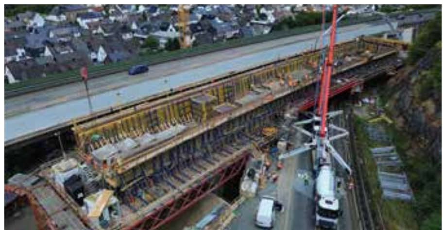
20 Betonage des ersten Bauabschnitts © Implenla Civil Engineering GmbH
