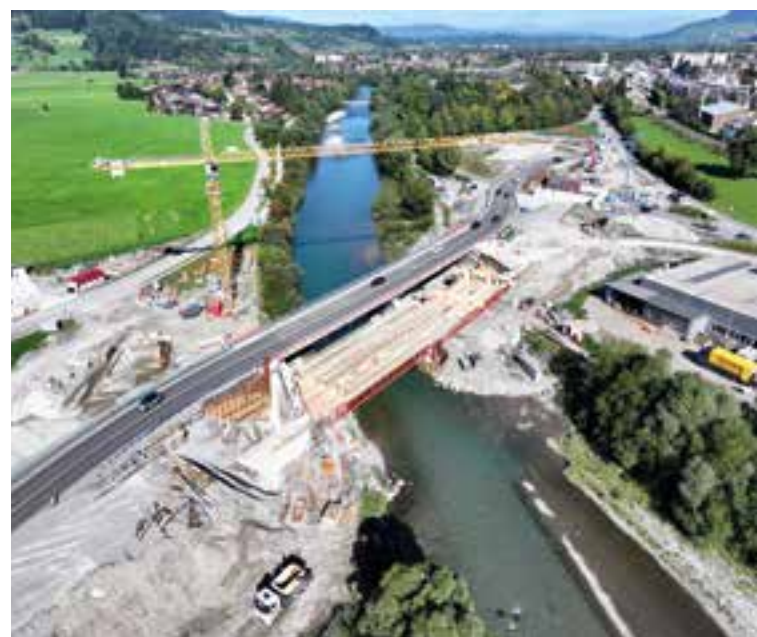
20 Schalungsbau am Überbau Ost © Dr. Schütz Ingenieure
