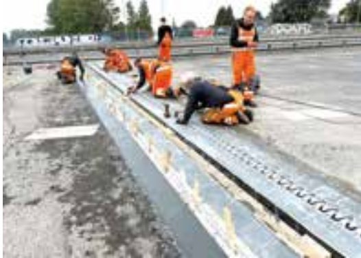
■ Zwei Übergangskonstruktionen nach Einbau © Maurer SE
