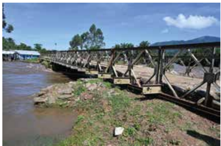
2 Baileybrücke über den Mweso bei Hochwasser: Sicht von Südosten © Andreas Galmarini
