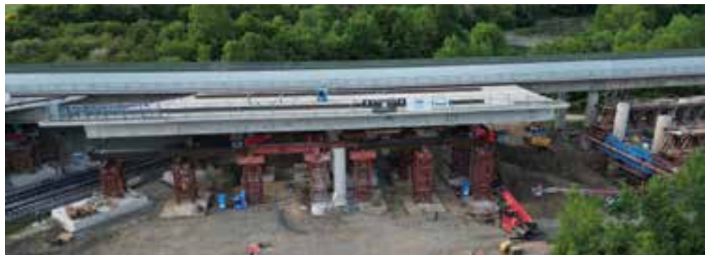
12 Verschiebung des Bahnfelds © Implenia Civil Engineering GmbH
