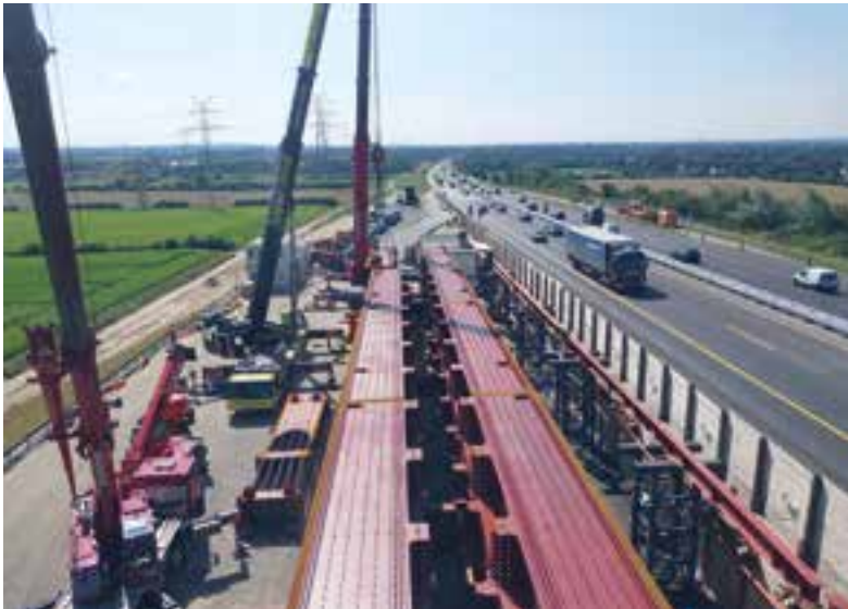
25 Hubmontage der Bauteile für Takt S 01 im Juli 2024 © Plauen Stahl Technologie GmbH
