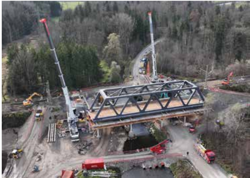
1 Fachwerküberbau in Behelfslage © Ing. Hans Bodner Baugesellschaft m.b.H. Co. KG
