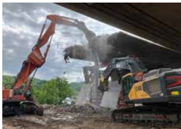
13 Abbruch des Bahnfelds mit Baggern © Implenia Civil Engineering GmbH
