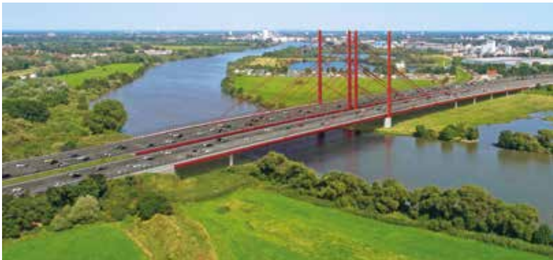
7 Beitrag 3: Schrägseilbrücke in Stahlverbundbauweise © Arup/explorations architecture
