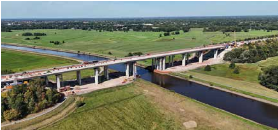
19 Huntebrücke mit eingeschobenem Überbau der ersten Richtungsfahrbahn in Endlage und Bestandsbauwerk (im Hintergrund) © Adam Hörnig Baugesellschaft mbH & Co. KG
