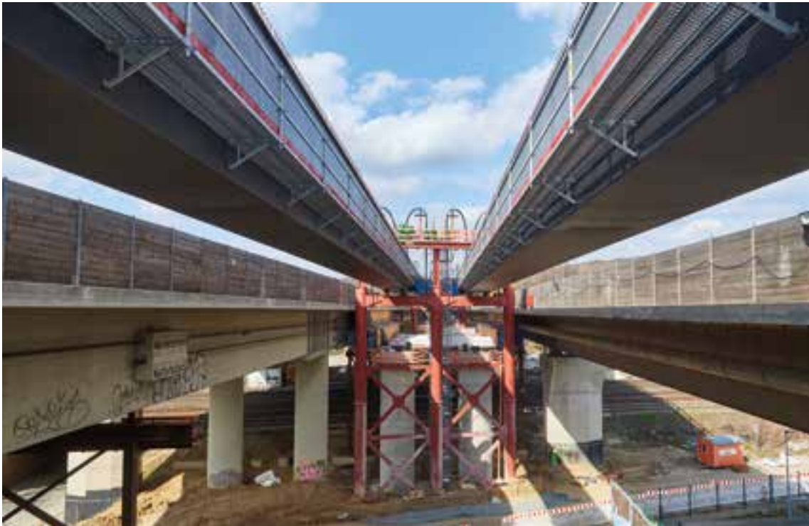
10 Schwelmetalbrücke in Längsrichtung © Hochtief Infrastructure GmbH
