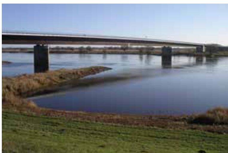
2 Bestehende Elbebrücke Wittenberge der B 189 © Leonhardt, Andrä und Partner AG
