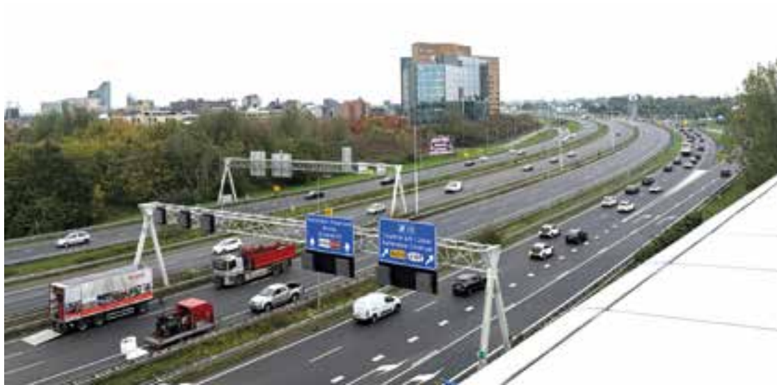
Zwölfspurige Brücke mit Viadukt s'-Gravenweg © Maurer SE
