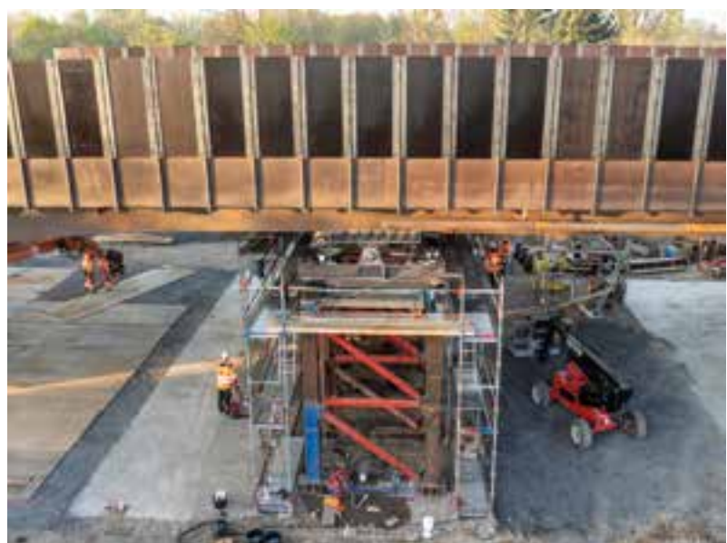
3 Wippenlager vor der Montage © Teupe-Gruppe
