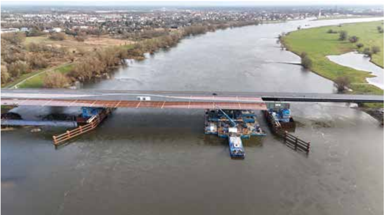
19 Pontonunterstützung beim Verschub über das Stromfeld © DSD Brückenbau GmbH
