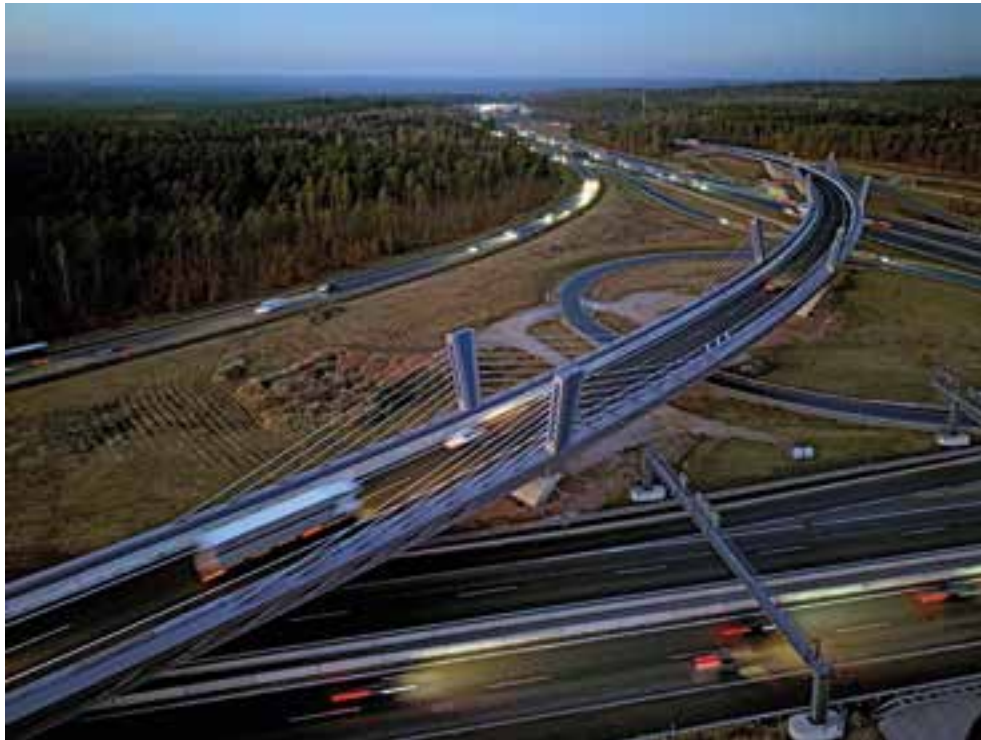
21 Komplexes Brückenbauwerk: Overfly unter Verkehr © Hajo Dietz
