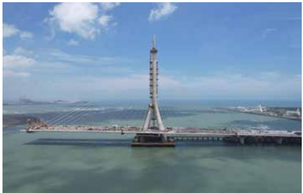
19 Freivorbau im Hauptfeld © KSECO
