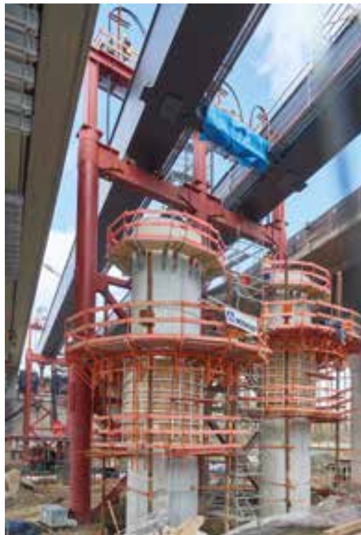
11 Pfeiler in Achse 30 nach dem Absenken © Hochtief Infrastructure GmbH
