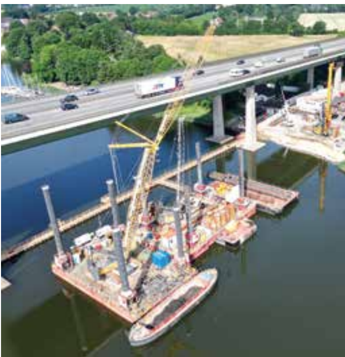
5 Pfahlherstellung auf Hubinsel © Implenia Civil Engineering GmbH
