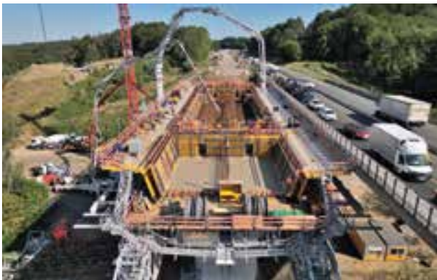
Betonage des Überbaus © Gebr. Echterhoff GmbH & Co. KG
