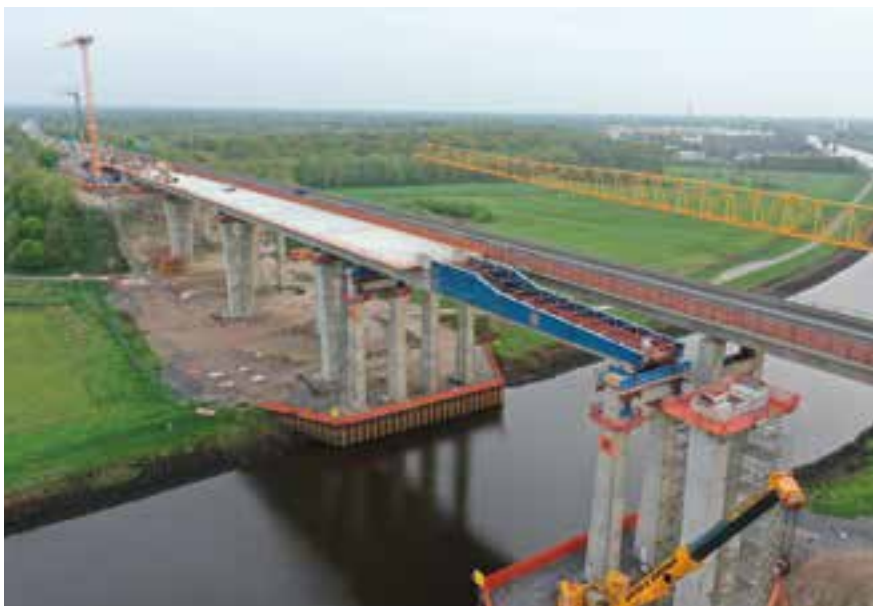
15 Herstellung Richtungsfahrbahn Wilhelmshaven: Zustand nach dem Auffahren des Vorbauschnabels auf die Bestandspfeilerachse A 5 © Adam Hörnig Baugesellschaft mbH & Co. KG
