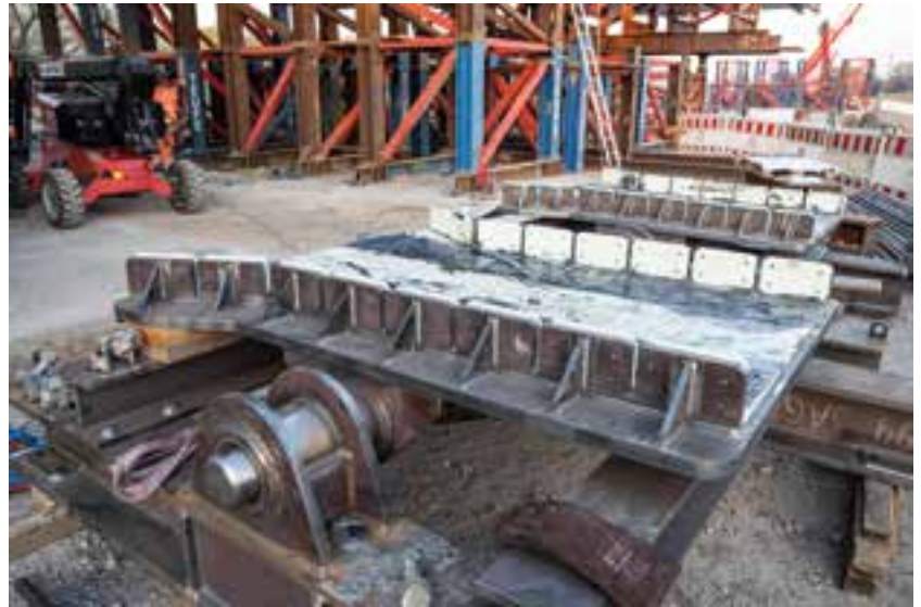
4 Beispielhafte Vershubachse unter Last mit Wippenlagern auf den Bati-Türmen © Teupe-Gruppe
