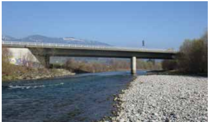
1 Gesamtansicht der Illerbrücke aus dem Jahr 1969 © Dr. Schütz Ingenieure
