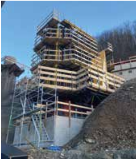
17 18 Herstellung der Pfeiler mit Schalung © Implenla Civil Engineering GmbH
