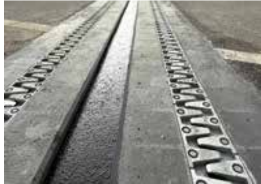
■ Geräuschminderung an der Oberseite noch ohne letzte Asphaltlage © Maurer SE
