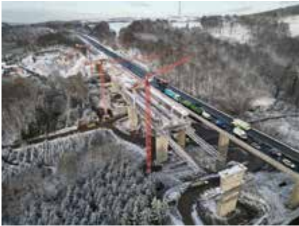
Bauzustände in den Jahren 2024 und 2025 © Gebr. Echterhoff GmbH & Co. KG
