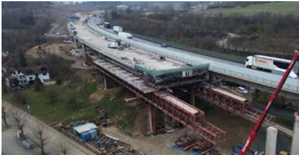
7 Abbruch mittels Vorschubrüstung © Implenja Civil Engineering GmbH
