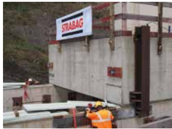
15 Verschubbahn mit Verschubwand und Seitenführung © Strabag AG
