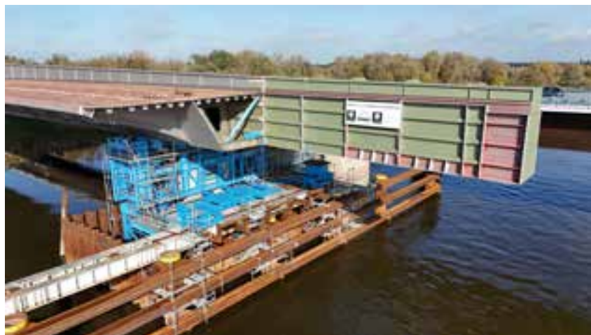
18 Gleicherte Überbauspitze und Verschublager am Strompfeiler © DSD Brückenbau GmbH
