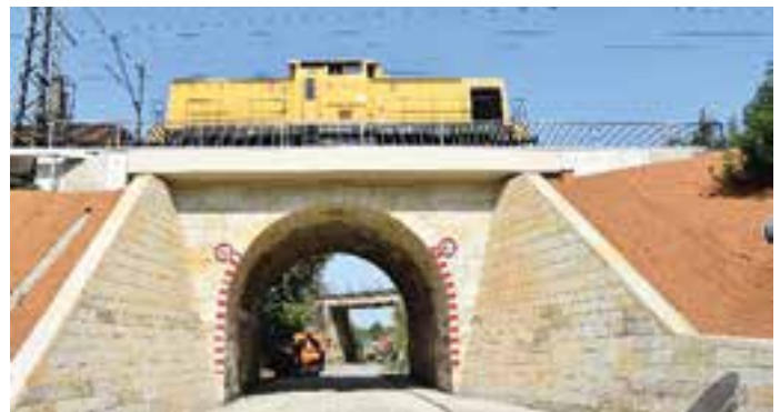
5 Gleiches Tragwerk nach der Instandsetzung und mit neuer Stahlbetonfahrbahnplatte © Rettberg GmbH
