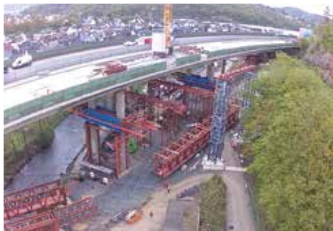
8 Montage der Vorschubrüstung © Implenja Civil Engineering GmbH
