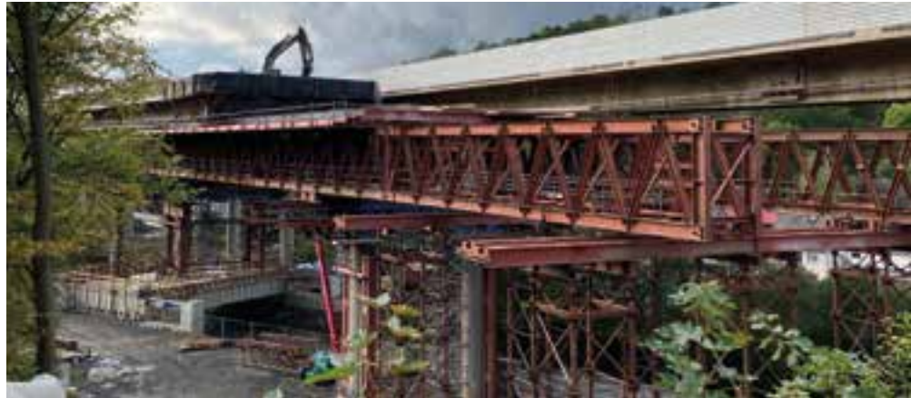
11 Abbruch: Vorschubrüstung im Einsatz © Implenia Civil Engineering GmbH
