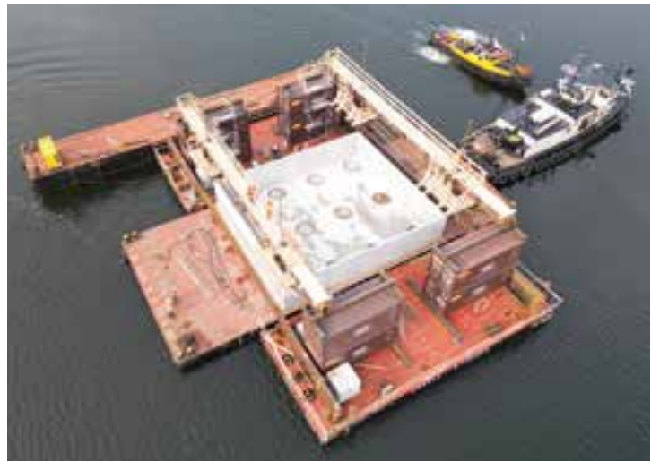
8 Katamaranponton mit Stahlbetonfertigteile © Implenia Civil Engineering GmbH
