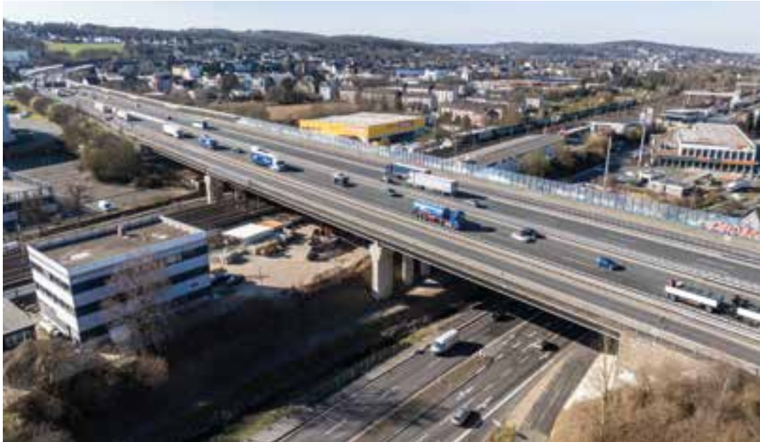
1 Luftbild der Schwelmetalbrücke © Hochtief Infrastructure GmbH
