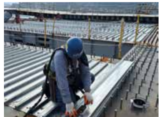
17 Schalung der Verbundplatte durch Stahltrapezbleche © KSECO
