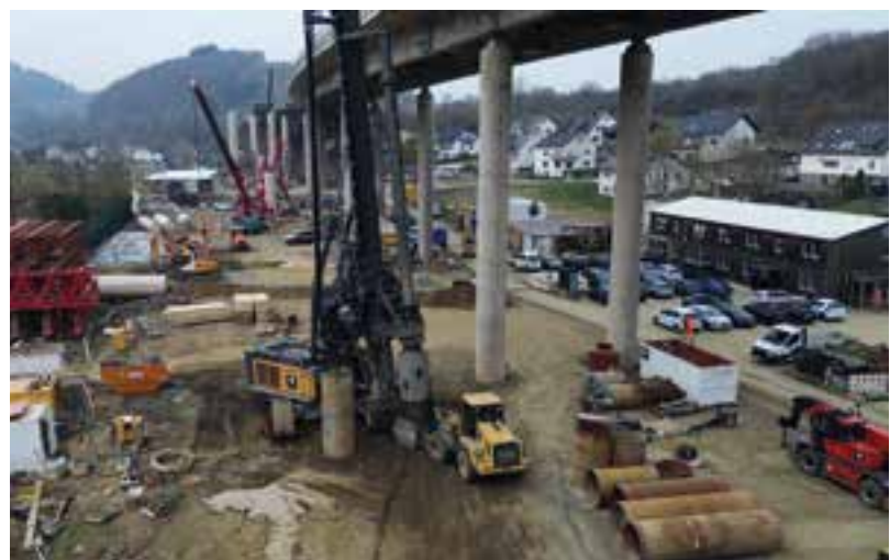
16 Herstellung der Großbohrpfähle © Implenia Civil Engineering GmbH
