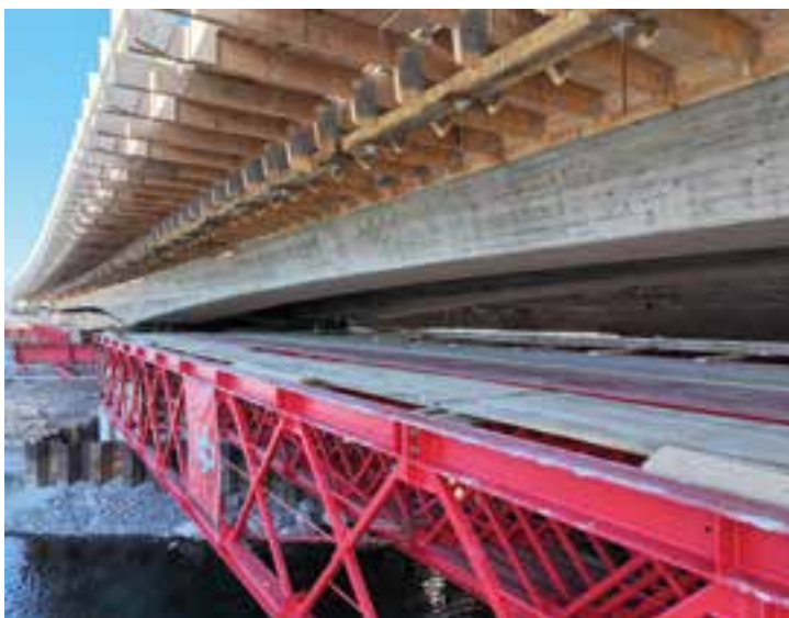
15 Überbau West nach Teilausschalung © Dr. Schütz Ingenieure
