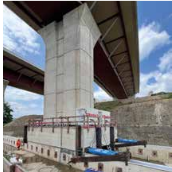
18 Pfeiler 20 mit Verschubbahn © Krebs+Kiefer Ingenieure GmbH
