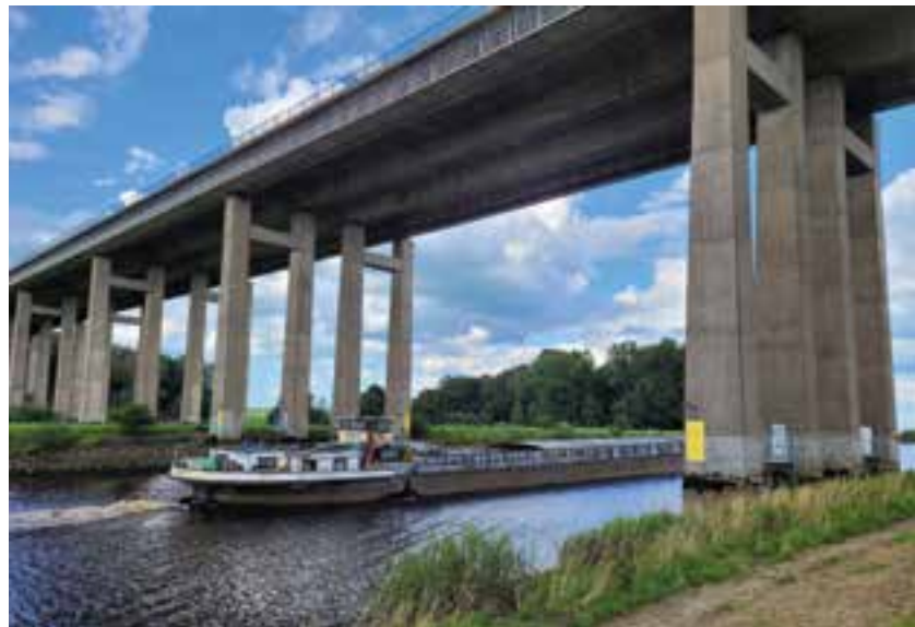
4 Bestandsbauwerk der Huntebrücke vor Beginn der Rückbauarbeiten © Adam Hörnig Baugesellschaft mbH & Co. KG
