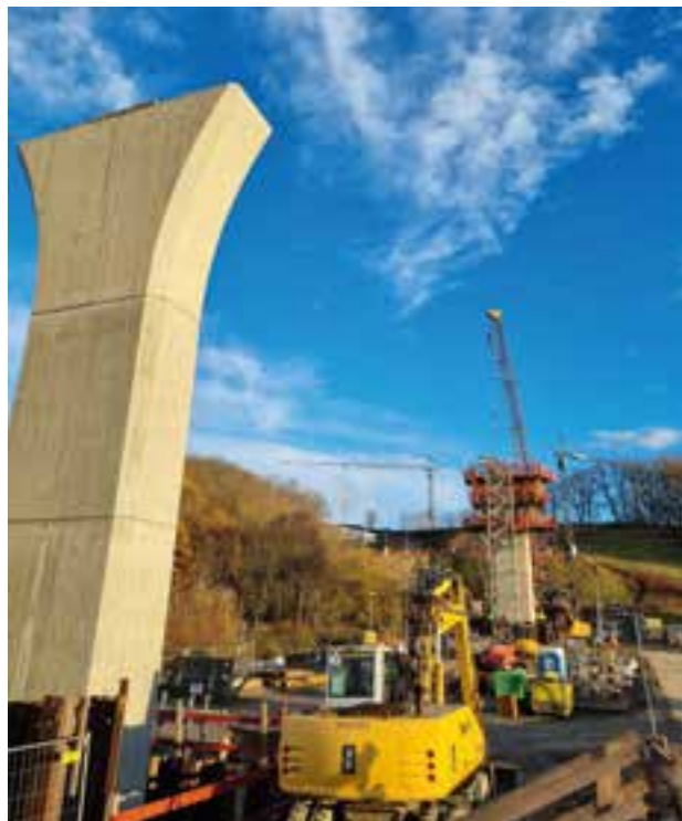
6 Pfeiler der Talbrücke Reisen im Bau © Hessen Mobil
