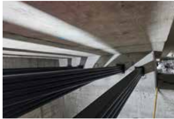
13 Externe verbundlose Bandspannglieder im Bündel © Adam Hörnig Baugesellschaft mbH & Co. KG
