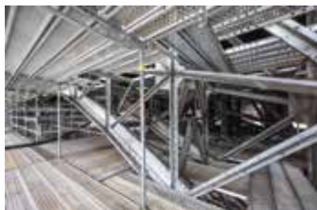
Durchgängigkeit auf allen Arbeitsebenen © Peri Vertrieb Deutschland GmbH & Co. KG
