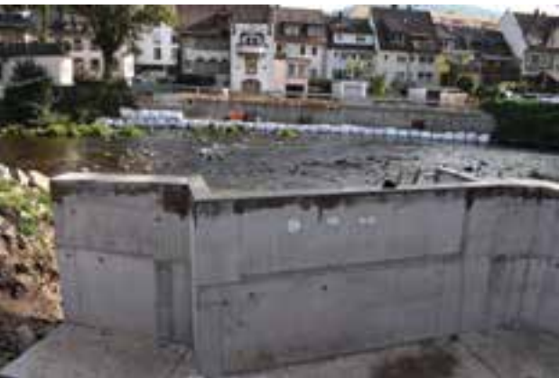
11 Errichtung der Widerlager © Weiß Beratende Ingenieure GmbH
