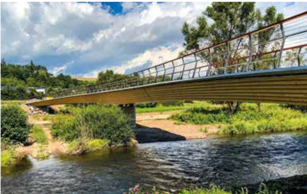
9 »Schwesterbrücke« aus doppelgekrümmten Blockträgern © Lukas Osterloff/Ingenieurbüro Miebach
