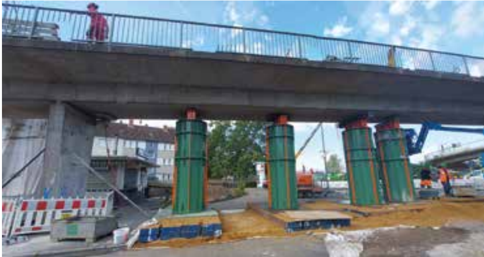
28 29 Rohrstützen und Stützentürme im Einsatz © BPR Dr. Schäpertöns Consult GmbH & Co. KG
