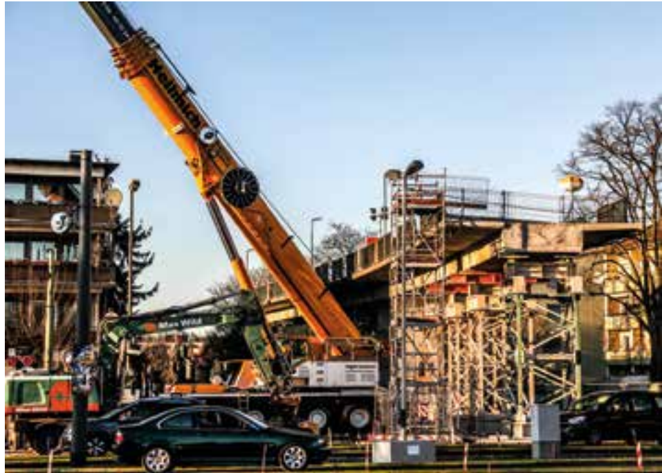
34 Brücke mit Gerüsten im Bereich der Hanauer Landstraße © BPR Dr. Schäpertöns Consult GmbH & Co. KG
