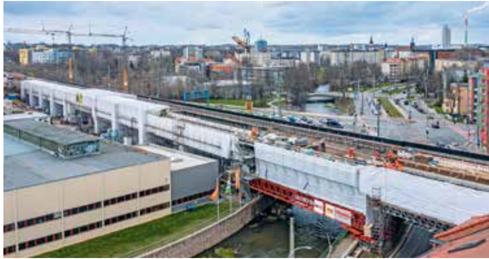
Einhausung der gesamten Flußquerung © Peri Vertrieb Deutschland GmbH & Co. KG
