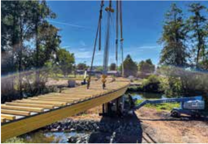
16 Montage der Brücke »Ederdorf« © Lukas Osterloff/Ingenieurbüro Miebach
