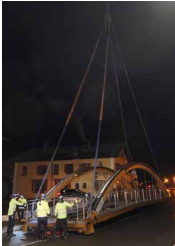
10 Einhub der vormontierten Brücke in Endlage © tragwerkstatt ZT gmbh
