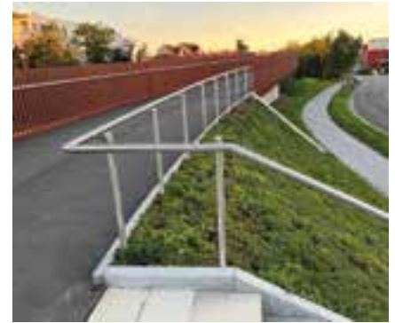
19 Detailsicht mit Treppenaufgang © Dr. Schütz Ingenieure
