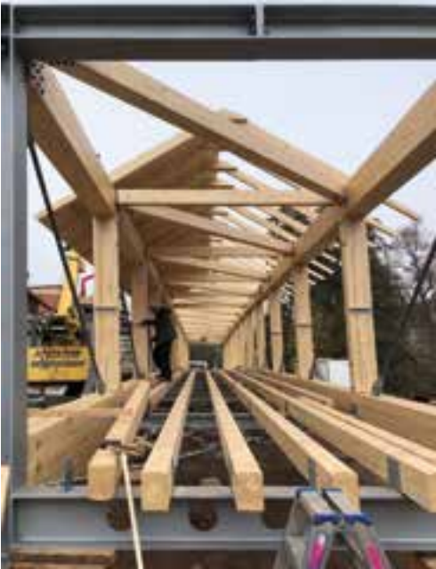
9 Vormontage direkt am Ufer © Holzbau Amman GmbH
