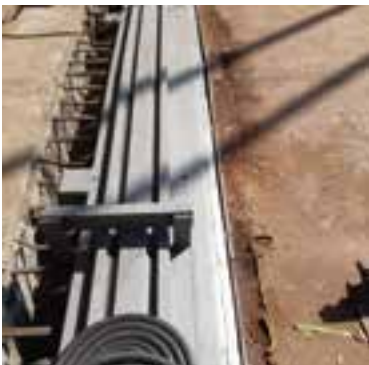
■ Austausch der Dehnfugen: Einbausituation und nach Fertigstellung der Fahrbahn © Maurer SE
