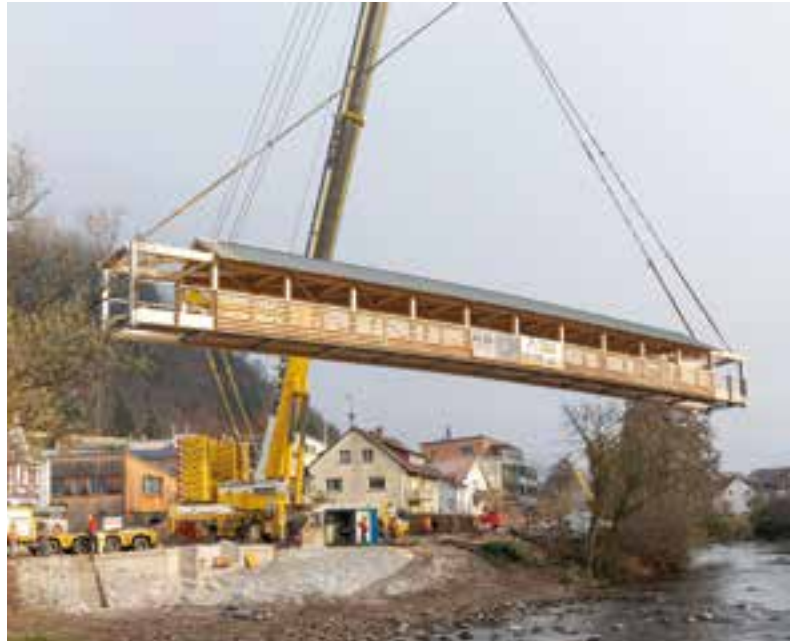
10 Mobilkraneinsatz: Einheben der Gesamtstruktur © Holzbau Amman GmbH
