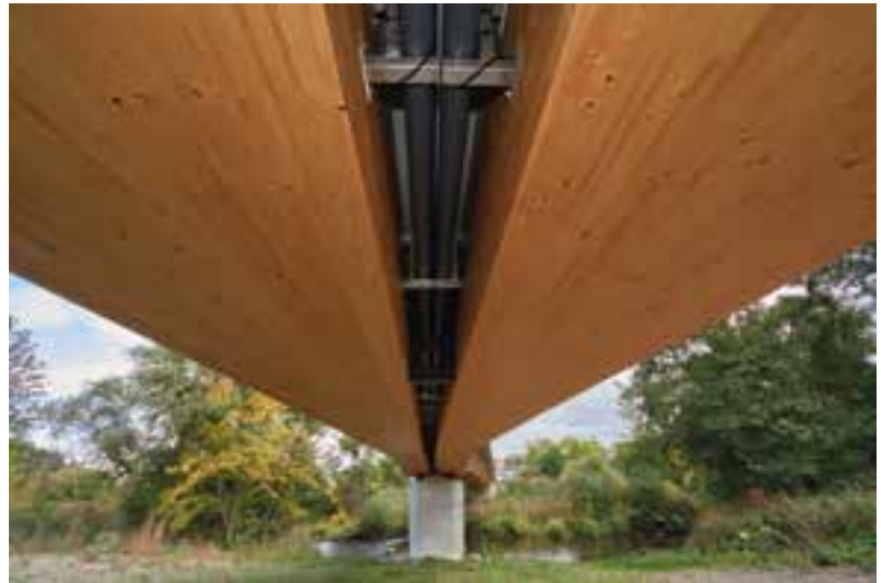
8 Unterseitiges Erscheinungsbild des Ersatzneubaus © Peter Beckmann/Ingenieurbüro Miebach
