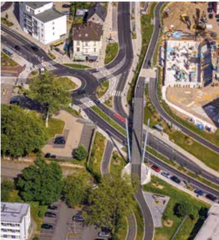
29 Luftbild der Brücke aus westlicher Richtung © www.imago-images.de
