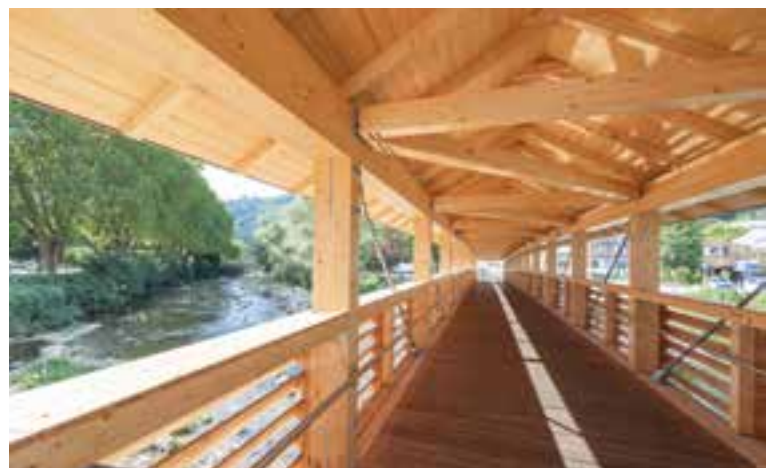
8 Holztragwerk mit Überdachung © Holzbau Amman GmbH
