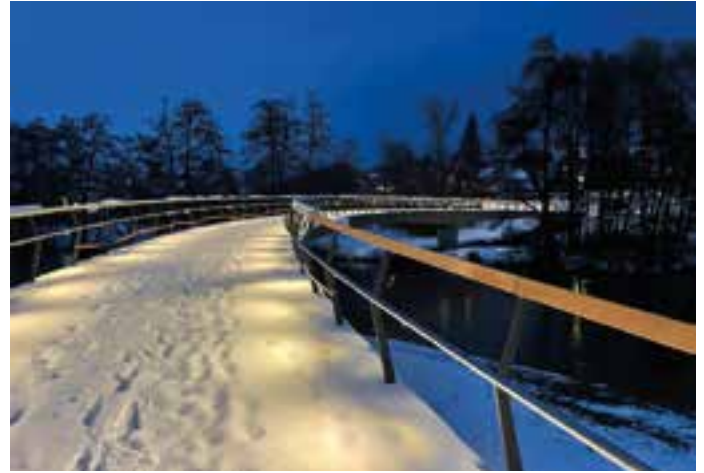
17 Tragstruktur noch vor Fertigstellung © Lukas Osterloff/Ingenieurbüro Miebach
