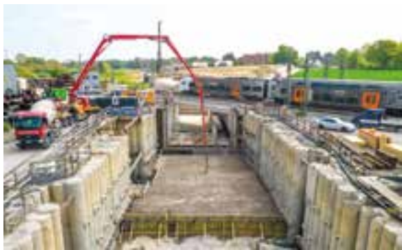
Betonage von Bodenplatte und Trogwänden © Gebr. Echterhoff GmbH & Co. KG
