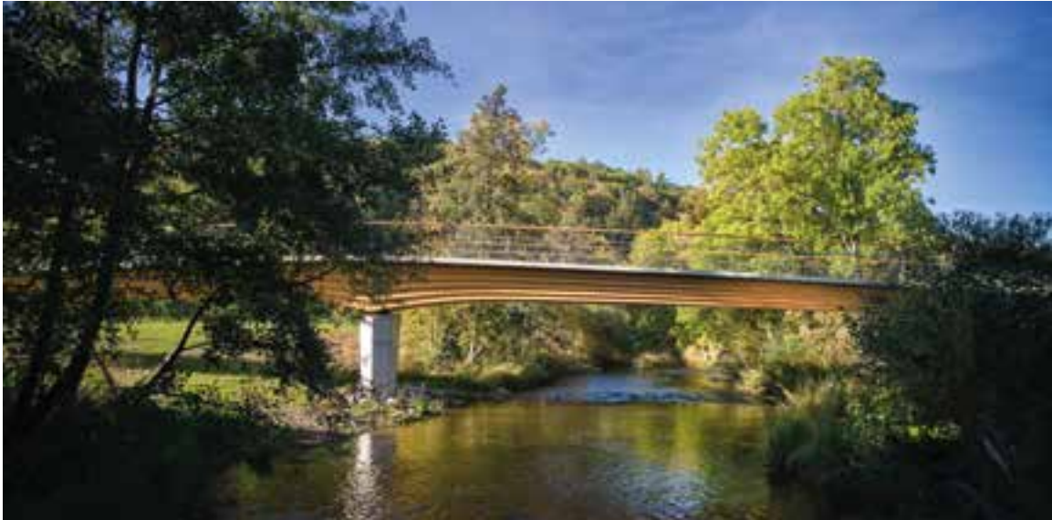
5 Zweifeldrige Flussquerung mit Mittelpfeiler © Peter Beckmann/Ingenieurbüro Miebach
