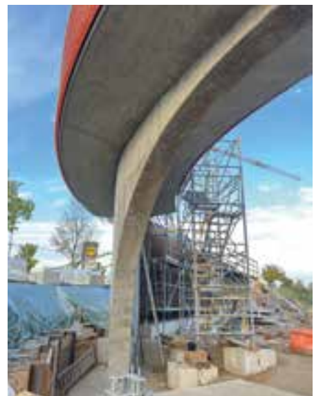
17 Bauzustand nach Fertigstellung des Rahmens © Dr. Schütz Ingenieure
