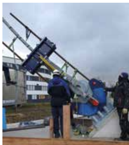
25 26 Vorspannen der Seile: Rückverankerung und Überbau © BPR Dr. Schäpertöns Consult GmbH & Co. KG
