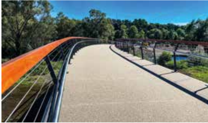
10 11 Betondeck und Geländergestaltung © Lukas Osterloff/Ingenieurbüro Miebach
