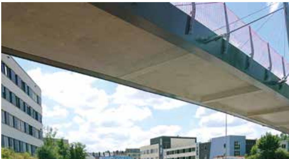
10 Unterseite der Brücke nach dem Ausschalen © BPR Dr. Schäpertöns Consult GmbH & Co. KG
