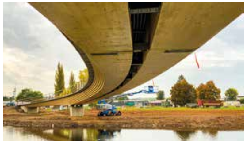
18 Ausformung des abgetreppten Überbaus © Lukas Osterloff/Ingenieurbüro Miebach
