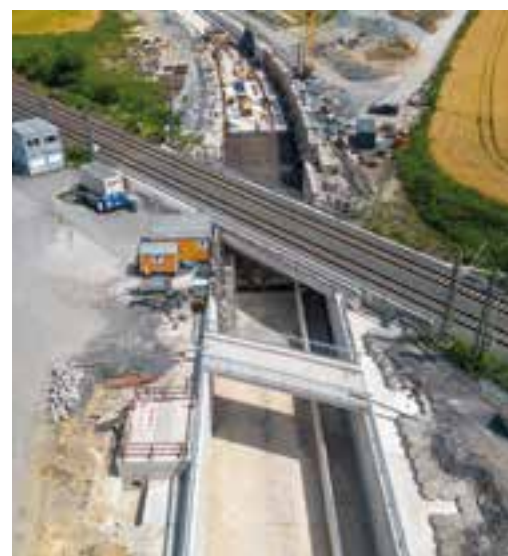
Fertiggestellter Trogabchnitt mit Brücke © Gebr. Echterhoff GmbH & Co. KG
