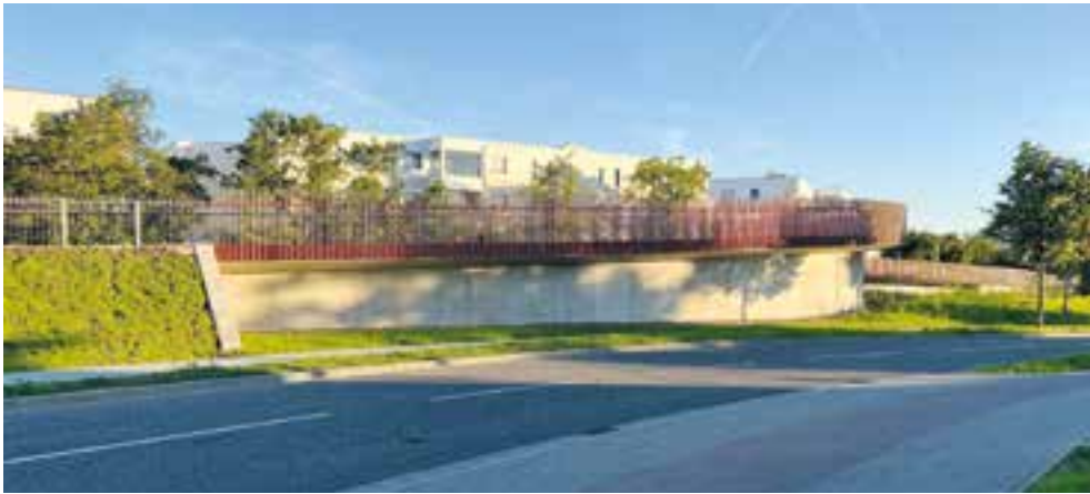
18 Rampe auf der Nordseite © Dr. Schütz Ingenieure
