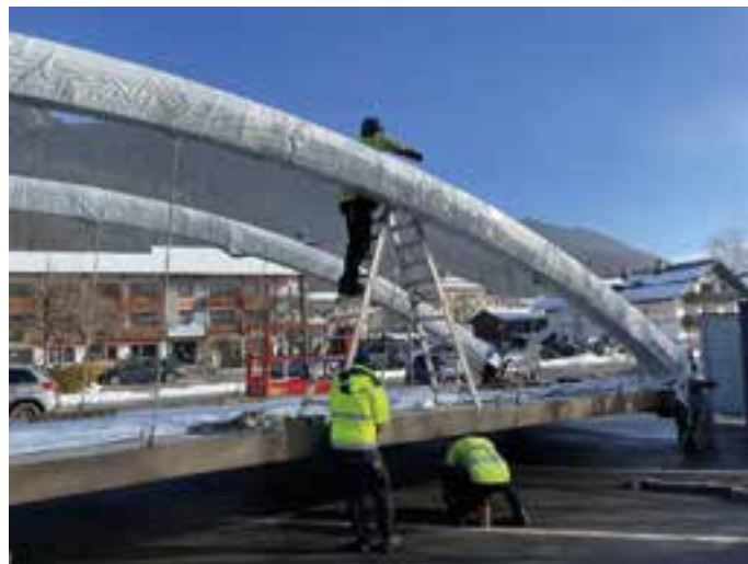
9 Montage von Bogen und Hänger © tragwerkstatt ZT gmbh
