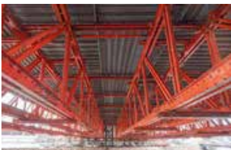
Überbrückungskonstruktion aus Fachwerkträgern © Peri Vertrieb Deutschland GmbH & Co. KG
