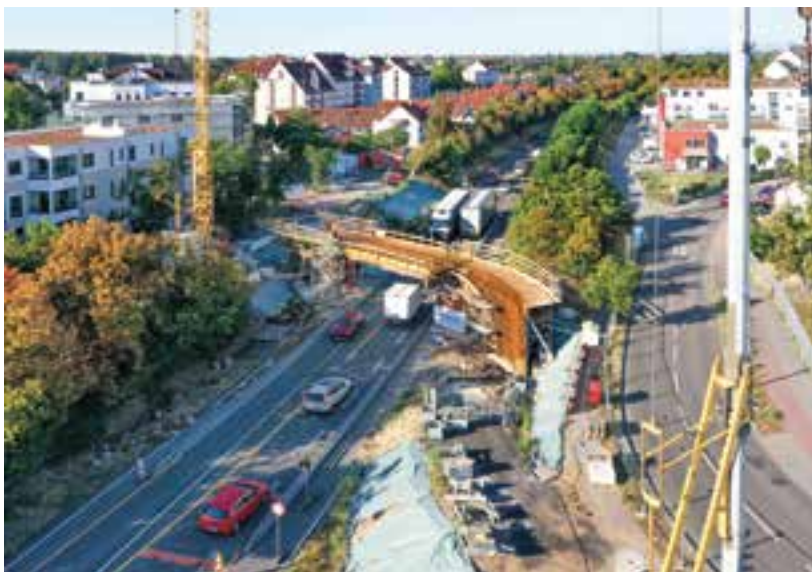
16 Einrichtung der Rahmenkonstruktion © Klaus Landry
