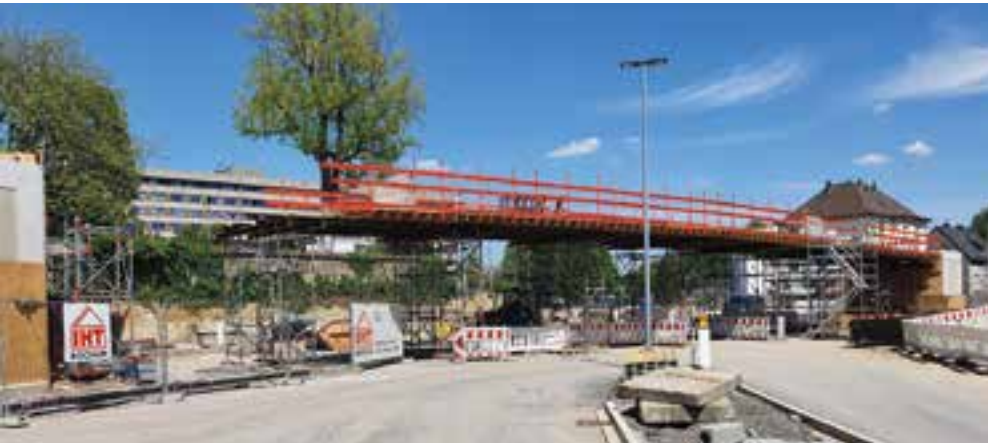
21 22 Errichtung des Traggerüsts sowie Stahl- und Schalungsbau © BPR Dr. Schäpertöns Consult GmbH & Co. KG
