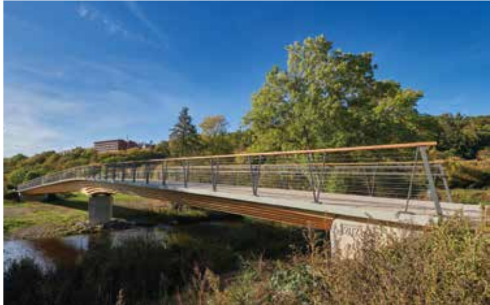
1 Geh- und Radwegbrücke »Wehrweide« als Kernelement des Verkehrskonzepts © Peter Beckmann/Ingenieurbüro Miebach
