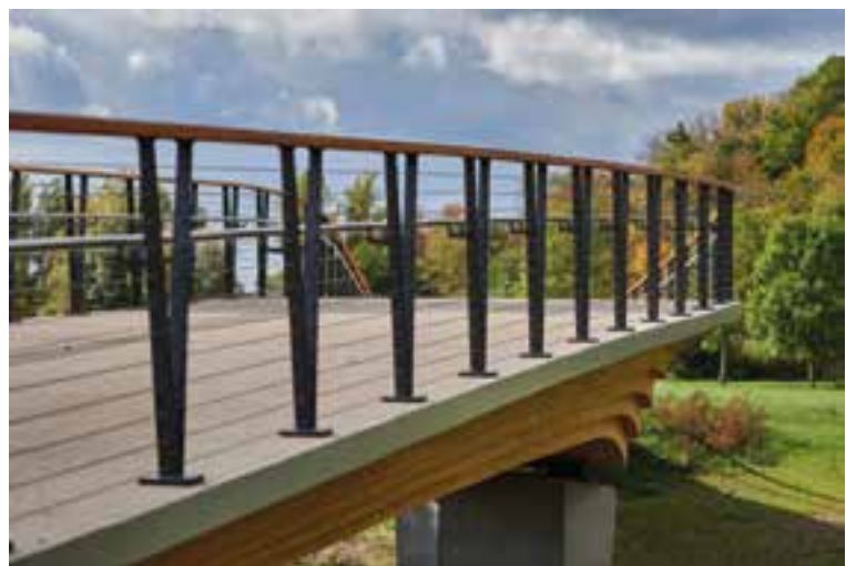
7 Fahrbahn und Einfassung © Peter Beckmann/Ingenieurbüro Miebach
