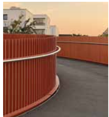
13 Geländer und Handlauf © Dr. Schütz Ingenieure
