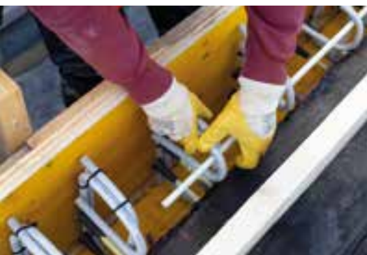
Einbau von Stäben und Bügeln aus glasfaserverstärktem Kunststoff © Schöck Bauteile GmbH
