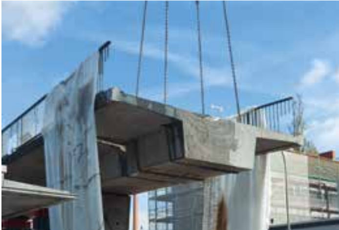
30 31 Ausheben und Abtransport abgetrennter Überbausegmente © BPR Dr. Schäpertöns Consult GmbH & Co. KG
