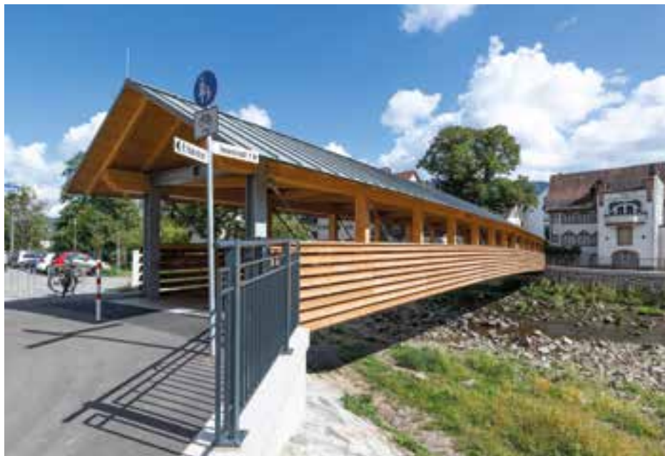
1 Heutige Querung als gedekte Holzfachwerkbrücke © Holzbau Amman GmbH
