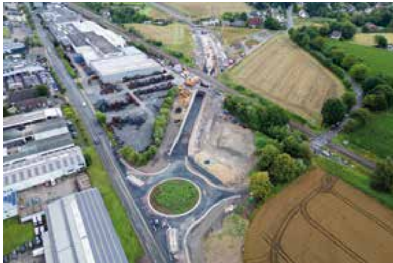
Alter Bahnübergang (rechts) und neue Streckenführung im Entstehen © Gebr. Echterhoff GmbH & Co. KG
