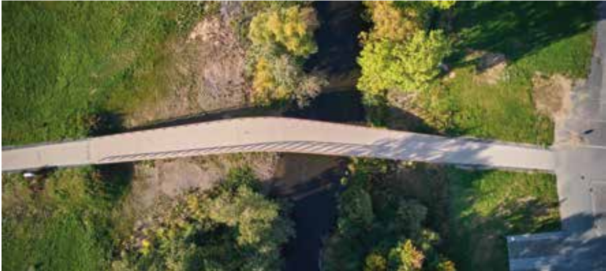
2 Baukörper aus der Vogelperspektive © Peter Beckmann/Ingenieurbüro Miebach
