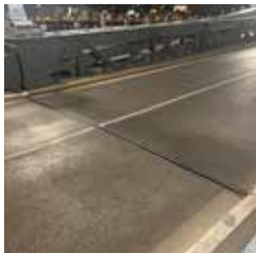
■ Austausch der Dehnfugen: Einbausituation und nach Fertigstellung der Fahrbahn © Maurer SE
