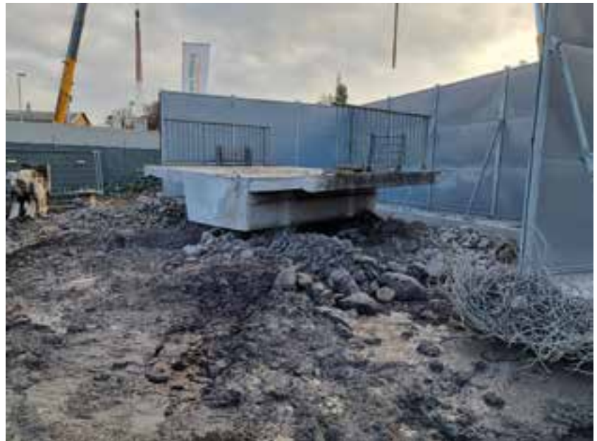
33 Überbaustück vor der Bearbeitung auf dem Zerlegeplatz © BPR Dr. Schäpertöns Consult GmbH & Co. KG
