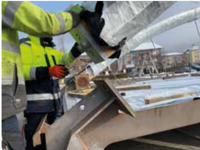
7 Bogenfußpunkt im Entstehen © Ingenieurbüro Höllige-Wind
