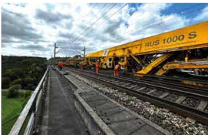
Einsatz von Spezialisten und verschiedenen Großgeräten © Swietelsky AG
