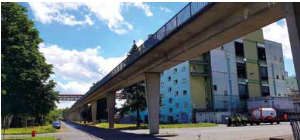
12 Casselabrücke im Bereich des Werksgeländes © BPR Dr. Schäpertöns Consult GmbH & Co. KG
