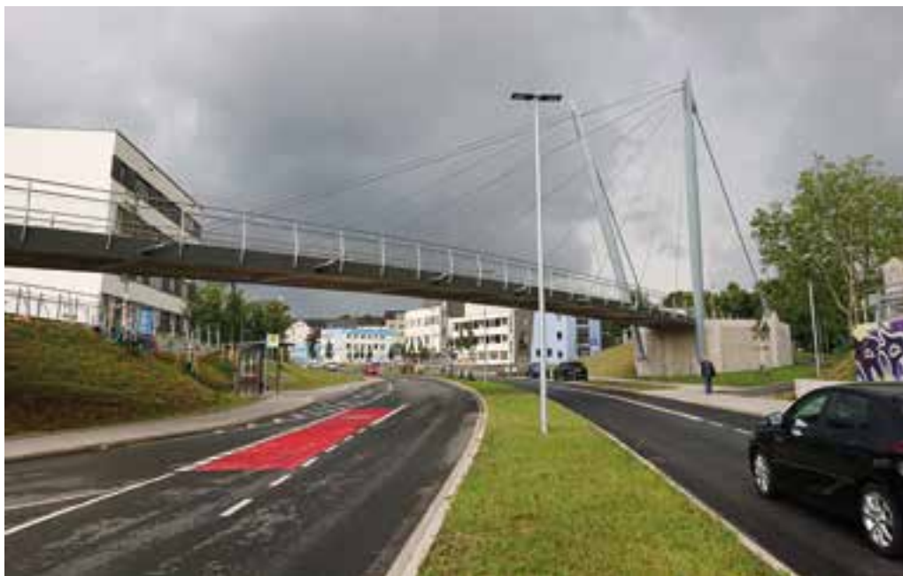
27 Erscheinungsbild des Bauwerks von Norden © BPR Dr. Schäpertöns Consult GmbH & Co. KG
