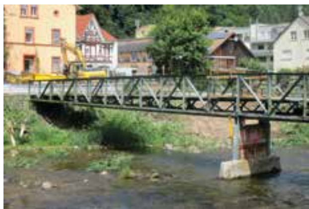
2 Vorgängerbau aus Stahl © Weiß Beratende Ingenieure GmbH
