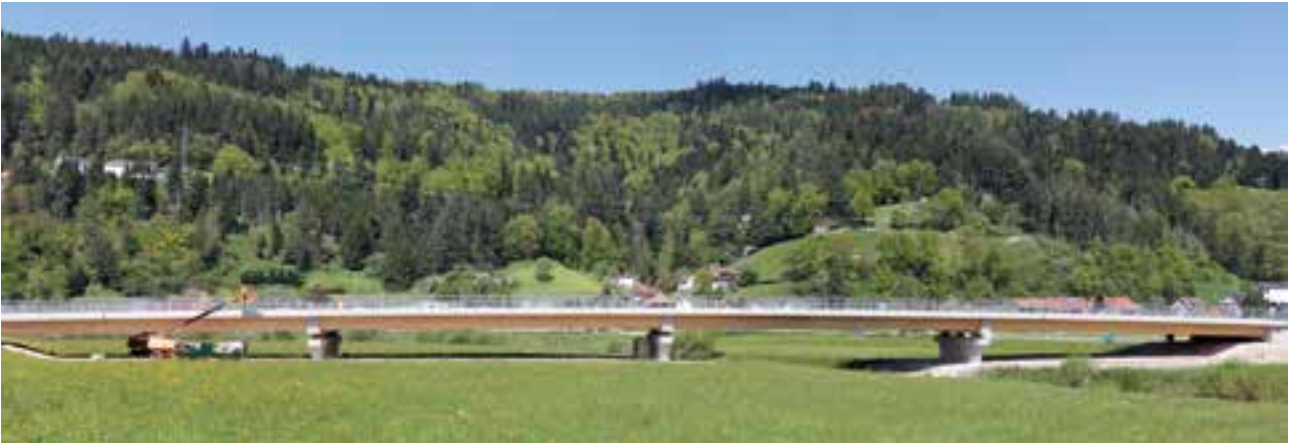
11 Gesamterscheinungsbild der neuen Kinzigbrücke © Conné van d'Grachten
