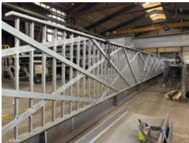
9 Fertigung der Rautenträger © Martin Sauerzapfe
