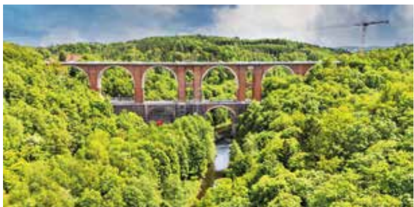
Elstertalbrücke von 1851 © DB InfraGO AG/Jürgen Findeisen
