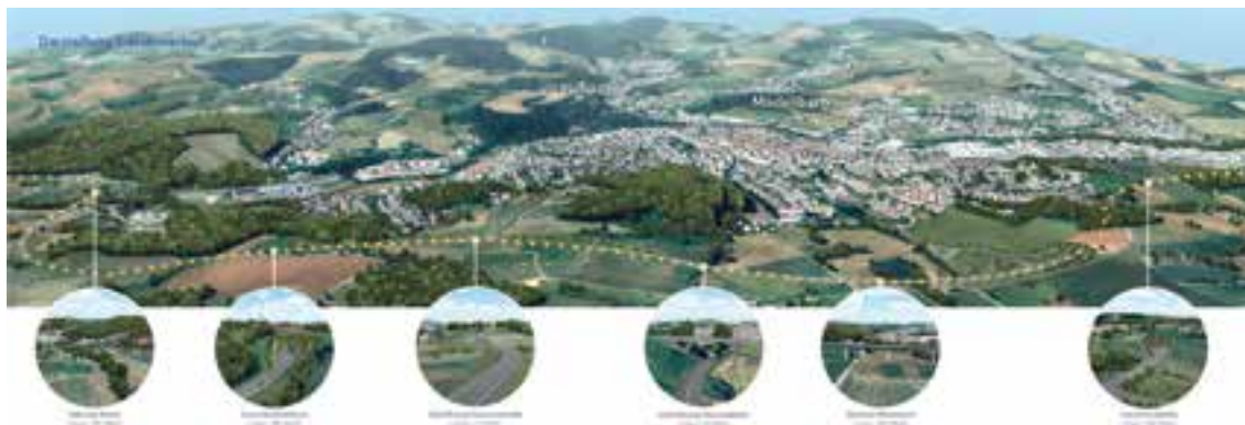
■ Brücken und Tunnel der Ortsumgehung Mörlenbach © Hessen Mobil
