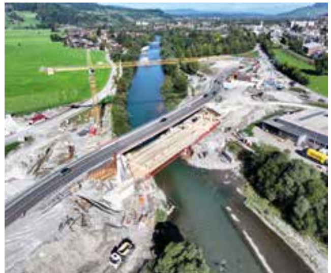
Erneuerung der Illerbrücke Sigishofen © Dr. Schütz Ingenieure
