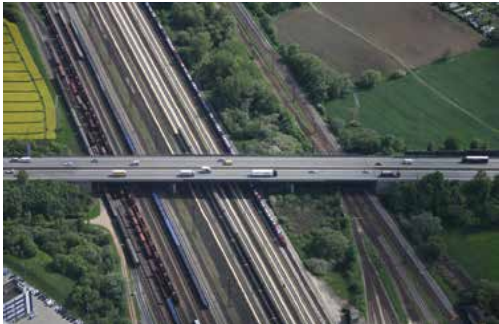
1 Luftbild von Süden von 2012 © Die Autobahn GmbH des Bundes
