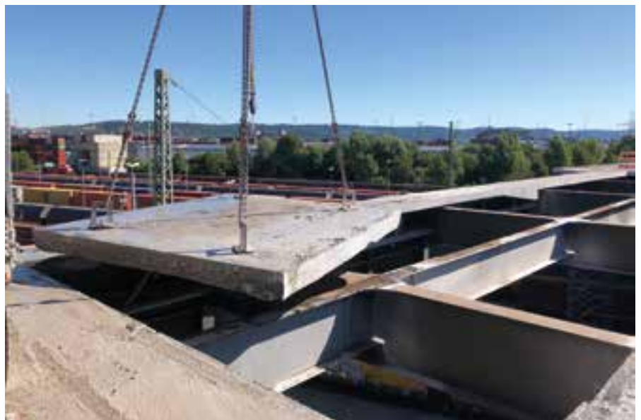
12 Teilrückbau der Fahrbahnplatte © Dr. Schütz Ingenieure
