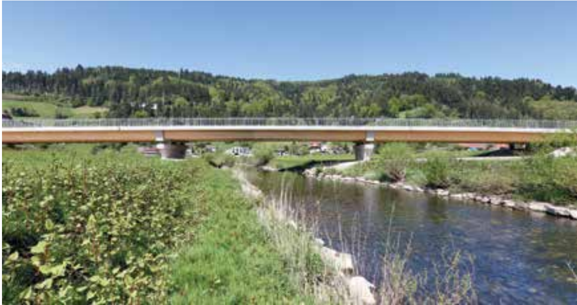
1 Holz-Beton-Verbundbrücke über die Kinzig nach Fertigstellung © Conné van d'Grachten
