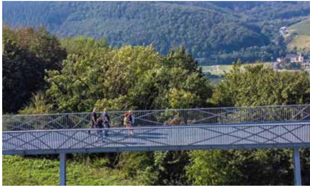
6 Rautenfachwerk im geraden Stegbereich © Christo Libuda/Lichtschwärmer
