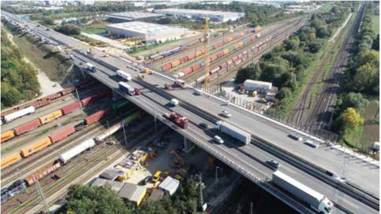
18 Luftbild des Ersatzneubaus kurz vor Fertigstellung © Dr. Schütz Ingenieure
