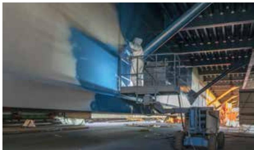
4 Hohe Flächenleistung mit Airless-Spritzen © M. Conrad/Sherwin-Williams Coatings Deutschland GmbH
