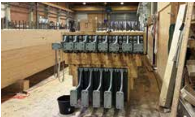
7 Vormontierte Stahlteile für den Querträgeranschluss © Ingenieurbüro Miebach
