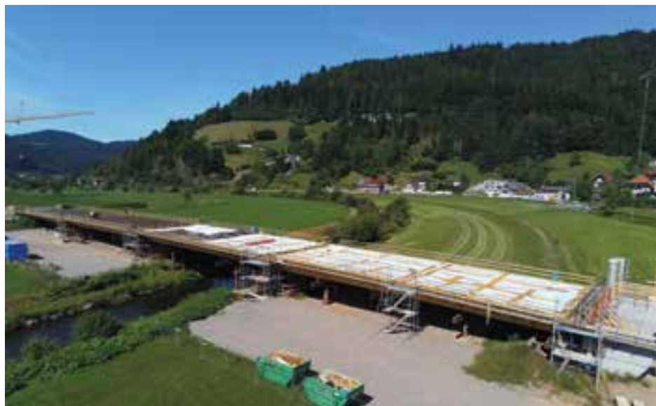
10 Bauphase: Herstellung des Querungsbauwerks © Ingenieurbüro Miebach
