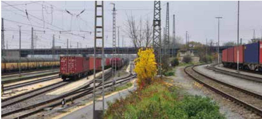
4 Bestand mit Oberleitungsanlagen © Dr. Schütz Ingenieure
