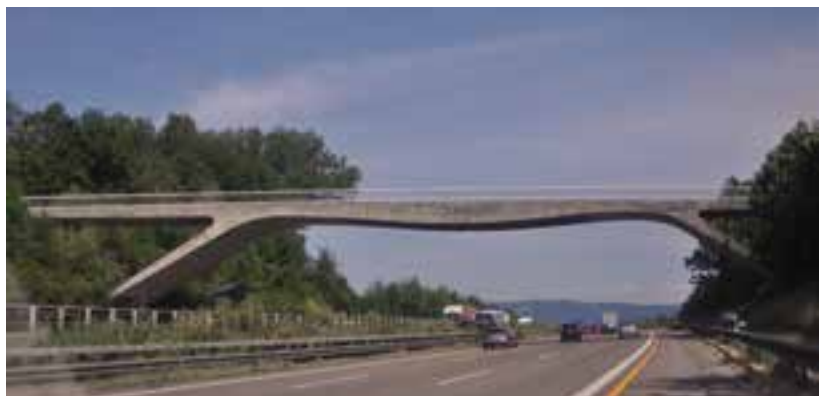
Überführungsbauwerk in Kirchheim unter Teck © Michael Kleiser
