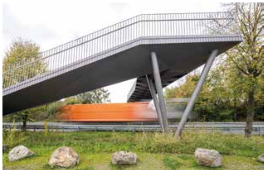
2 Untersicht von Treppenanlage und Überbau © Jörg Hempel
