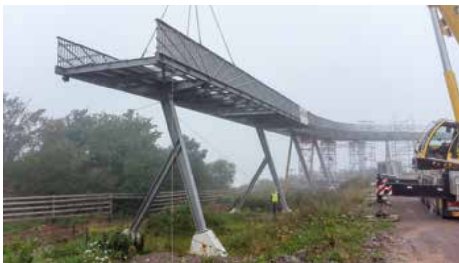
10 Montage im geraden Stegbereich auf Lambdastützen © Christo Libuda/Lichtschwärmer
