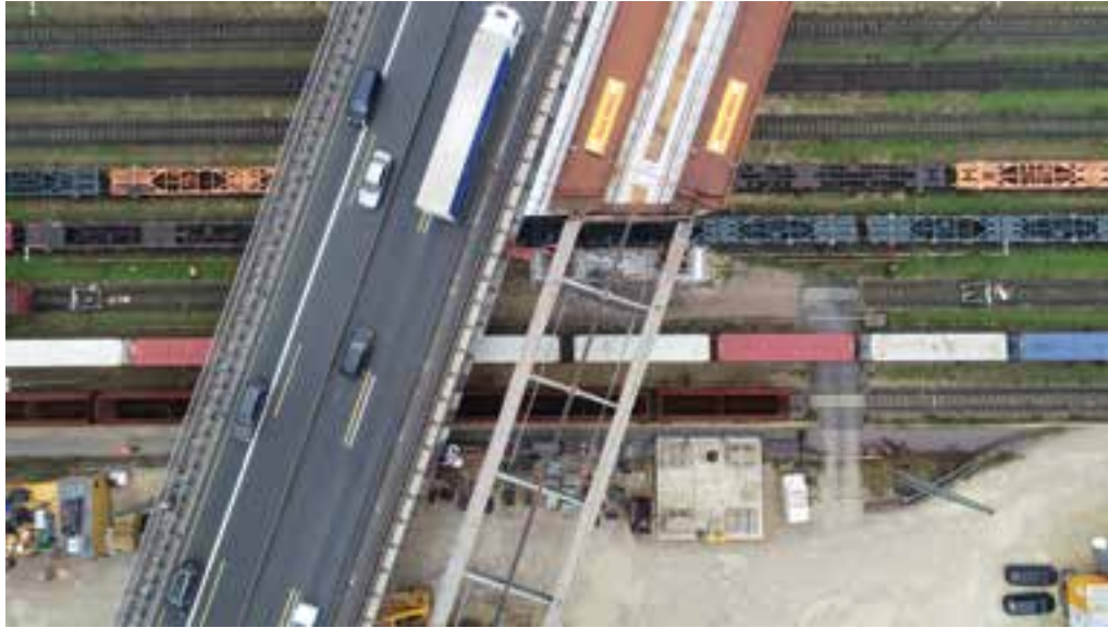
13 Geleicherter Bestandsüberbau und Koppelung mit neuem Stahlbau © Dr. Schütz Ingenieure
