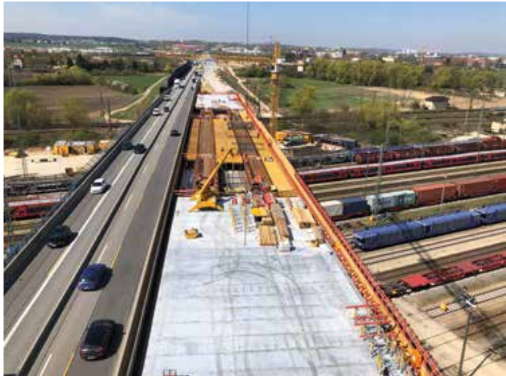
14 Abschnittsweise Herstellung der Fahrbahnplatte beim Überbau Nord © Dr. Schütz Ingenieure
