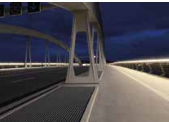
Waldschlösschenbrücke in Dresden mit beleuchtetem Handlauf © Husemann & Hücking Profile GmbH
