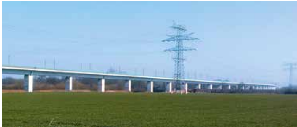
■ Saale-Elster-Talbrücke: Verfüllung mit haufwerksporigem Leichtbeton © Liapor GmbH & Co. KG
