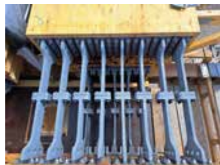
8 Gefügte Querträgeranschlüsse auf der Baustelle © Ingenieurbüro Miebach
