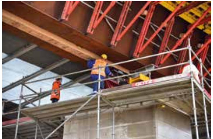
17 Vershubkonstruktion auf Pfeiler mit Höhenausgleich © Dr. Schütz Ingenieure
