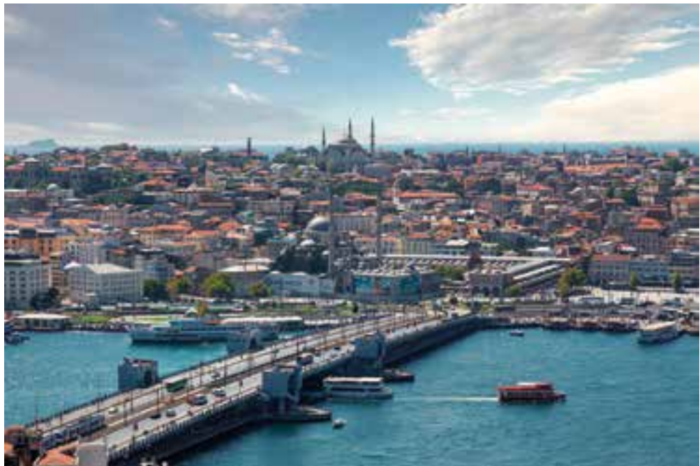
6 Galata-Brücke in Istanbul: keine Korrosionsschäden nach 33 Jahren © hasan/www.stock.adobe.com
