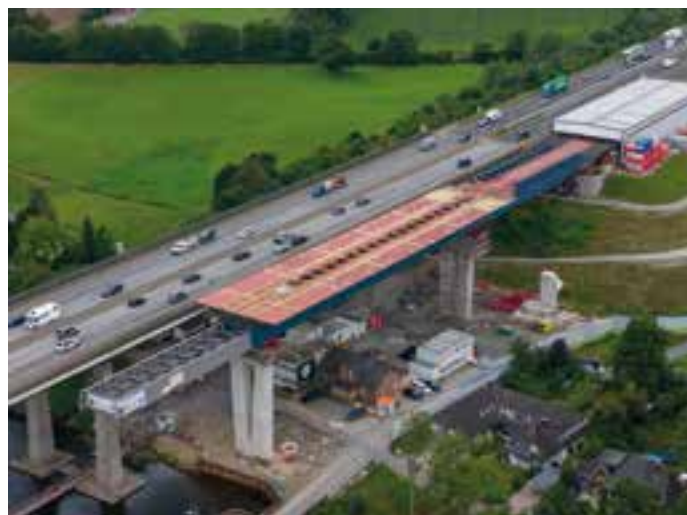
Errichtung der Rader Hochbrücke © DEGES GmbH
