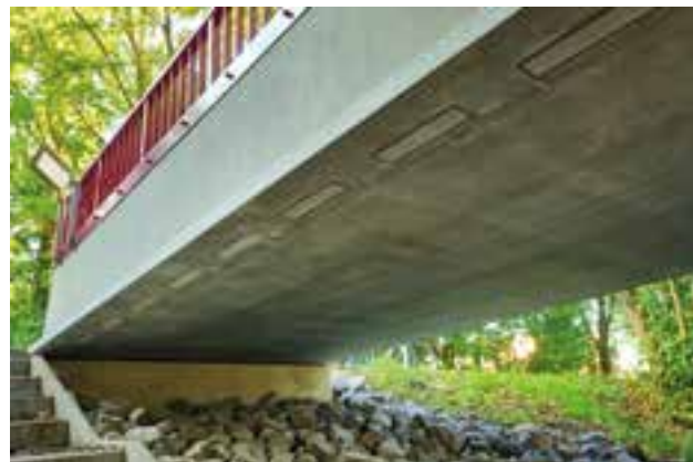
Unterseite des Überbaus © Holcim (Deutschland) GmbH
