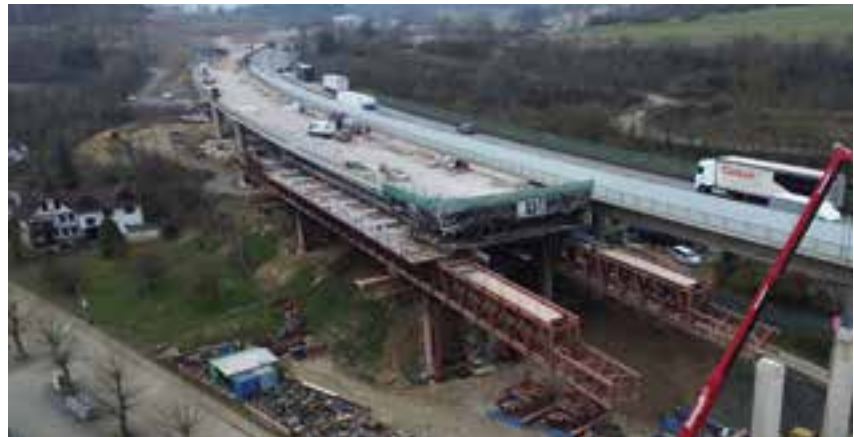
■ Abbruch und Neubau der Talbrücke Sechshelden © Implenja Civil Engineering GmbH
