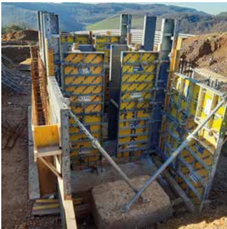
8 Bauzustand: Widerlager Nord © Landesbetrieb Mobilität Trier
