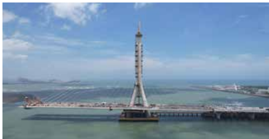
■ Freivorbau der Schrägseilbrücke Danjiang © KESCO
