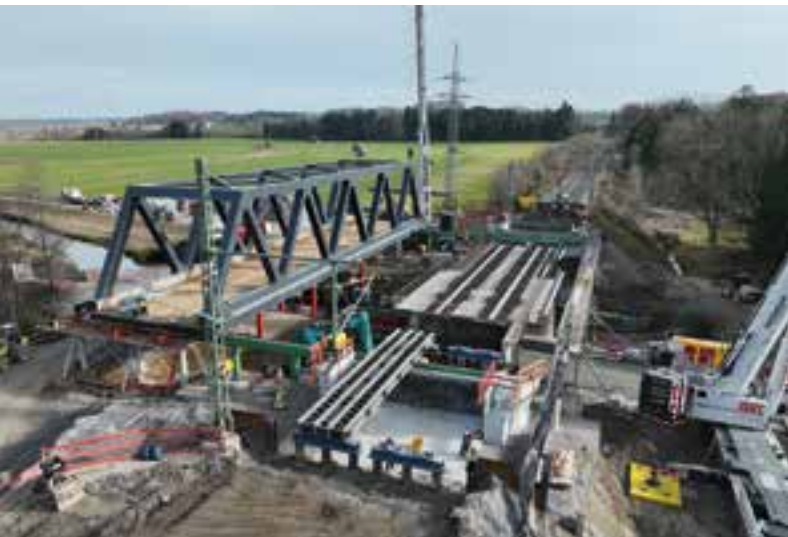
Eisenbahnüberführung über den Rothgraben © bulicek + ingenieure gmbH
