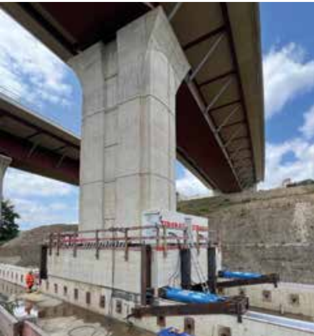
Querverschub der Talbrücke Rinsdorf © Ingenieurgemeinschaft Krebs + Kiefer/Meyer + Schubart
