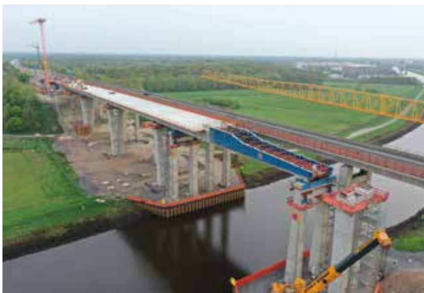
■ Herstellung der Huntebrücke bei Oldenburg © Adam Hörnig Baugesellschaft mbH & Co. KG/Büchting + Streit AG
