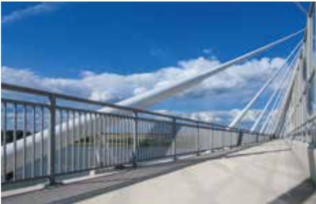
Handlaufprofile am Neubau der Leverkusener Rheinbrücke © Husemann & Hücking Profile GmbH
