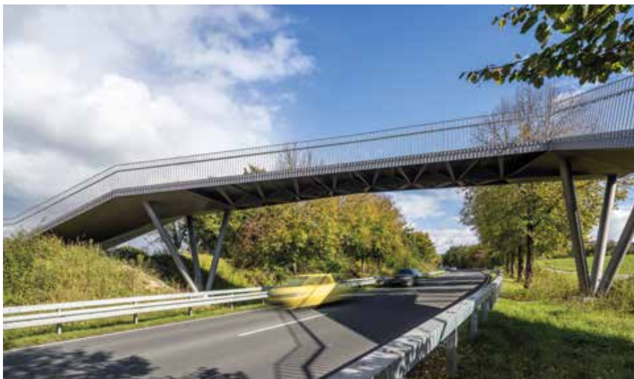
14 Geh- und Radwegbrücke über die Bundesstraße © Jörg Hempel
