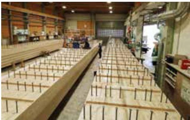
5 Vorfertigung des Blockträgers mit Kerben und eingeklebten Bewehrungsankern © Ingenieurbüro Miebach
