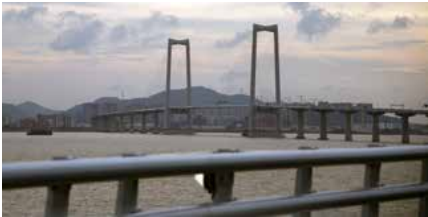
Hauptbrücke des ShenZhong Link © Pulsarwind/www.wikimedia.org
