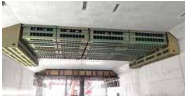
■ Bau eines Lärmschutztunnels im Zuge der A 81 © Meva Schalungs-Systeme GmbH
