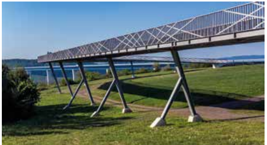
4 Rautenfachwerk als Tragstruktur © Christo Libuda/Lichtschwärmer
