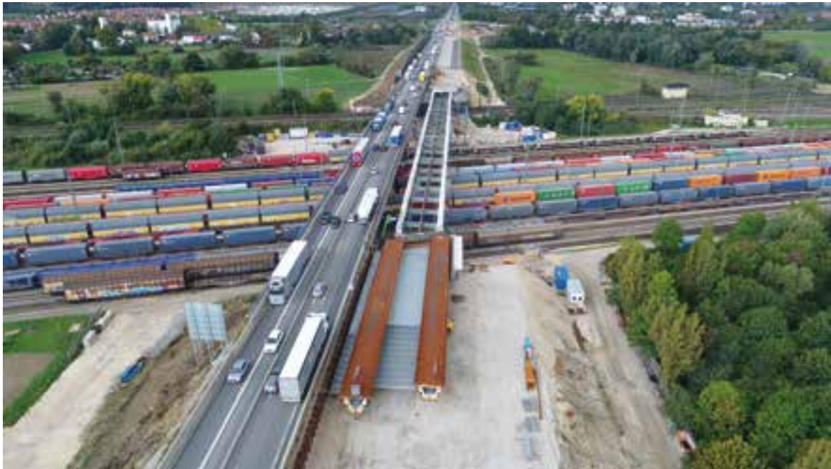
15 Luftbild von Längsvershub und Koppelstelle © Dr. Schütz Ingenieure
