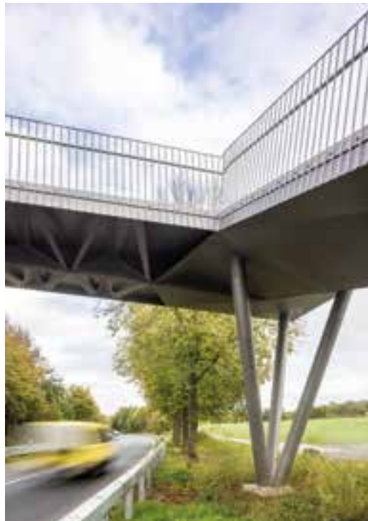
3 Stahlstützen aus baumartig aufgefächerten Rundrohren © Jörg Hempel
