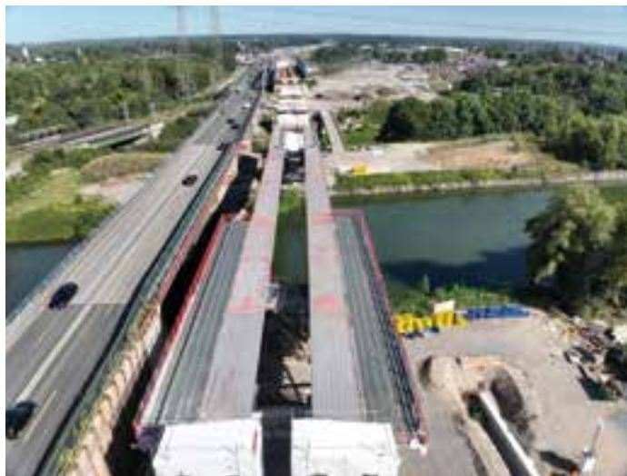
Emschertalbrückenzug noch im Bauzustand © Schüßler-Plan Ingenieurgesellschaft mbH
