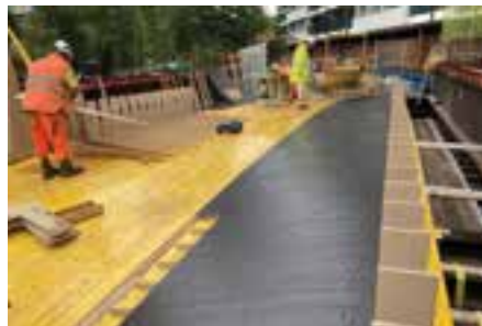
■ Errichtung einer Sichtbeton-Fußgängerbrücke in Basel © A. Looser
