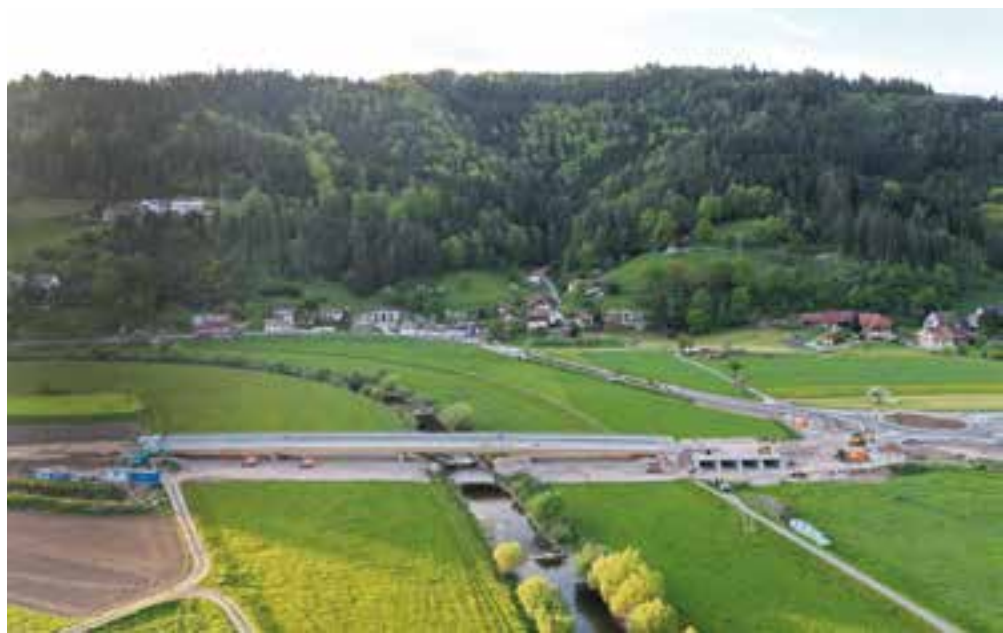
2 Errichtung des Bauwerks im Zuge der neuen K 5357 zwischen Haslach und Fischerbach © Conné van d'Grachten
