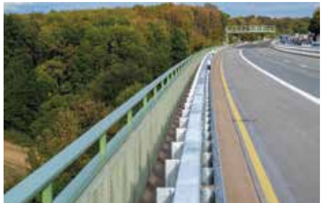
Standardprofile bei einer Brückensanierung nahe Dortmund © Husemann & Hücking Profile GmbH
