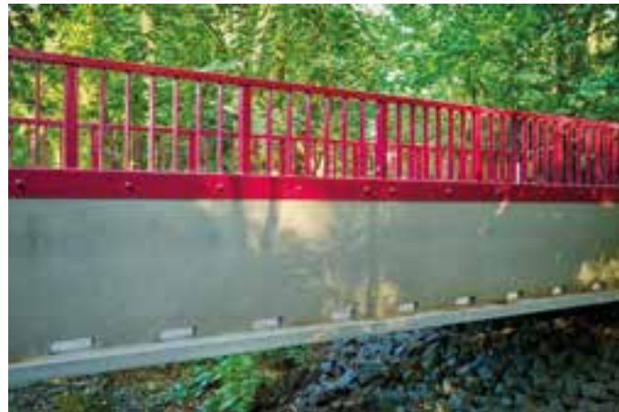
Bahndammgrabenquerung nach Fertigstellung © Holcim (Deutschland) GmbH
