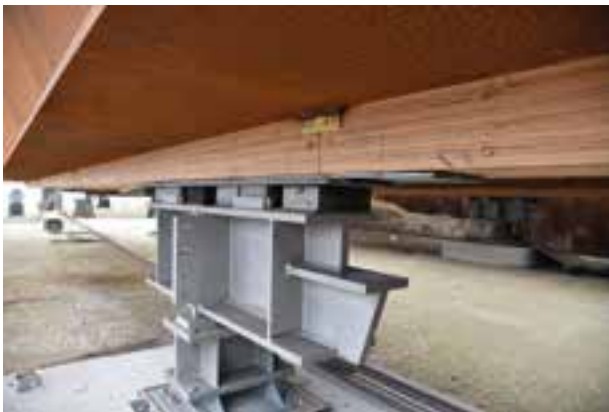
16 Vershubkonstruktion im Taktkeller © Dr. Schütz Ingenieure
