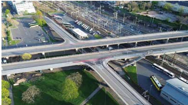
Individualisierte Lösung zur kostengünstigen Überwachung © Fraunhofer IKTS
