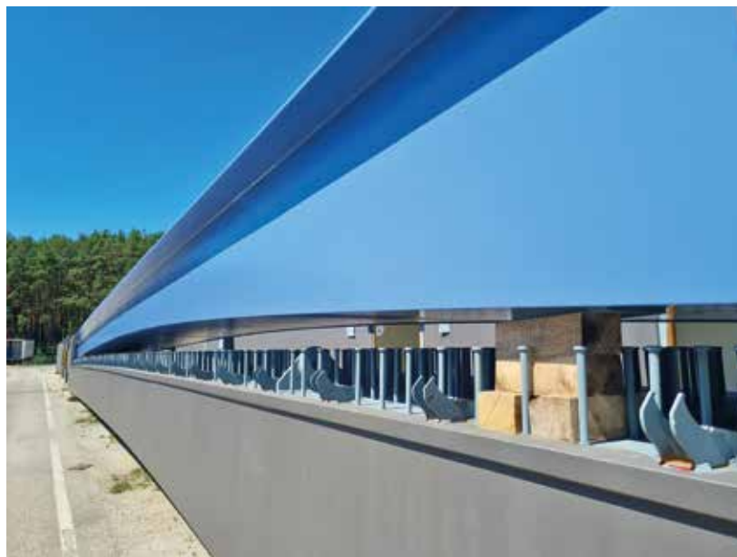
Stahlverbundträger von Konrad-Adenauer-Brücke und Westhofener Kreuz © Geholit + Wiemer Lack- und Kunststoff-Chemie GmbH
