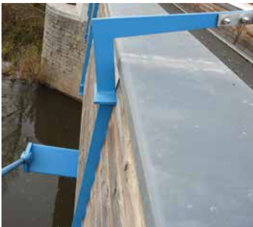
7 8 Seitliche Verschaltung und oberseitige Blechabdeckung an einer Trogbrücke (links) und einer Bogenbrücke (rechts) © Johannes Koch
