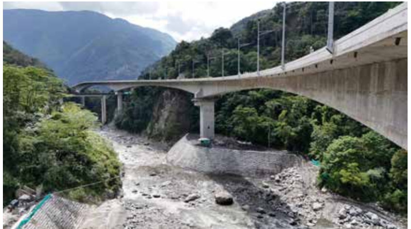
Neue K58-Brücke im Zuge der Staatsstraße von Bogotá nach Villavicencio © Maurer SE
