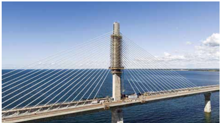
■ Pylon der Neuen Storstrøm-Brücke (noch) im Bau © SBJV
