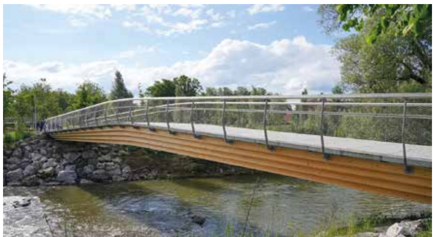
4 Blockträgerbrücke »Elsbeth-Fueg« in Wangen © Schaffitzel Holzindustrie GmbH & Co. KG
