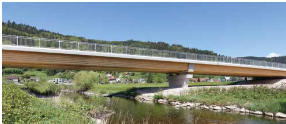
6 Holz-Beton-Verbundbrücke über die Kinzig © Conne van d' Grachten/Ingenieurbüro Miebach
