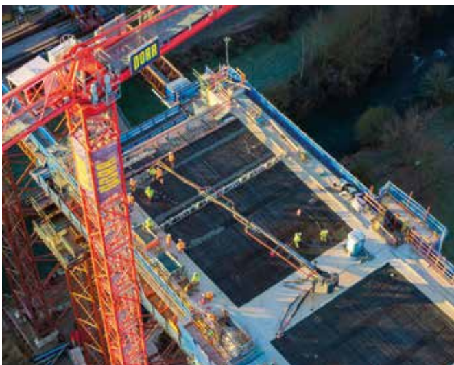
Präzisionsarbeiten in sehr großer Höhe © Porr GmbH & Co. KGaA
