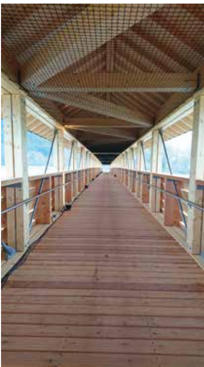
3 Kinzigsteg bei Steinach © Strab Ingenieurholzbau Hermsdorf GmbH
