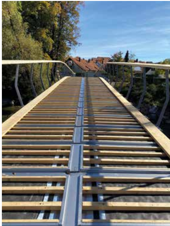
5 Elsbeth-Fueg-Brücke: Rinnen zur Wasserableitung unter der Belageebene © Schaffitzel Holzindustrie GmbH & Co. KG
