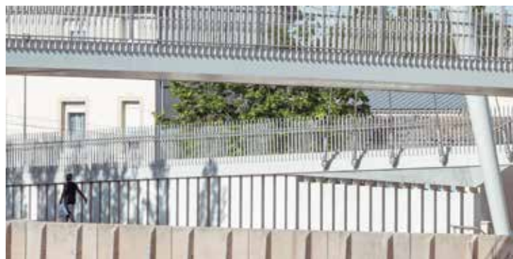
11 Geländerkonstruktion mit klarer Linienführung © Corentin Haubruge
