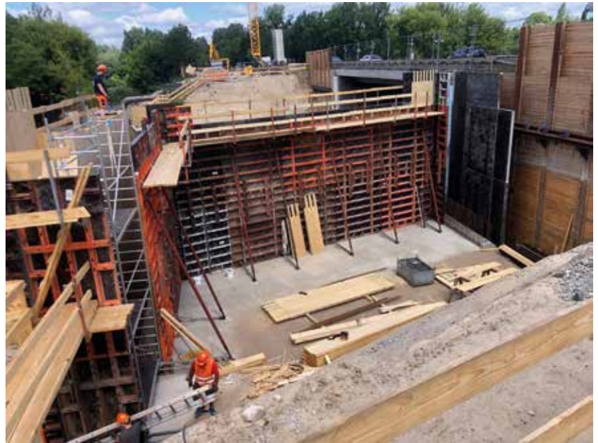
Widerlagerschalung im Einsatz © Paschal-Werk G. Maier GmbH
