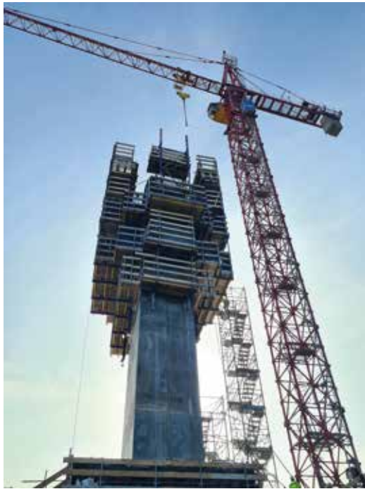
Selbstkletterschalungen zur sicheren und effizienten Herstellung des Pylons © SBJV
