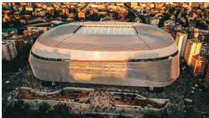
Heutiges Erscheinungsbild des Bauwerks © pexels/Caio Cezar
