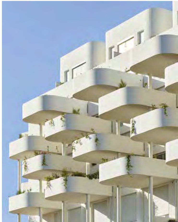
Expressive Baldachin-Balkone vor den Duplex-Einheiten © Roland Halbe
