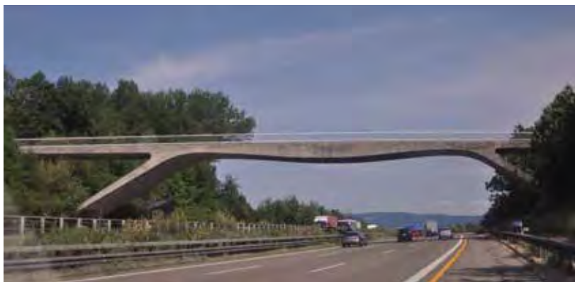
Überführungsbauwerk in Kirchheim unter Teck © Michael Kleiser
