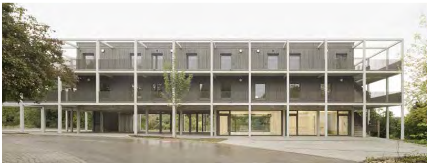
Ansicht von Süden © Brigida González
