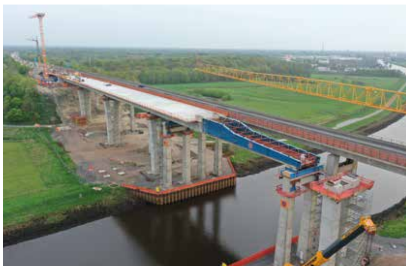
Herstellung der Huntebrücke bei Oldenburg © Adam Hörnig Baugesellschaft mbH & Co. KG/Büchting + Streit AG
