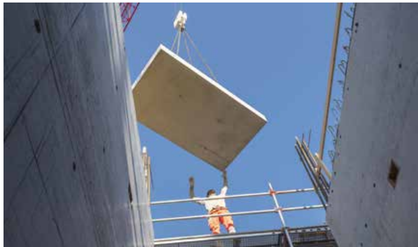
Einheben eines vorgefertigten Treppenpodests in ein bestehendes Gebäude © Schöck Bauteile GmbH
