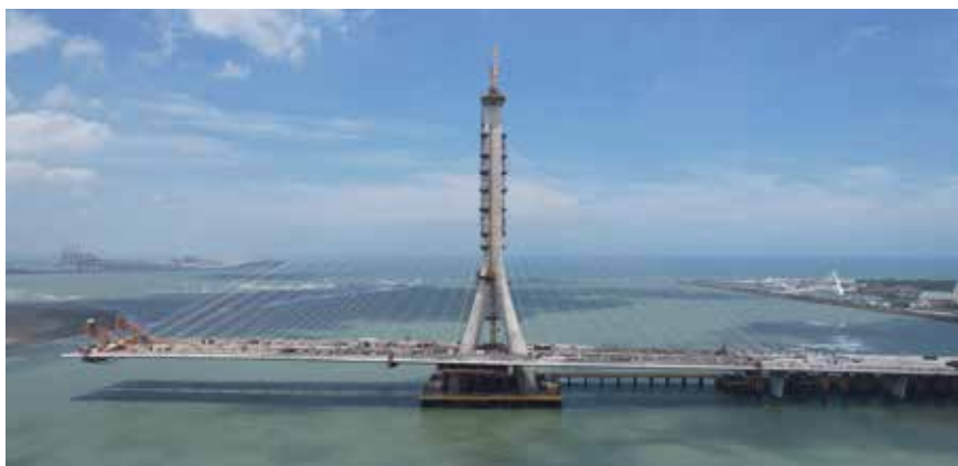
Freivorbau der Schrägseilbrücke Danjiang © KESCO
