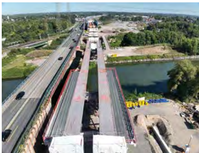
Emschertalbrückenzug noch im Bauzustand © Schüßler-Plan Ingenieurgesellschaft mbH
