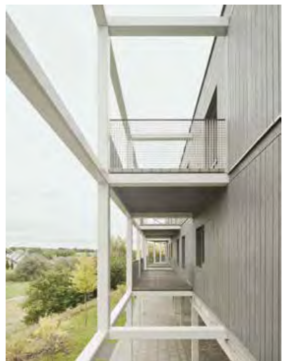
Baukörper mit umlaufendem Stahlgerüst © Brigida González
