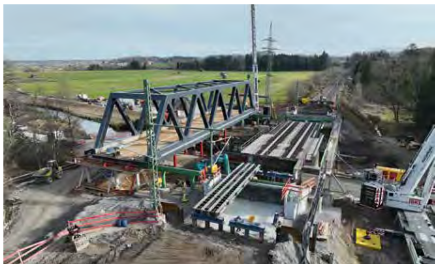
Eisenbahnüberführung über den Rothgraben © bulicek + ingenieure gmbH
