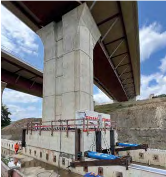
Querverschub der Talbrücke Rinsdorf
