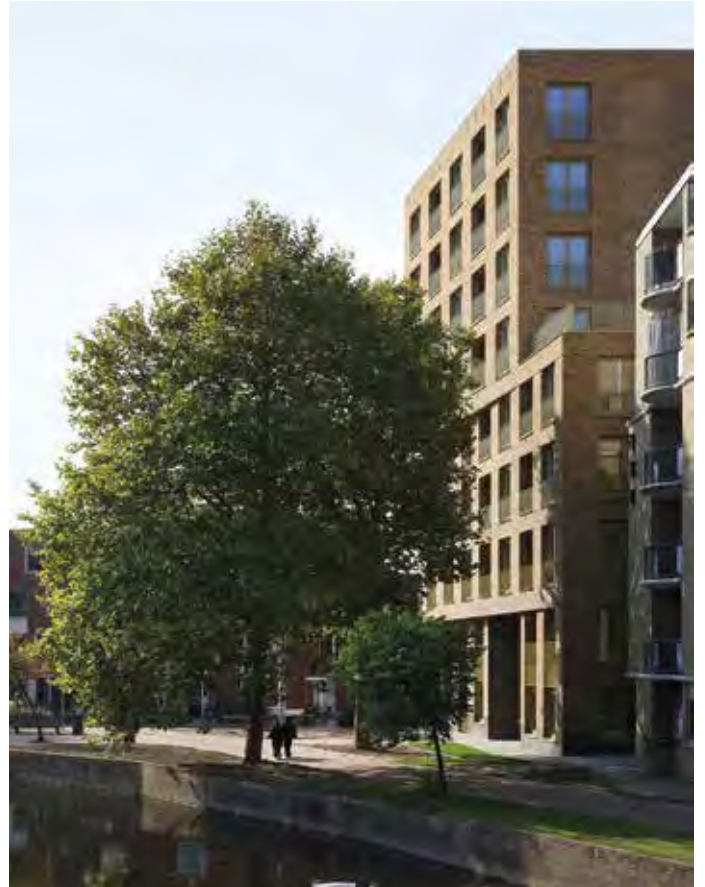
Wohnturm und Vorplatz von der Rotte aus gesehen © Filip Dujardin
