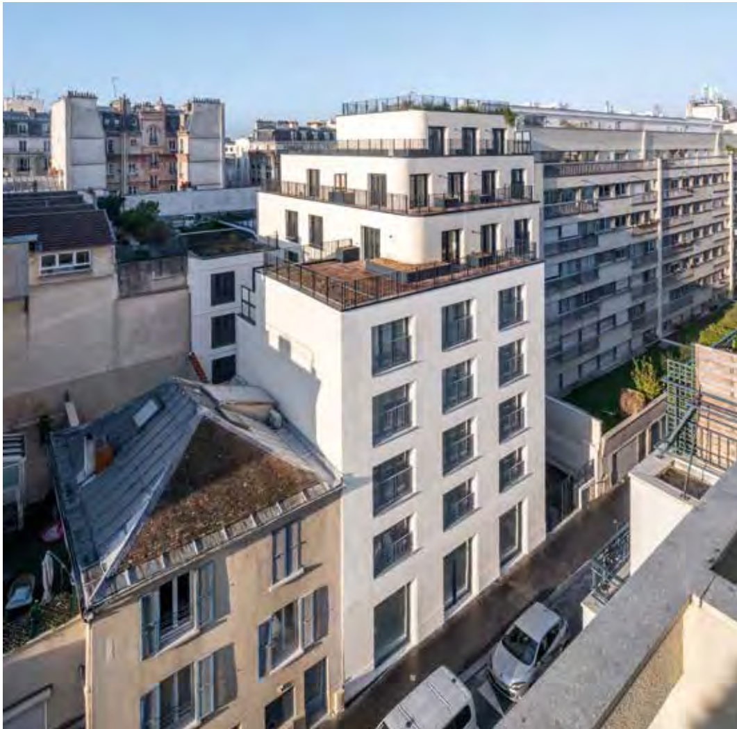
Gesamtansicht zur Straße mit Nachbarbebauung © Luc Boegly
