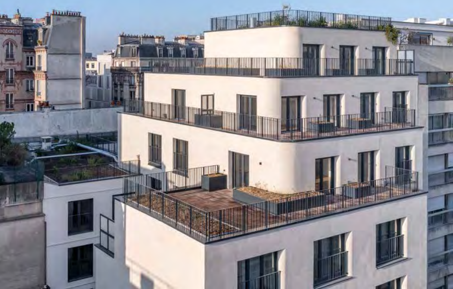
Ansicht der abgestuften Obergeschosse mit Terrassen © Luc Boegly
