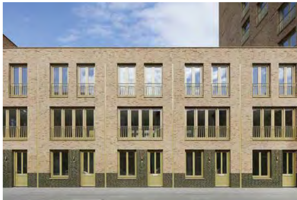
»Reihenhäuser« entlang des Straßenzugs © Filip Dujardin
