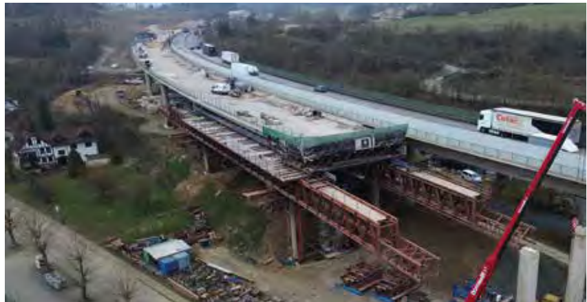
Abbruch und Neubau der Talbrücke Sechshelden © Implenia Civil Engineering GmbH
