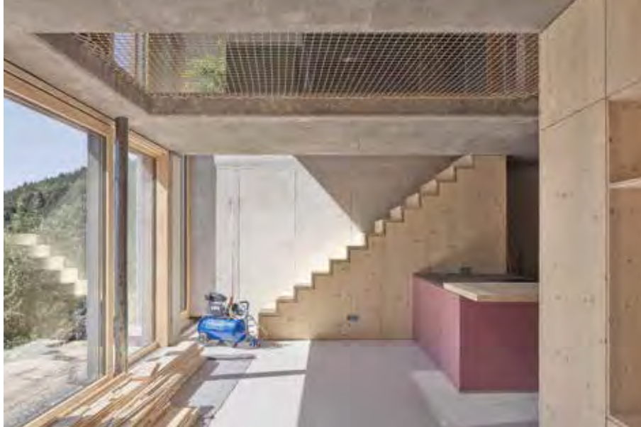
Wohnraum mit Treppe (während der Ausbauphase) © Benjamin Brückner
