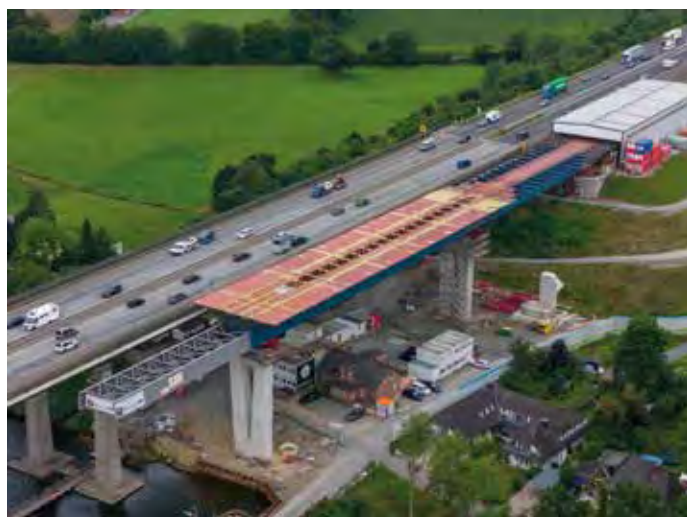
Errichtung der Rader Hochbrücke © DEGES GmbH
