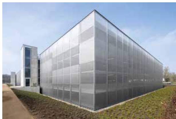
Textile Struktur mit variierenden Transparenzgraden © N. Kazakov/Haver & Boecker OHG
