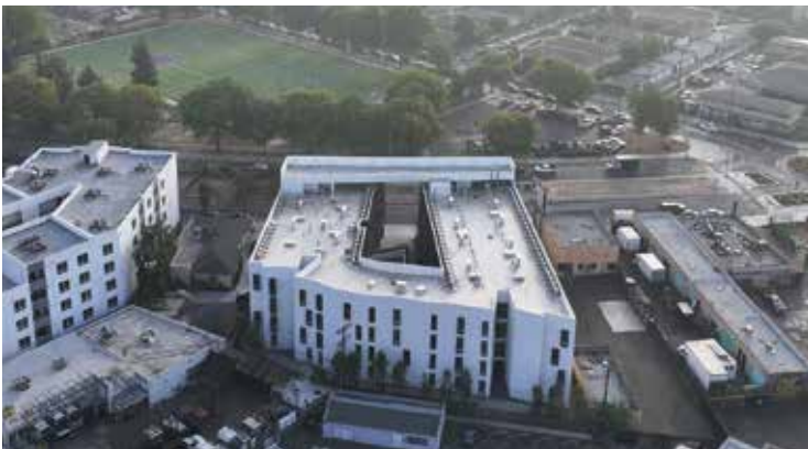
Luftaufnahme rückwärtige Fassade © TBD
