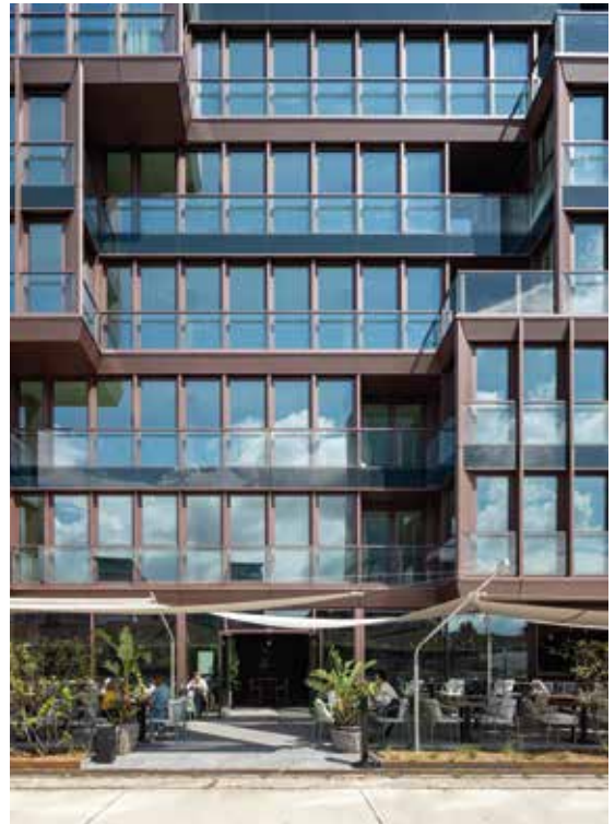
Detailansicht Südfassade mit Außengastronomie
