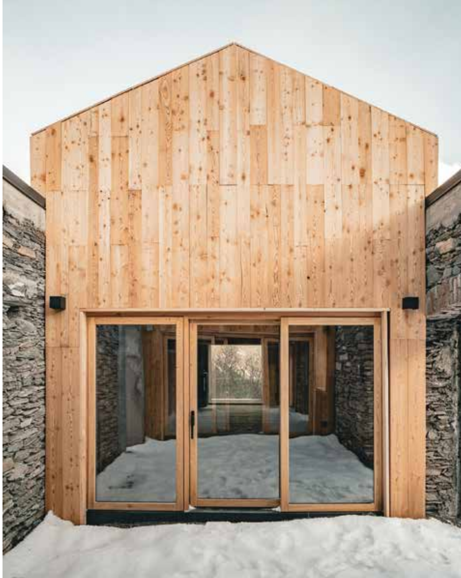
In die alten Mauern eingestellter Veranstaltungssaal © Edoardo Schiari
