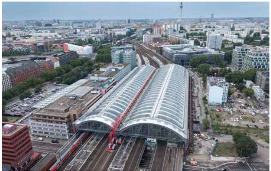
Umbau des Ostbahnhofs in Berlin © FotografielRaum/SEH Engineering GmbH
