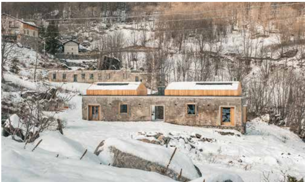
Südansicht der ehemaligen Stallungen mit dem Zollgebäude (Alpengarten) im Hintergrund © Edoardo Schiari
