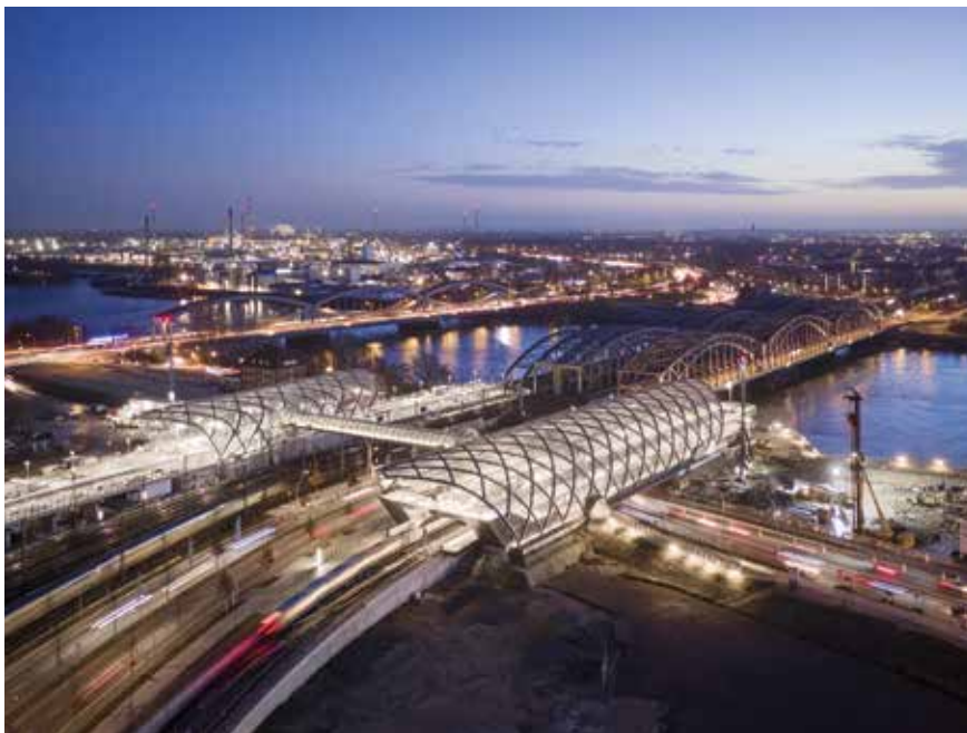
U- und S-Bahn-Station Elbbrücken in Hamburg © Marcus Bredt/SEH Engineering GmbH
