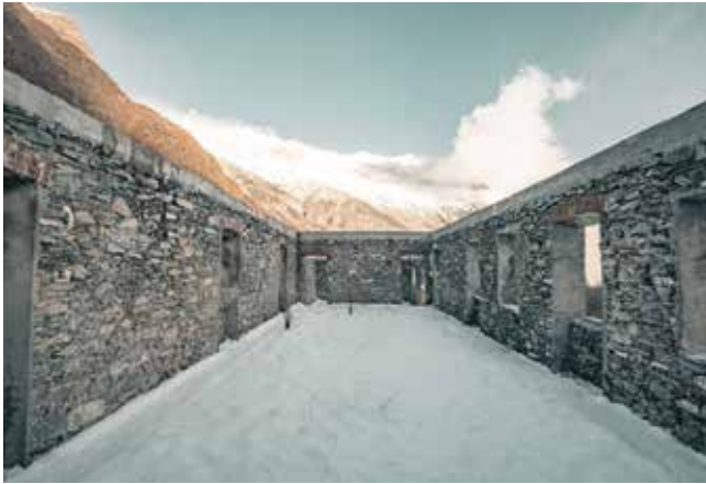
Das Innere des Zollgebäudes nach der Entkernung © Edoardo Schiari
