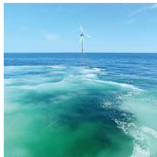
Windkraftanlage nördlich von Norderney © Vanessa Stelzenmüller/Thünen-Institut
