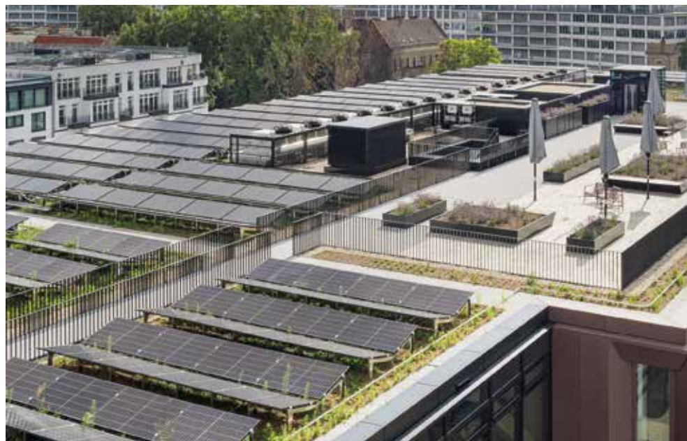
Dachfläche mit Solarthermie- und Photovoltaik-Modulen sowie Terrassen © HG Esch
