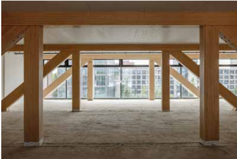
Holzfachwerk-Konstruktion des Verbindungsbaus während der Ausbauphase © HG Esch
