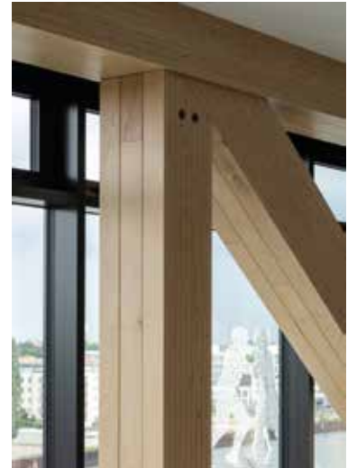
Detailansicht der Holzfachwerk-Konstruktion © HG Esch
