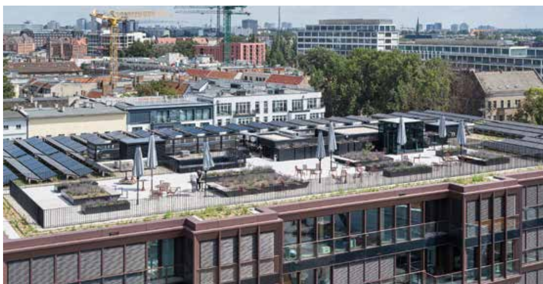
Dachaufsicht mit Photovoltaik- und Solarthermie-Modulen und Terrassen © HG Esch
