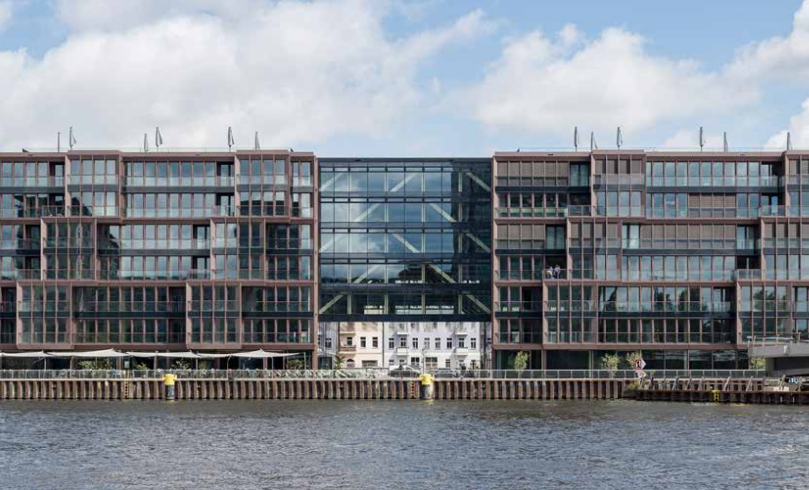
Zur Spree orientierte Südfassade der beiden Baukörper mit Verbindungsbau © HG Esch
