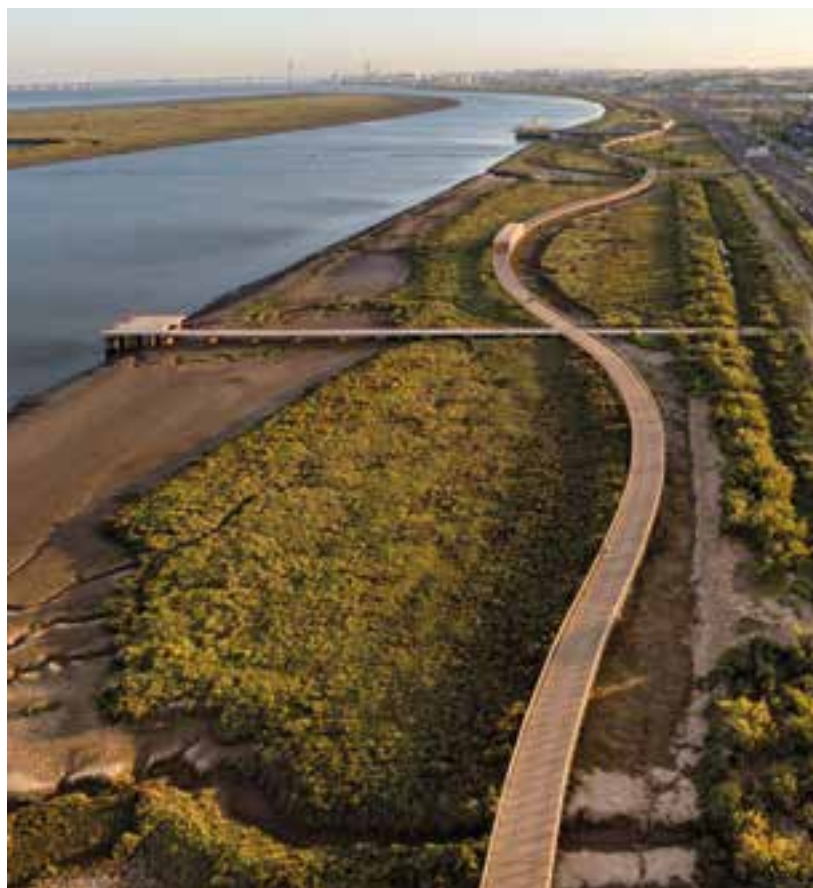
Steg mit Anschluss an die Straße sowie zur Plattform am Fluss © Artur Carvalho
