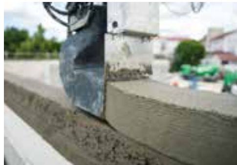
3-D-Betondrucker auf der Baustelle © Aleksej Keksel
