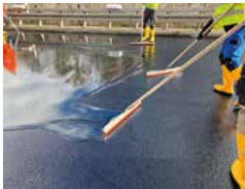
Aufbringen und Verteilen des niedrigviskosen Harzes © Sika Deutschland CH AG & Co KG
