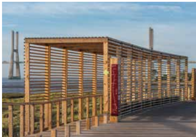
Verschatteter Rastbereich mit Bänken, Aussichtsplattform und Hinweistafel © João Guimarães
