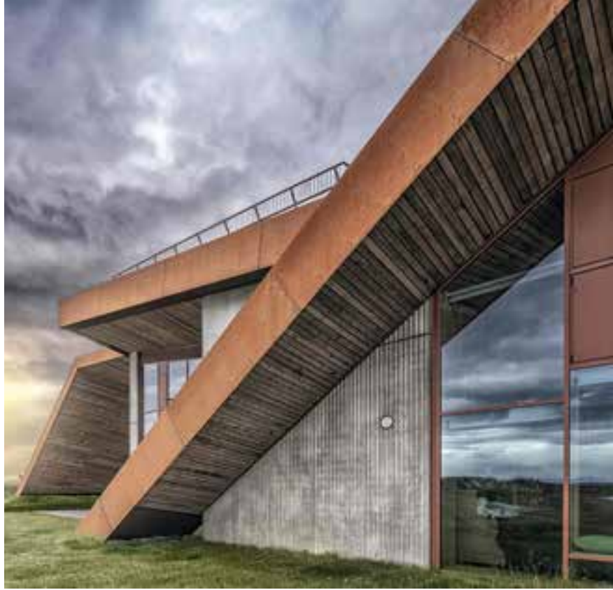
Cortenstahl-Band und strukturierte Außenfassade © Karl Vilhjálmsen
