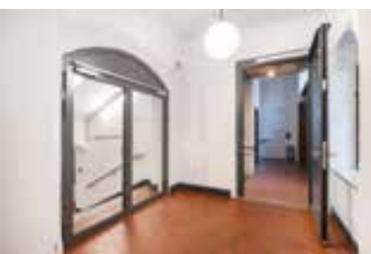
Individuell angepasste Brand- und Rauchschutztüren im Innern © Uwe Mühlhäußer/Forster Profilsysteme AG
