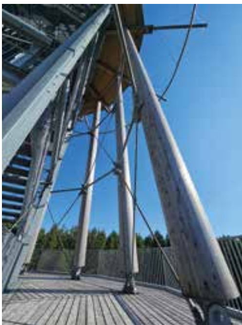
Aussteifung ohne Sichtverlust am Aussichtsturm © Peikko Deutschland GmbH
