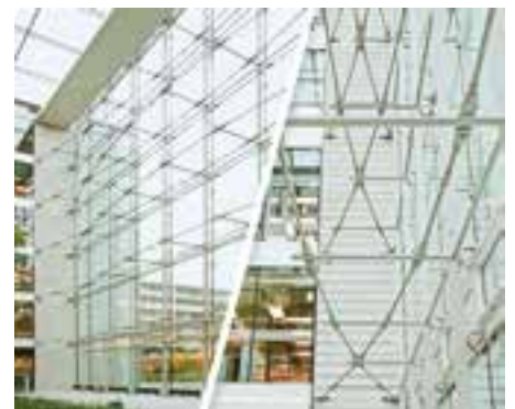
Aussteifung einer Glasfassade mit Zugstäben © Peikko Deutschland GmbH
