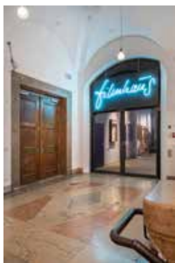
Individuell angepasste Brand- und Rauchschutztüren im Innern © Uwe Mühlhäußer/Forster Profilsysteme AG
