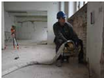
Einbringen des Expansionsharzes mit messtechnischer Überwachung © Uretek Deutschland GmbH
