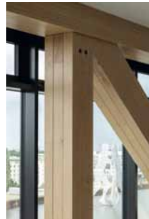
Detail der Holzfachwerkkonstruktion © HG Esch
