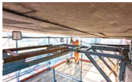
Konstruktion der Verschubbahn mit Tisch © Maurer SE
