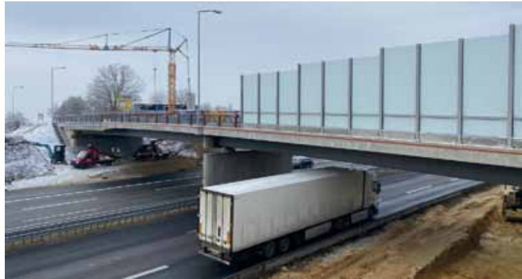
Stahlverbundbrücke in Südbayern mit spritzverzinkten Hohlkästen © Max Bögl Bauservice GmbH & Co. KG
