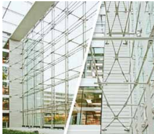
Aussteifung einer Glasfassade mit Zugstäben © Peikko Deutschland GmbH
