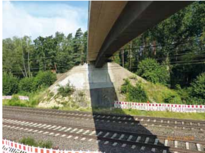
Neubau einer spritzverzinkten und mit einer Versiegelung versehenen VFT-Brücke in Uelzen © Stendaler Brücken- und Verkehrsanlagenplanungs-GmbH
