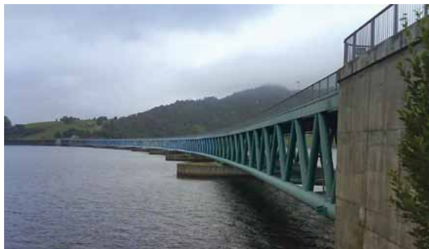
Bergsøysund-Brücke in Norwegen mit Duplex-Beschichtung © www.wikimedia.org
