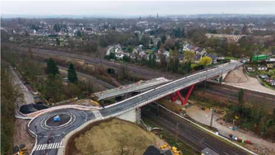
Neubau einer neun DB-Gleise querenden spritzverzinkten Stahlverbundbrücke in Bochum © Stadt Bochum
