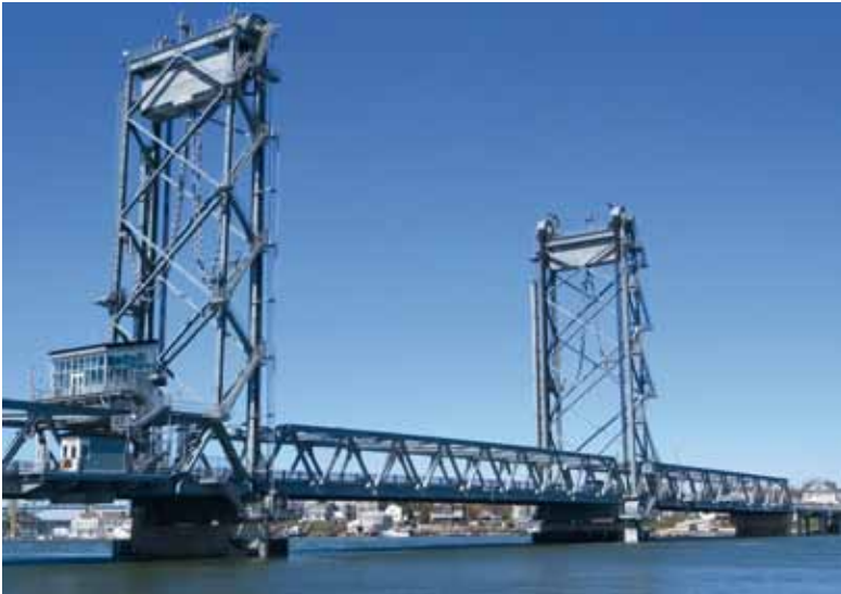
Spritzverzinkte Memorial Bridge in New Hampshire © www.wikimedia.org
