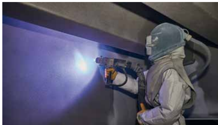
Korrosionsschutzerneuerung der Spreehafenbrücke in Hamburg © Muehlhan Holding GmbH
