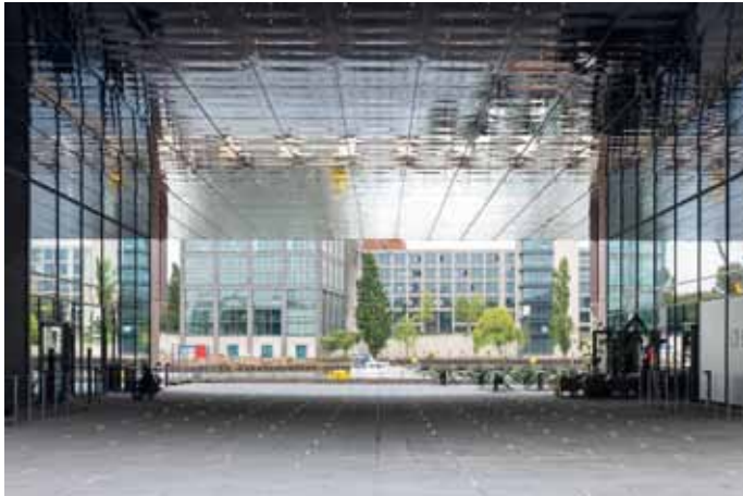
Durchgang zwischen den beiden Baukörpern © HG Esch
