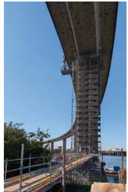
Interimsbrücke aus Gerüstteilen im Köhlbrand © Maurer SE
