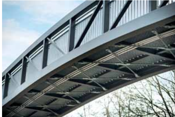
Fußgängerbrücke mit Diagonalverbänden © Hoving + Hellmich GmbH
