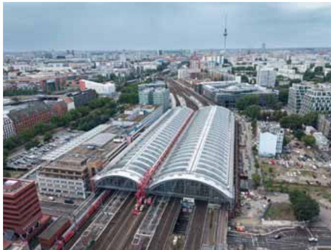
Umbau des Ostbahnhofs in Berlin © FotografielRaum/SEH Engineering GmbH
