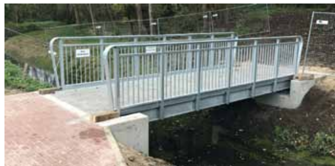
Steg in Hamburg mit »reiner« Spritzverzinkung © Hamburg Port Authority AöR
