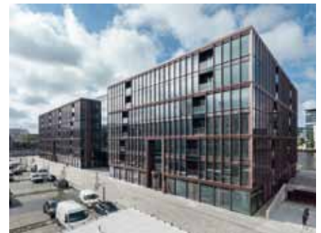
Nordfassade mit den zwei Haupteingängen © HG Esch
