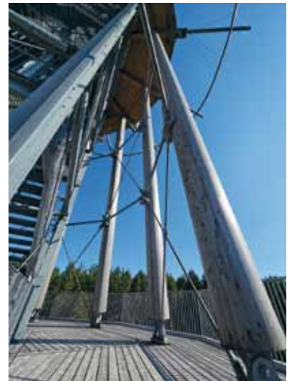
Aussteifung ohne Sichtverlust © Peikko Deutschland GmbH
