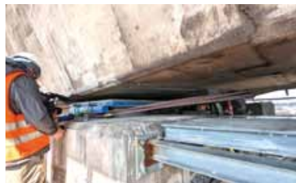
Einbringen eines neuen Lagers © Maurer SE
