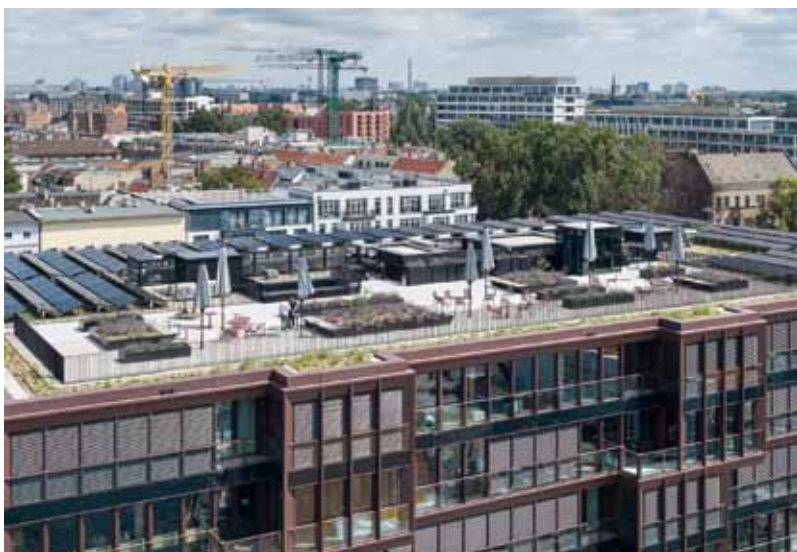
Dach mit Photovoltaik- und Solarthermiemodulen sowie Terrassen © HG Esch
