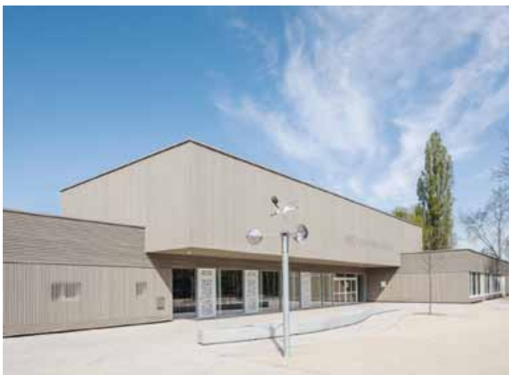
Hybridkonstruktion aus Holz, Beton und Stahl © dasch zürn + partner/Henrik Schipper
