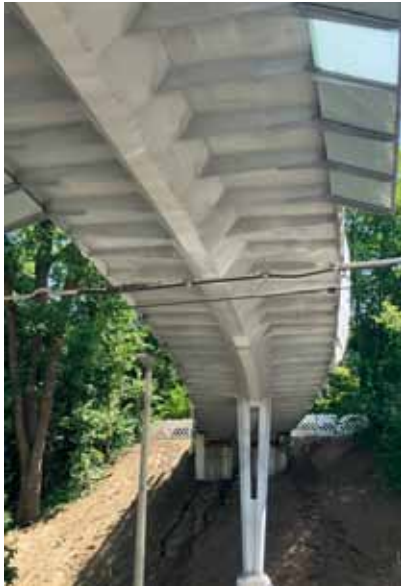
Neubau mit »reiner« Spritzverzinkung: Geh- und Radwegbrücke in Stuttgart © Mayr Ludescher Partner
