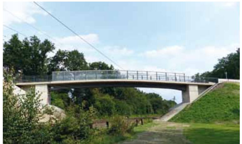
Historische Drahtbrücke in Kassel: Spritzverzinkung plus Versiegelung © Stadt Kassel
