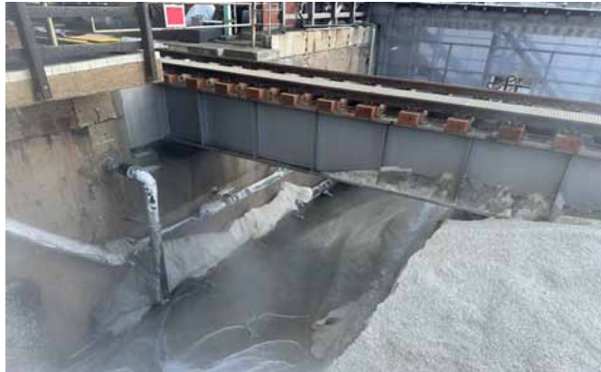
Stahlbrücke über Salzbunker und Salzlösestation des Chemiearks Knappsack © Westlake Vennolit GmbH & Co. KG
