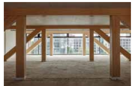
Verbindungsbau während der Ausbauphase © HG Esch
