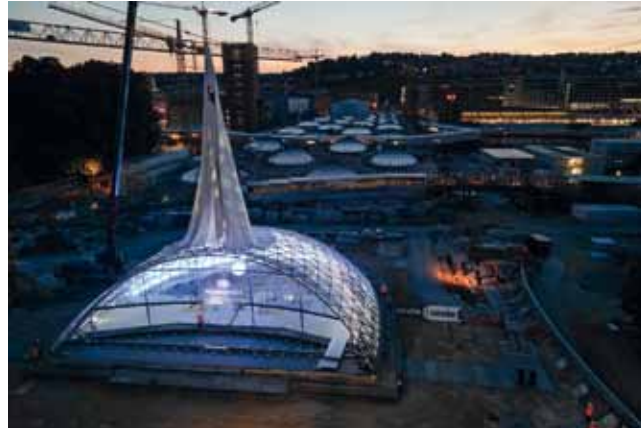
Gitterschale nach Entfernen der Schutzplane © DB Projekt Stuttgart-Ulm GmbH
