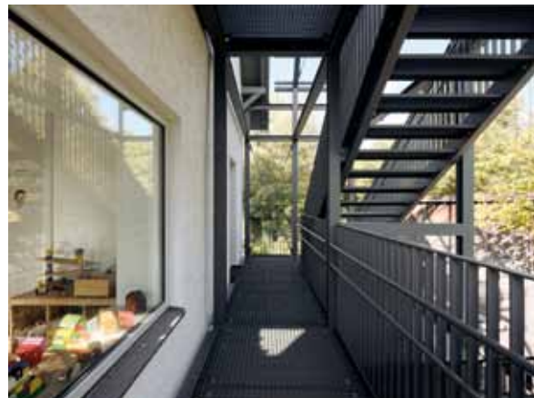
Freistehende Stahlkonstruktion als Ergänzung © Maike Hansen/bodensteiner fest Architekten
