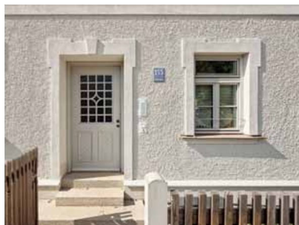
Außendämmung mit Aerogel-Putz © Maike Hansen/bodensteiner fest Architekten
