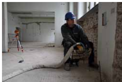
Einbringen des Expansionsharzes mit messtechnischer Überwachung © Uretek Deutschland GmbH
