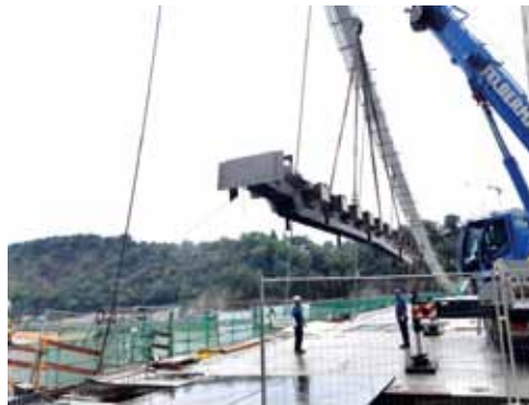
Einhub eines Fahrbahnübergangs © Maurer SE
