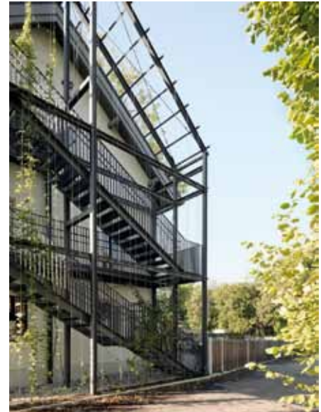
Zweiter Fluchtweg: Tragstruktur aus Stahl © Maike Hansen/bodensteiner fest Architekten
