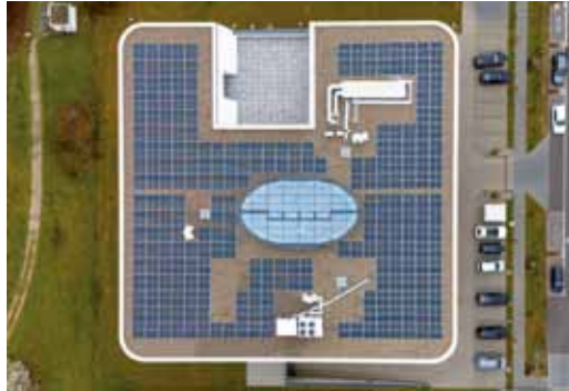
Nachhaltige Flachdachnutzung dank Tageslichtsystemen und Photovoltaik © Lamilux Heinrich Strunz GmbH
