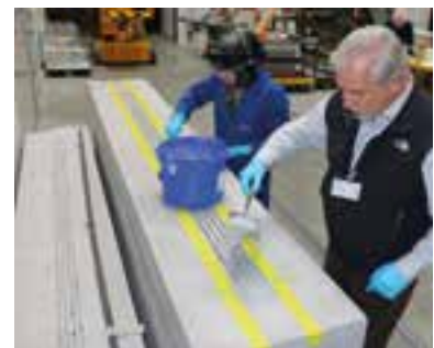
Epoxidharz als Kleber für CFK-Lamellen © Empa
