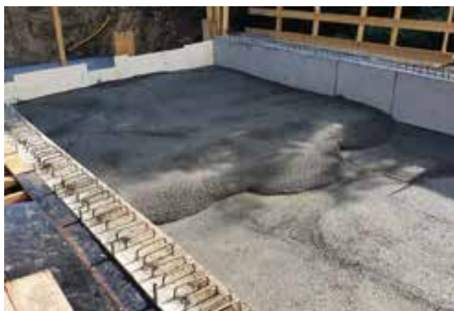
Gewichtseinsparung dank Leichtbeton-Verwendung © Gerd Müller GmbH/Liapor GmbH & Co. KG
