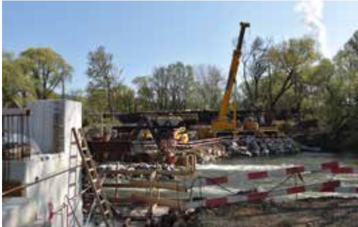
10 Herstellung eines Hilfspfeilers in der Mur © Engelsmann Peters GmbH
