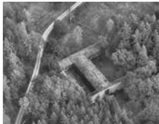
1 Altes Brückenbauwerk von 1935 © Rolf Nagel
