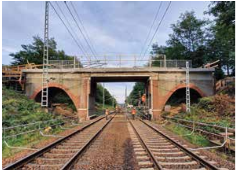
Leichtbeton-Einsatz auf den beiden seitlichen Bögen © Gerd Müller GmbH/Liapor GmbH & Co. KG
