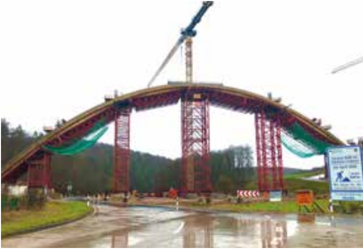
12 Traggerüst mit Türmen für die Bogenherstellung © Kinkel + Partner GmbH
