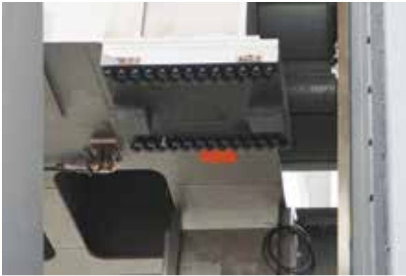
■ Oberteil des Horizontalkraftlagers © Maurer SE
