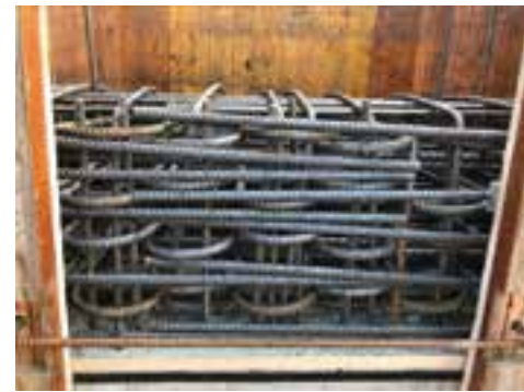
9 Schalung mit Bewehrung des Probegelenks © Strabag AG
