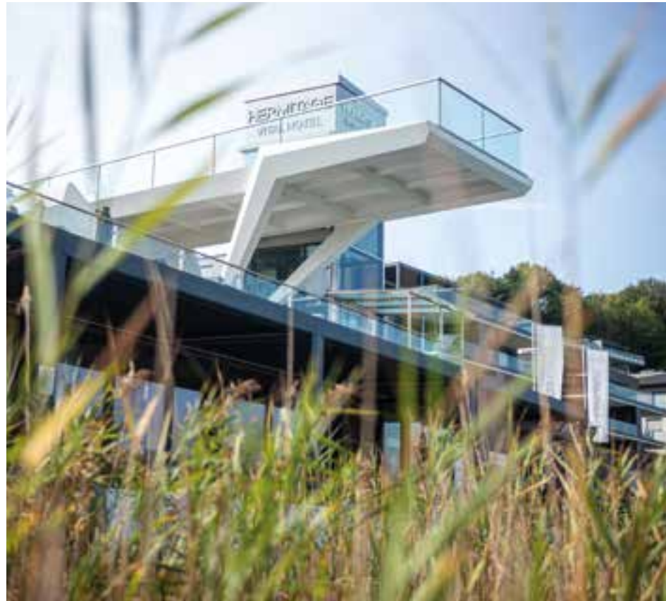
11 Aussichtsplattform und Brückenbauwerk in Maria Wörth © Marc Stickler
