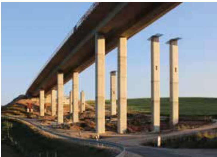
10 Überbau Nord in Blickrichtung Widerlager 130 © Kinkel + Partner GmbH
