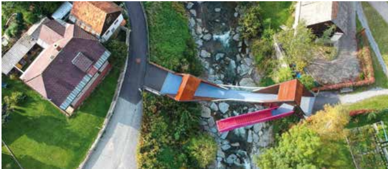
1 Gesamtbauwerk aus Übergang und »Ausleger« nach Fertigstellung © Architektur Steinbacher Thierrichter ZT GmbH
