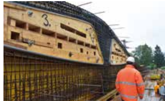
12 Schalung und Bewehrung der beiden Hauptträger © Engelsmann Peters GmbH
