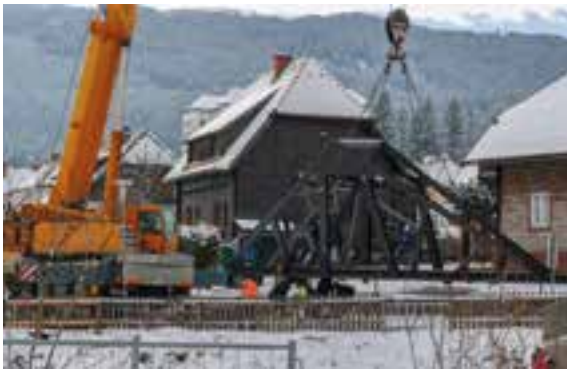
8 9 Einhub und Stahlbaumontage © Architektur Steinbacher Thierriecher ZT GmbH
