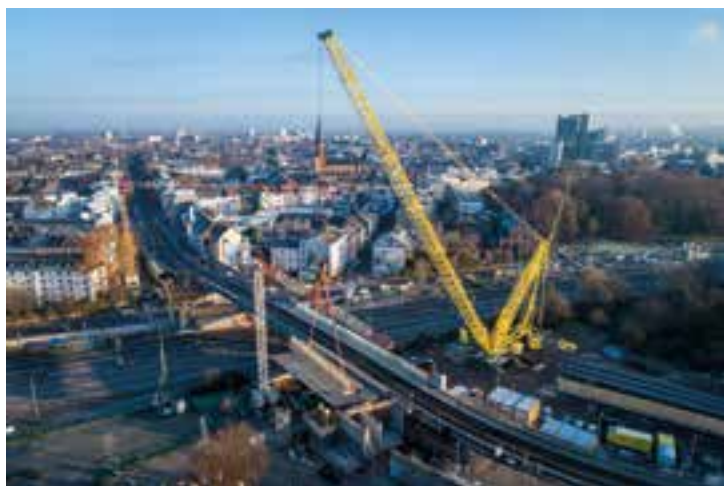
■ Fertigteilelement mit vormontiertem Kappengerüst © Echterhoff GmbH & Co. KG
