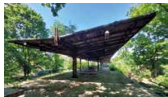
Heutiges Erscheinungsbild von Strecke und Haltestellen © DB Netz AG
