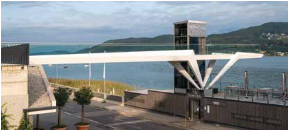
2 Hermitage-Steg nach Fertigstellung © Marc Stickler
