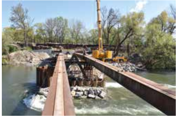
11 Aufbau des Schalungsträgers aus Stahl © Engelsmann Peters GmbH
