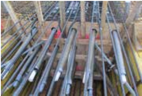
4 Blick auf eine vollbesetzte Koppelfuge © Strabag AG
