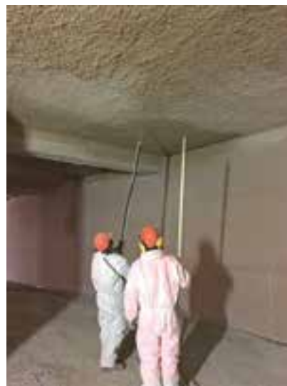
■ Spritzapplikation als eine Alternative © Sika Deutschland GmbH
