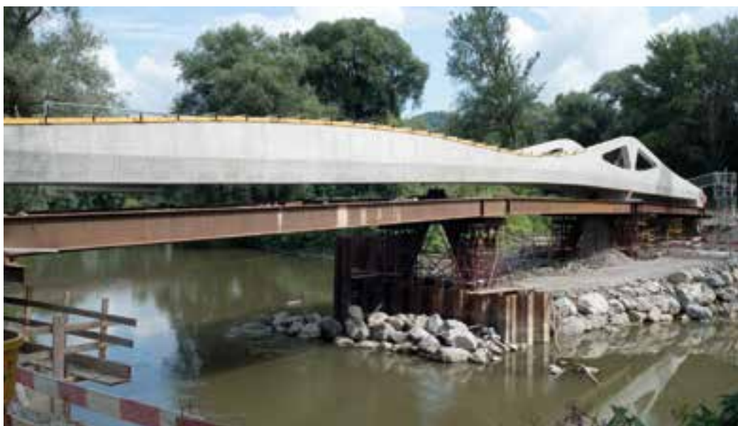
16 Demontage der Stahlunterkonstruktion © Helmut Tezak
