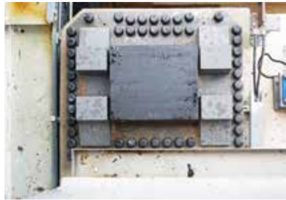
■ Gegenstück »für« Längsfesthalte Zähne © Maurer SE
