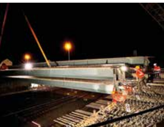
■ Einheben von Längsträgern © Echterhoff GmbH & Co. KG
