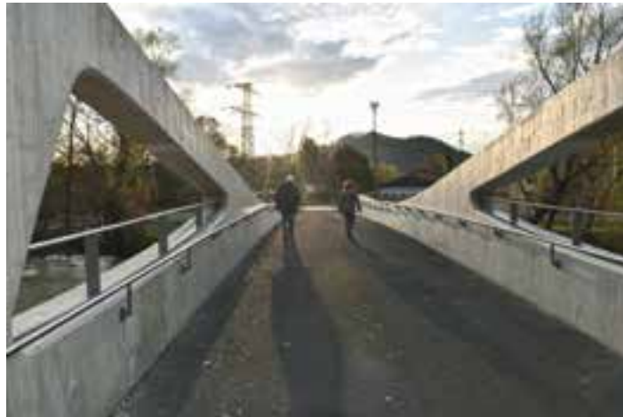
15 Überbau der Brücke im Bereich der »Fenster« © Engelsmann Peters GmbH
