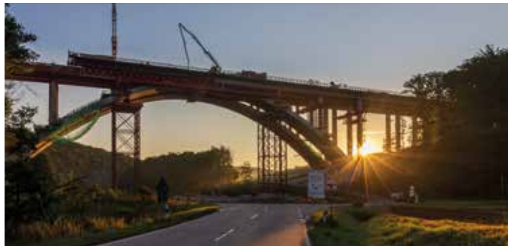
14 Betonage des Überbaus mit zwei Hilfstürmen zur Bogenunterstützung © Kinkel + Partner GmbH
