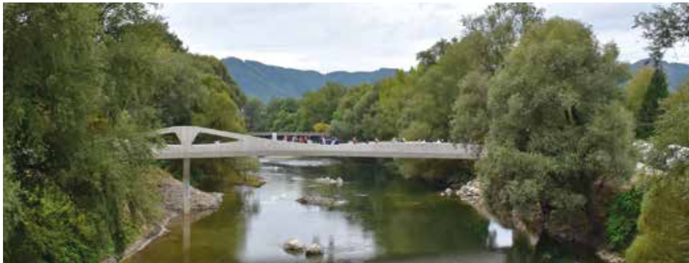
1 Neue Geh- und Radwegbrücke zwischen Gratwein-Straßengel und Gratkorn © Engelsmann Peters GmbH
