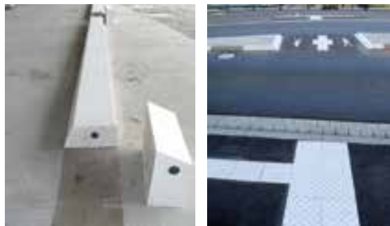
Befestigung von Bordsteinen und Bodenindikatoren © Silikal GmbH
