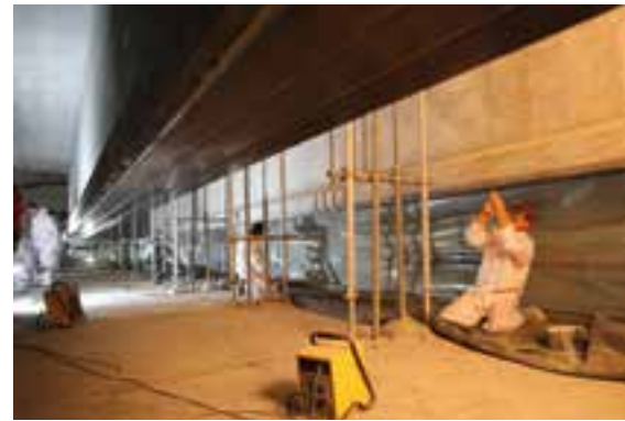
Sanierung einer Autobahnbrücke bei Küssnacht © S&P Clever Reinforcement Company AG
