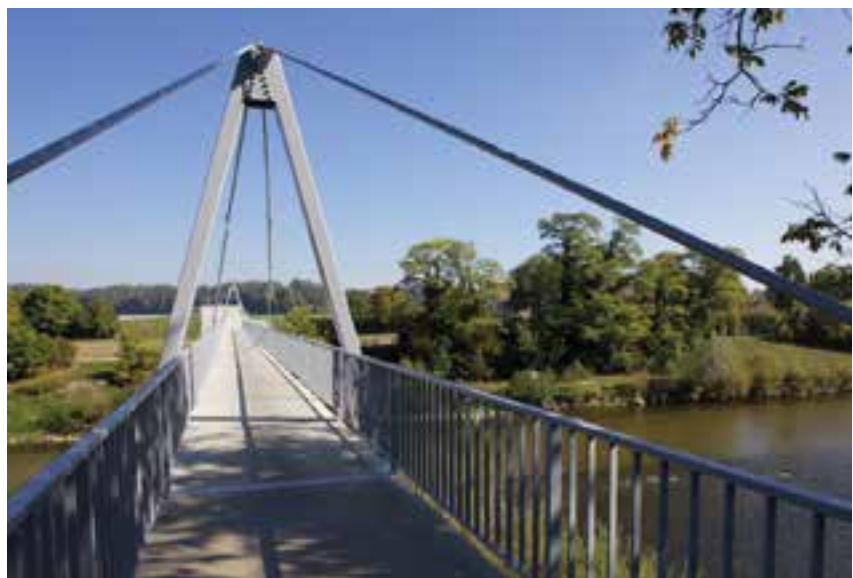
Modulbrücke aus CPC-Elementen © Holcim (Deutschland) GmbH
