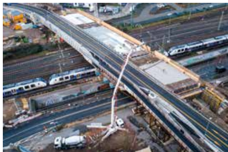
■ Betonage des Überbaus © Echterhoff GmbH & Co. KG
