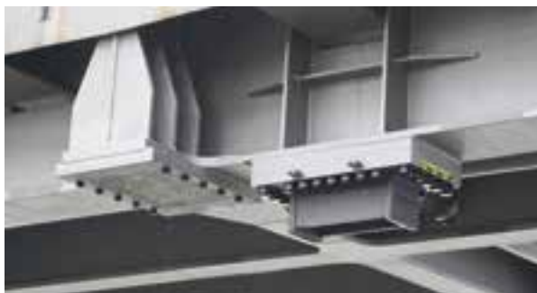
■ Sonderlager der neuen Bahn-Hubbrücke © Maurer SE
