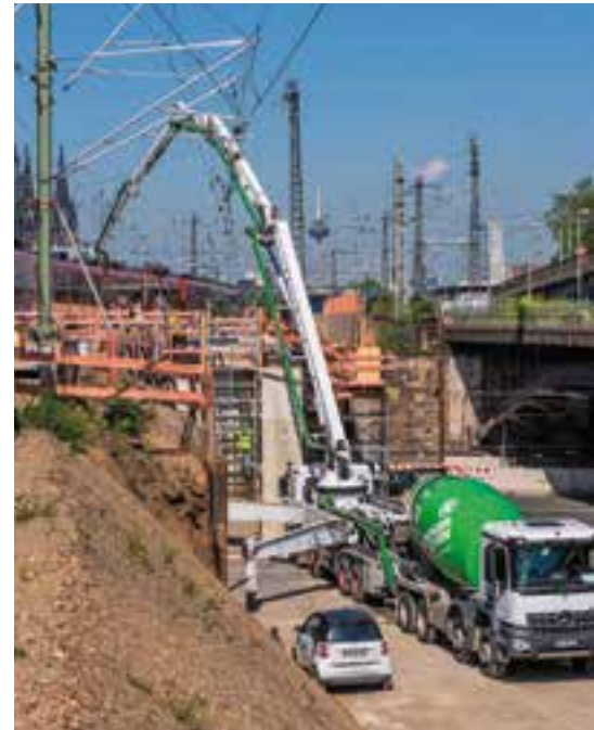
Betonage und Pumpeinsatz bei laufendem Schienenverkehr © HeidelbergCement AG/Steffen Fuchs
