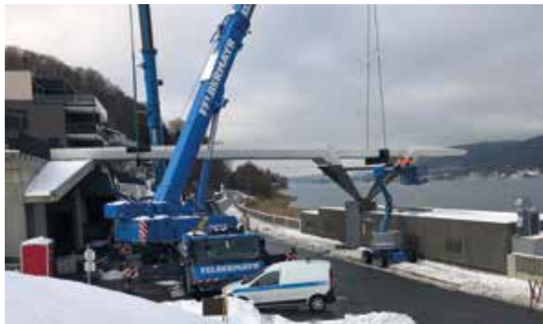
10 Montage der Brückenstruktur mittels Tandemhub © Lamplhof Betriebs GmbH
