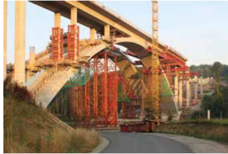
13 Hilfstürme am Bogen für die Überbauerstellung © Kinkel + Partner GmbH
