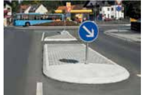
Verkehrinsel in Weilmünster © Meudt/Silikal GmbH
