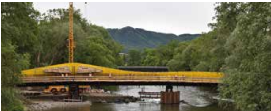
14 Eingeschaltete Brückenträger mit Blick auf Hilfspfeiler im Fluss © Engelsmann Peters GmbH
