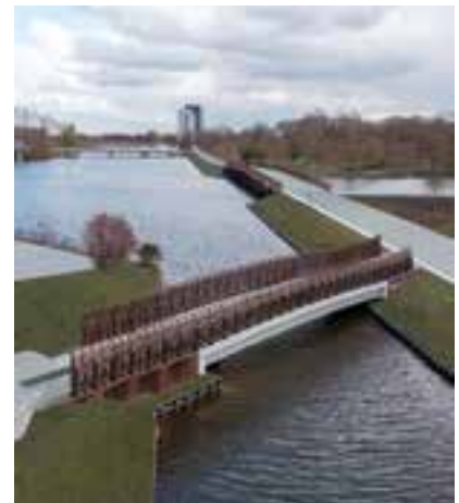
■ Errichtung eines ersten Bauwerks in Almere © Smart Circular Bridge
