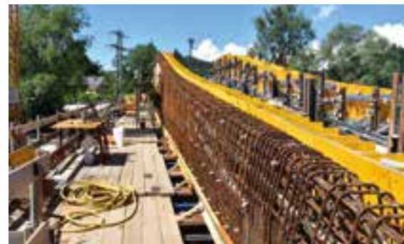
13 Montage der Schalung des Brückenträgers © Engelsmann Peters GmbH
