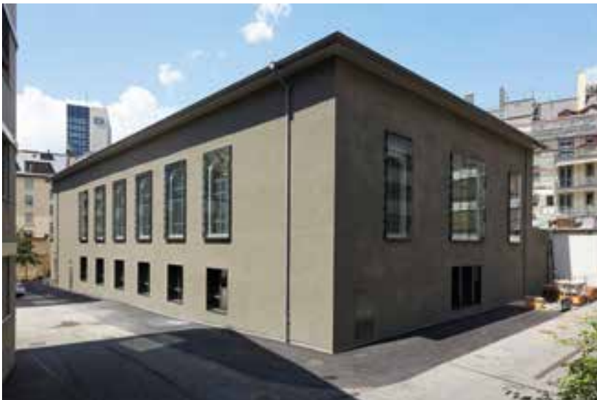
Südöstliche Fassade mit vorgesetzten Kastenfenstern © Heinz Unger
