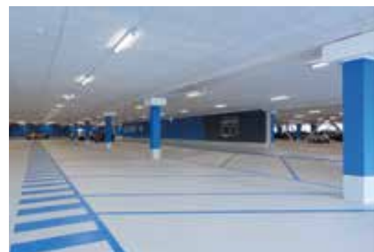
Parkflächen: hohe mechanische Beständigkeit dank OS-8-System © Sika Deutschland GmbH
