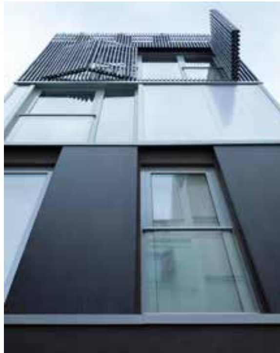
Blick entlang der Hauptfassade © Caroline Dethier
