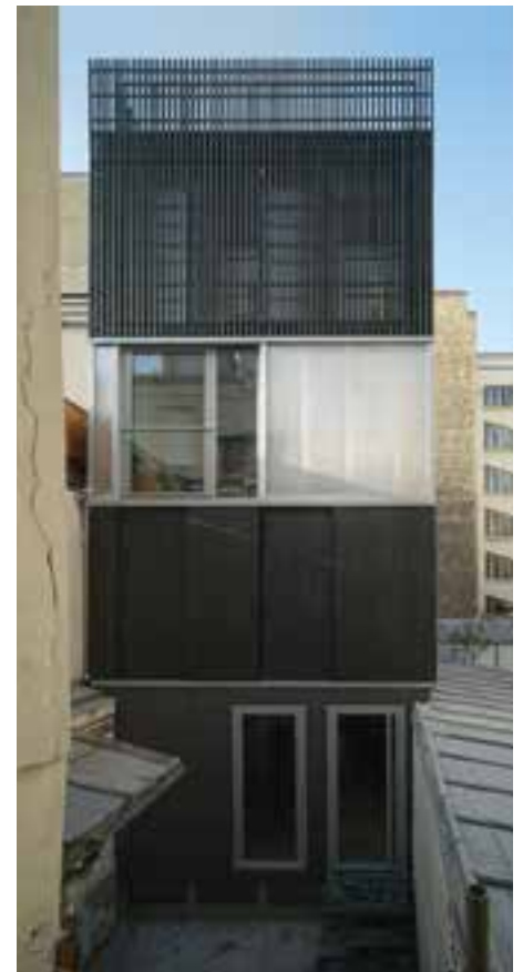
Wohnturm nach dem Umbau und der Aufstockung © JAVA architecture
