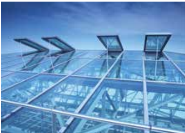
Glasdach auf dem Verwaltungsgebäude der Musikhochschule München © Lamilux Heinrich Strunz GmbH
