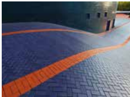
Blau und orange Klinker in Charlerois © Arbeitsgemeinschaft Pflasterklinker e. V./ Ependiller + Gnegel
