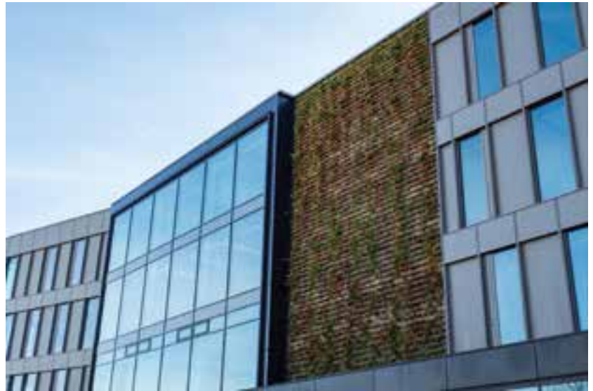
Nordfassade des Neubaus mit begrünter Fläche © Drees & Sommer
