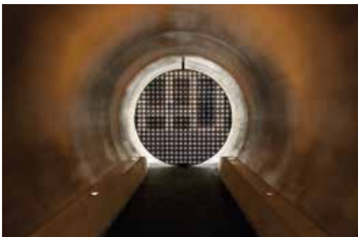
Innenansicht des geschlossenen Tunneltors © Heinz Unger
