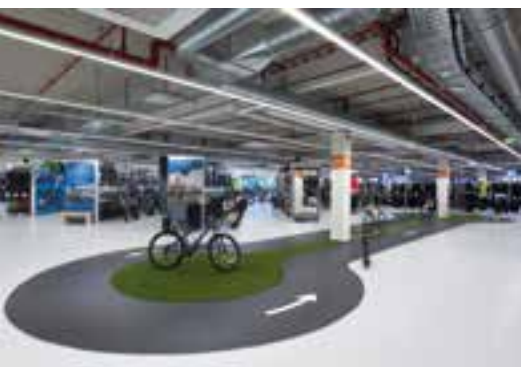
Fahrradteststrecke für Kunden: Versiegelung und zusätzliche Abstreuerung mit Quarzsand © Sika Deutschland GmbH
