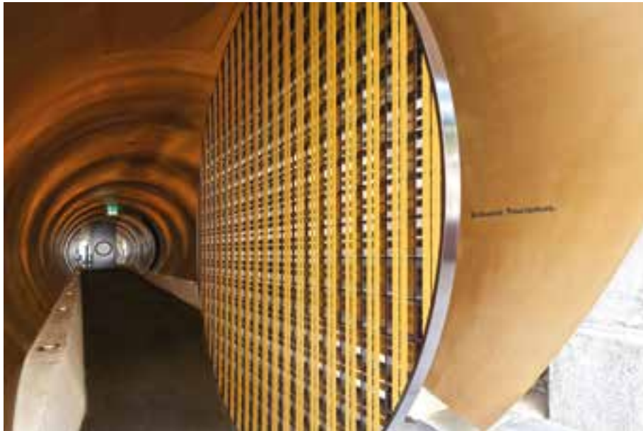
Blick in Tunnel auf den Zugang zur Halle © Heinz Unger
