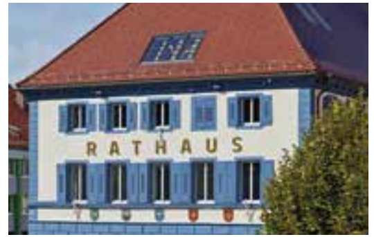
Neues Lamellenfenster im Dachbereich © Lacker GmbH
