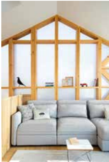
Dachgeschoss mit Holzrahmenkonstruktion © Caroline Dethier
