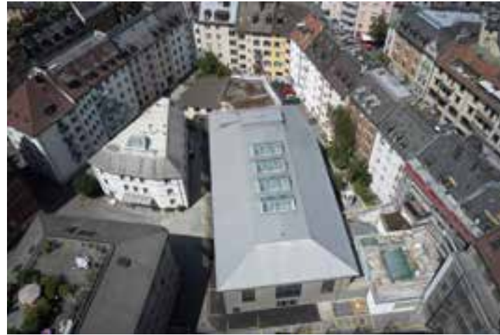
Luftaufnahme der Halle mit neuer Dacheindeckung © Heinz Unger
