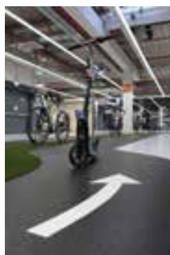
Fahrradteststrecke für Kunden: Versiegelung und zusätzliche Abstreuerung mit Quarzsand © Sika Deutschland GmbH
