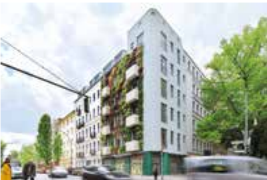
Ausgezeichnete »Pflanzenhülle« für Gebäude © Gütegemeinschaft Vertikalbegrünungen e. V./Vertiko GmbH
