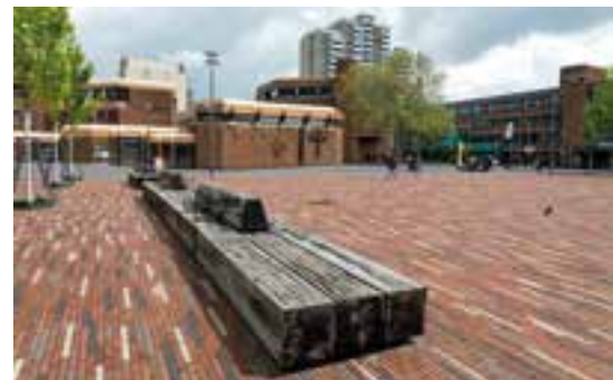
Platzgestaltung in Hochkantverlegung in Köln © Arbeitsgemeinschaft Pflasterklinker e. V./Heike Skamper
