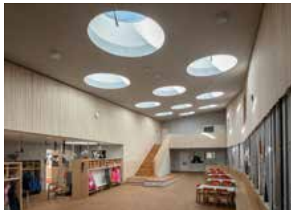
Flachdachfenster beim Kindergarten St. Severin in Garching © Lamilux Heinrich Strunz GmbH
