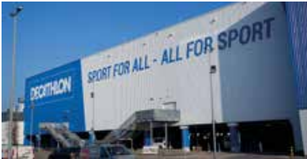
Fassadenverkleidung aus Stahlblech nach der Umgestaltung © Sika Deutschland GmbH
