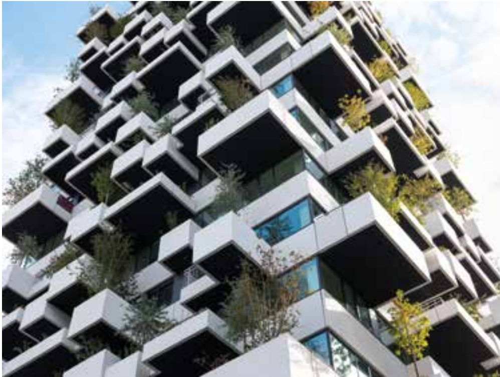
Fassadenansicht mit auskragenden Balkonen und integrierten Pflanzkübeln © Paolo Rosselli
