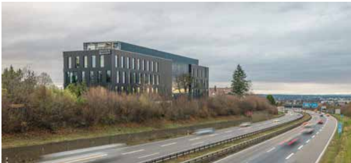
Gesamtansicht des Neubaus entlang der A 831 © Drees & Sommer
