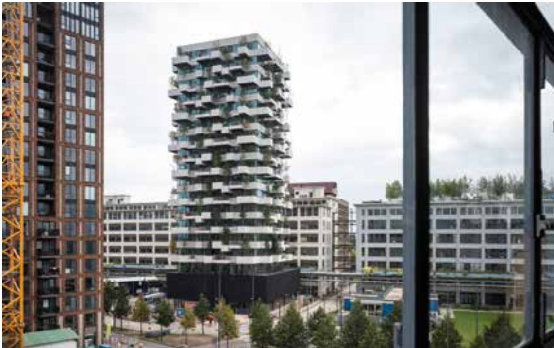
Begrünter Wohnturm umgeben von ehemaligen Produktionsstätten und weiteren Neubauten © Paolo Rosselli
