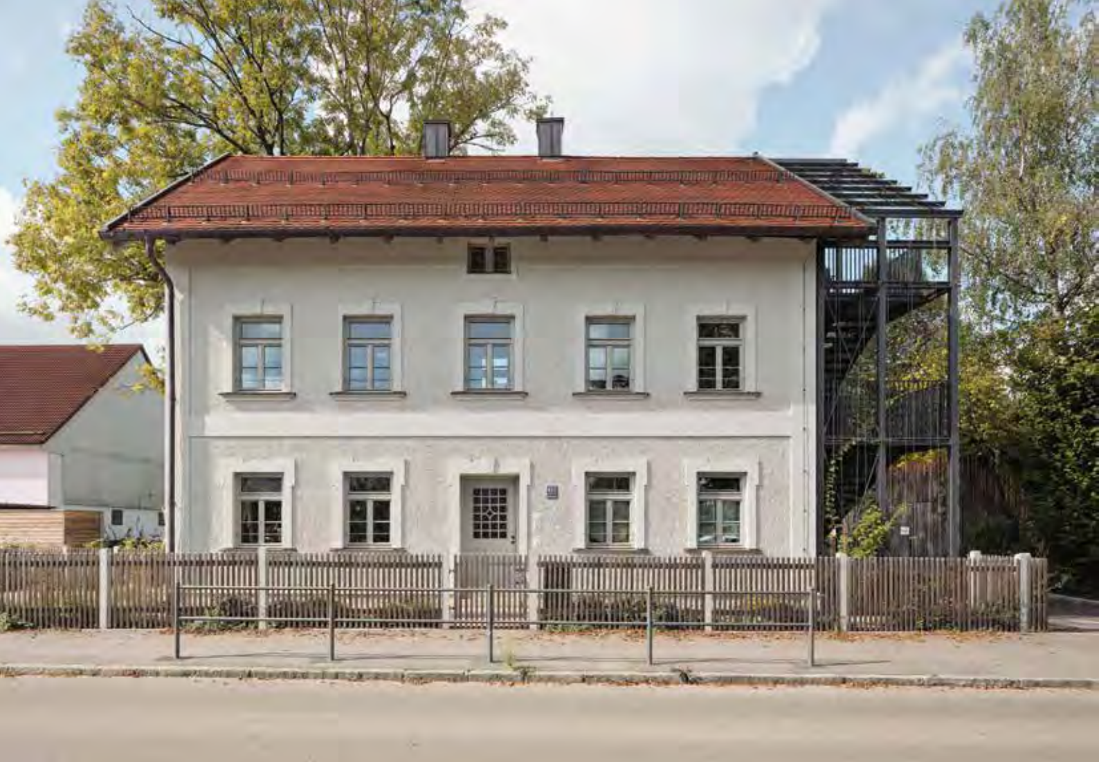
Ansicht zur Straße nach der Restaurierung © Maïke Hansen/bodensteiner fest Architekten
