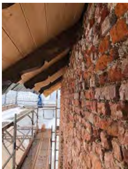
Instandsetzung im Dachbereich © bodensteiner fest Architekten
