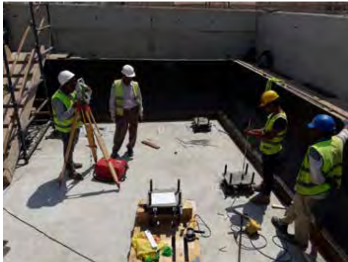
Einbau der Bleikernlager © Maurer SE
