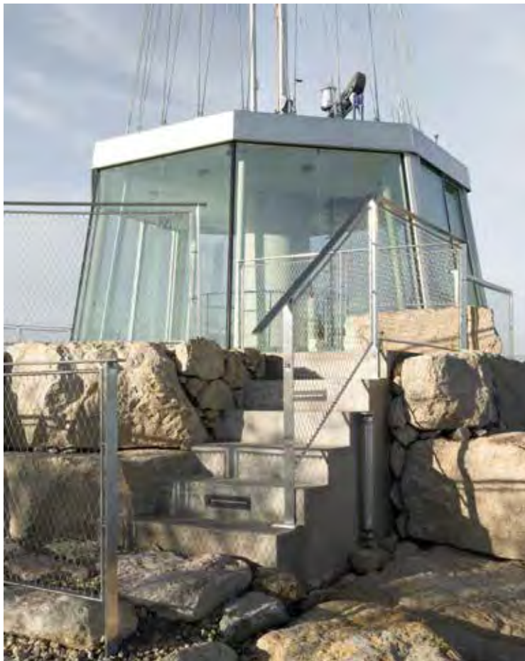
Zugang zum Obergeschoss (Kampfrichterkabine) und der Terrasse © Dylan Perrenoud
