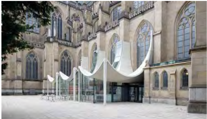
Baldachinartige Dachkonstruktion am Dom © Gregor Graf/IZB
