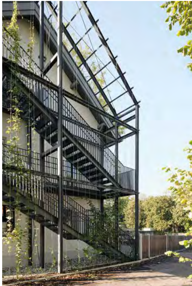
Neu vorgelagerter Fluchtweg mit anwachsender Begrünung © Maïke Hansen/bodensteiner fest Architekten
