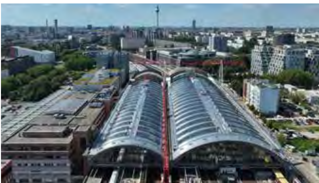
Gleishallen mit neuem Metaldachsystem aus zwei Perspektiven © Zambelli Holding GmbH
