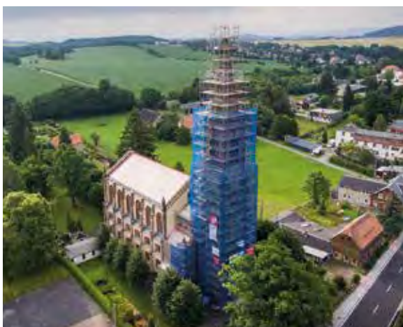
Digitales Projektmanagement bei der Sanierung der Kirche Leutersdorf © Bau-Planung-Risch Ingenieurgesellschaft
