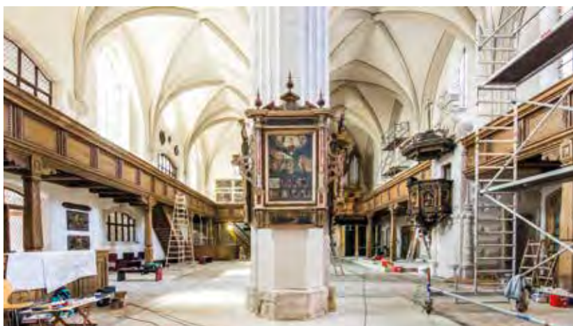
Detailliertes Zeitmanagement für parallele Gewerke: Klosterkirche Zittau © Bau-Planung-Risch Ingenieurgesellschaft
