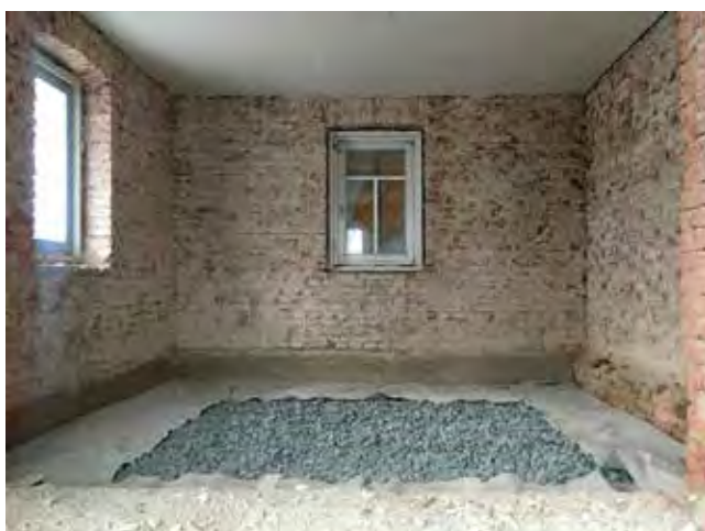
Sanierung der Böden © bodensteiner fest Architekten
