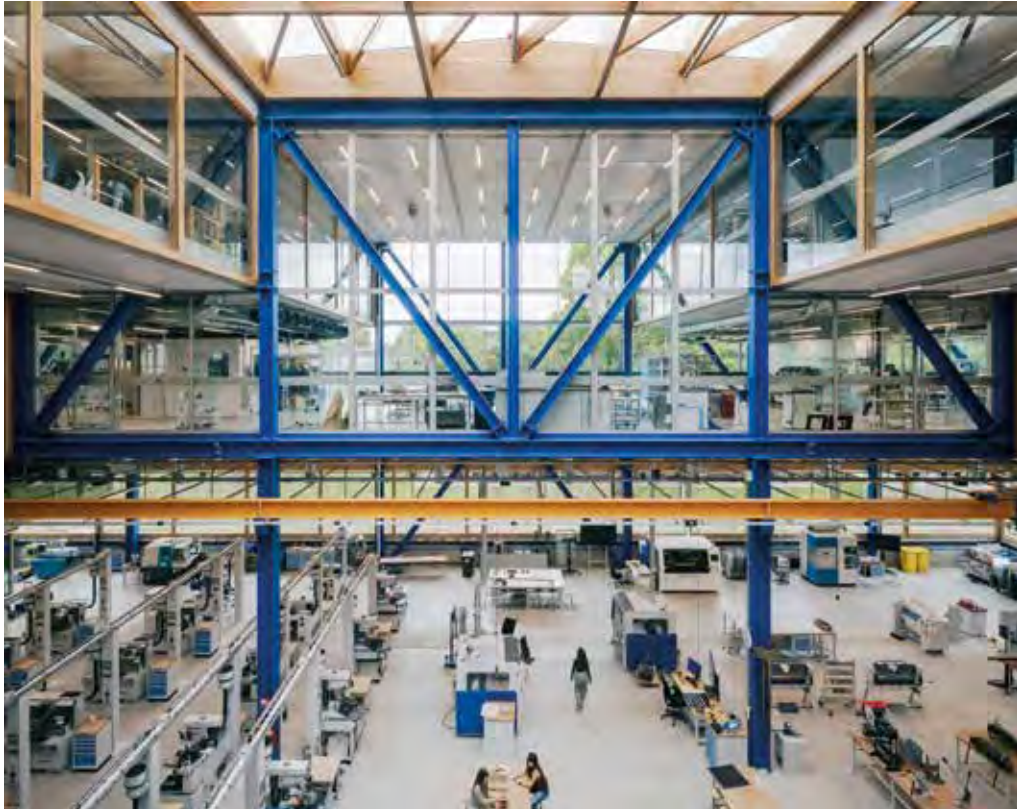
Blick in das abgesenkte Erdgeschoss im Bereich des Atriums © Stijn Bollaert
