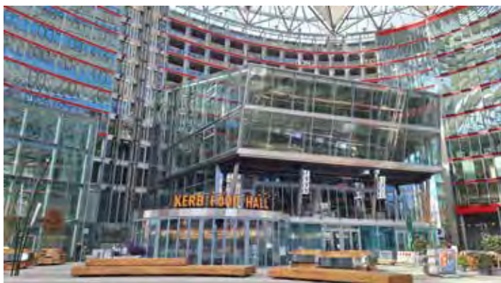
Erscheinungsbild der Gebäudehülle nach Fertigstellung © Lamparter GmbH & Co. KG
