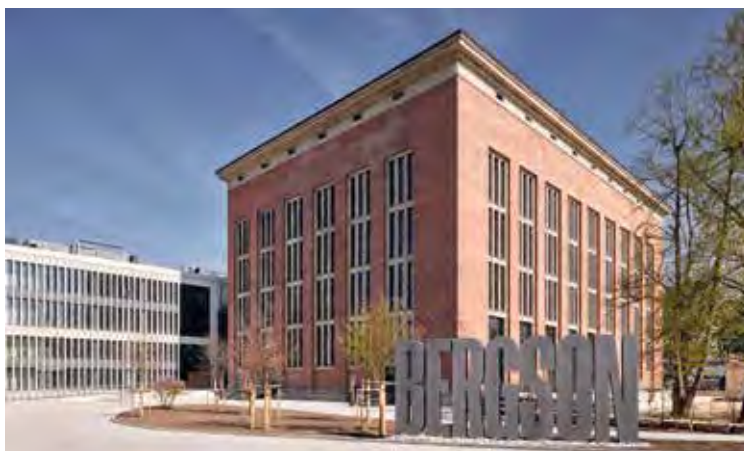
Ehemalige Kesselhalle als heutiges Bergson Kunstkraftwerk © Laura Thiesbrummel/Jansen AG
