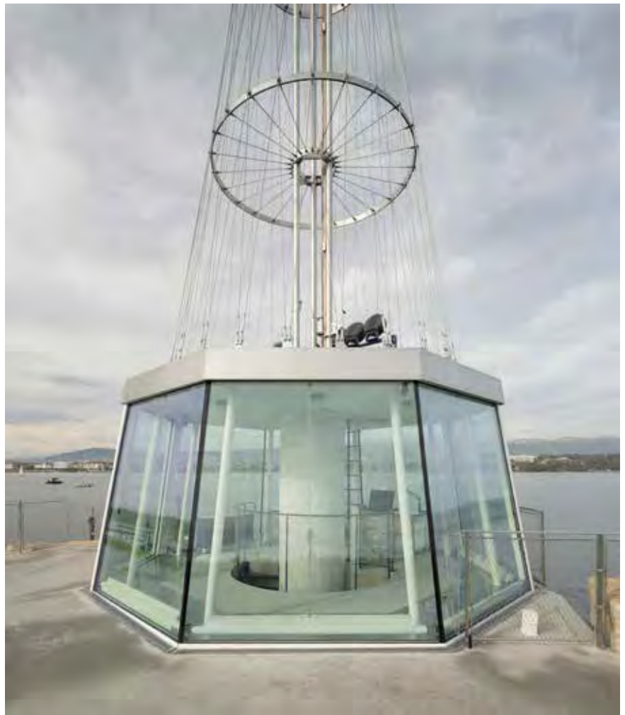
Obergeschoss und aufgehendes Seiltragwerk © Dylan Perrenoud
