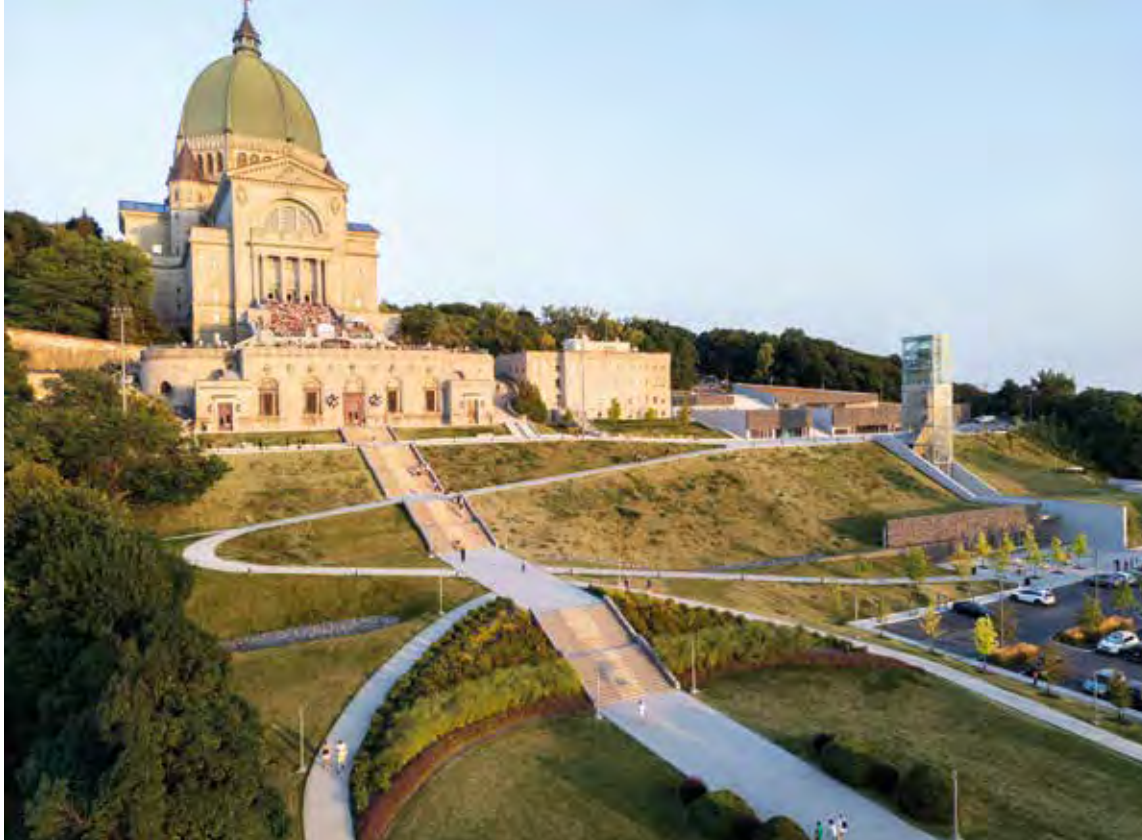
Gesamtansicht der Wallfahrtsstätte mit neuem Eingangspavillon (re.) © Adrien Williams
