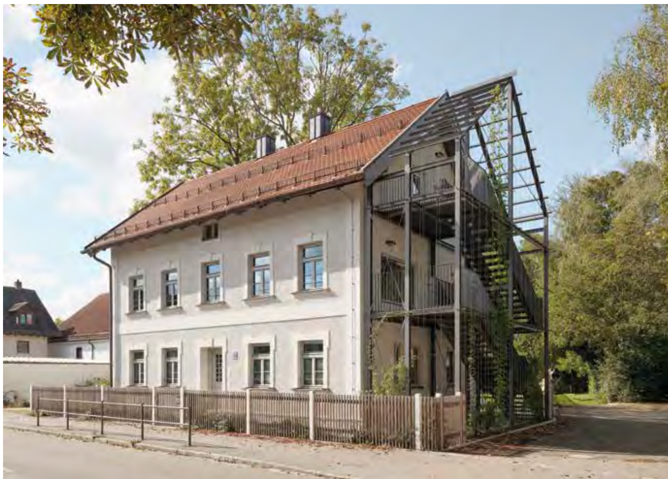
Externes Stahlfluchttreppenhaus als Gebäudeaddition © Maïke Hansen/bodensteiner fest Architekten
