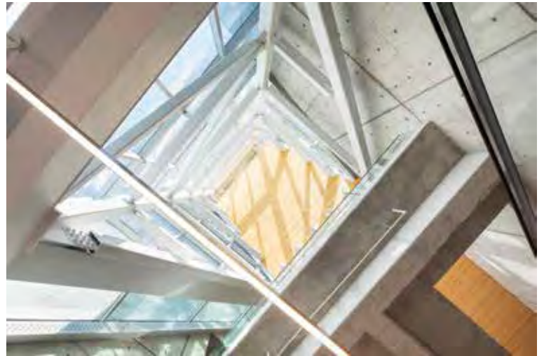
Blick in den oberen Turmbereich © Adrien Williams
