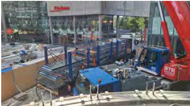
Anlieferung und Montage der Stahl-Glas-Segmente © Lamparter GmbH & Co. KG
