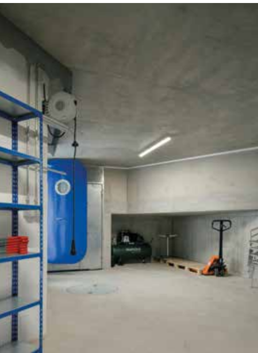
Lager- und Technikbereich © Dylan Perrenoud
