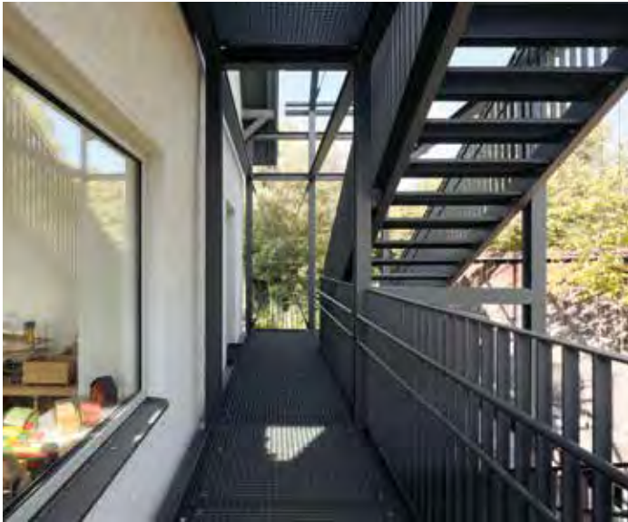
Detailansicht Stahlkonstruktion © Maïke Hansen/bodensteiner fest Architekten
