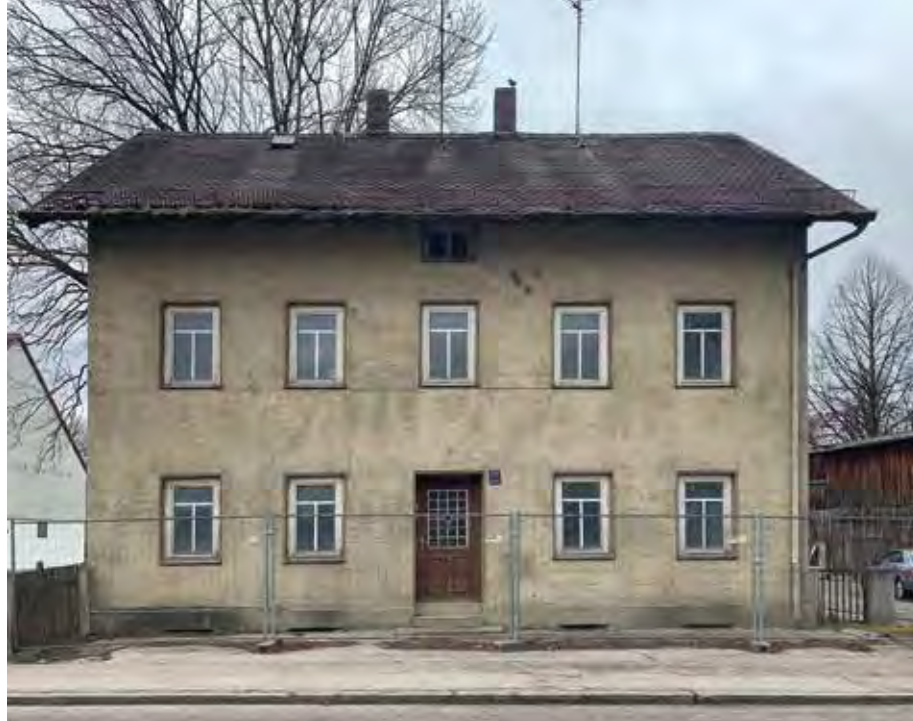
Straßenseitige Ansicht vor der Restaurierung bodensteiner fest Architekten
