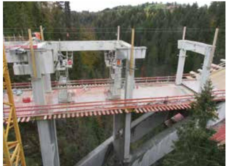
10 Rückbau der Längsträger unter dem Überbau
