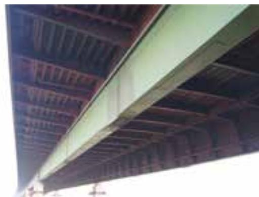
4 5 Stahlkonstruktion: Kanalfeld mit Vouten und Regelfeld © DEGES GmbH
