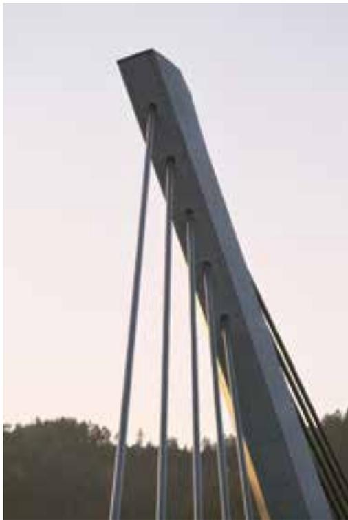
11 Pylonkopf mit Seilanschluss
