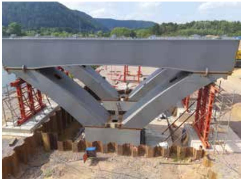
9 Zusammenbau einer V-Stütze © Heinz Schnorpfeil Bau GmbH
