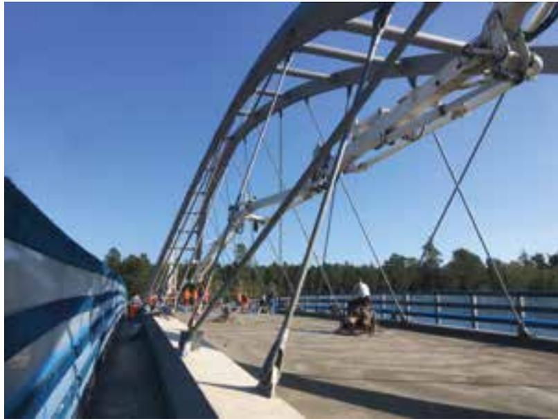
15 Betonieren der Fahrbahnplatte
