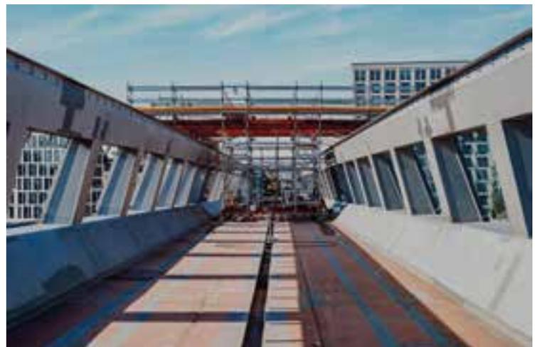
16 17 Verfahrbares Arbeitsgerüst »vor« den Bögen der Hackerbrücke und Gerüst auf dem Überbau
