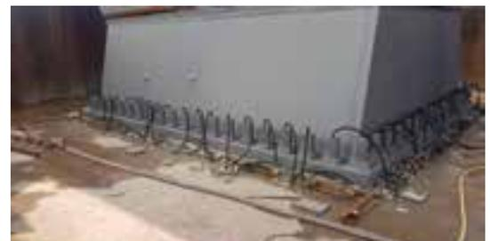
12 Spananker am Fußkasten der Mittelpfeiler
