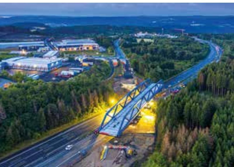
**20** Einfahren der Brücken unter Vollsperrung der Autobahn
