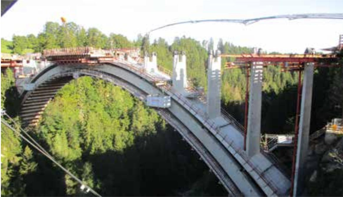
19 Betonage des Überbausegments am Scheitel
