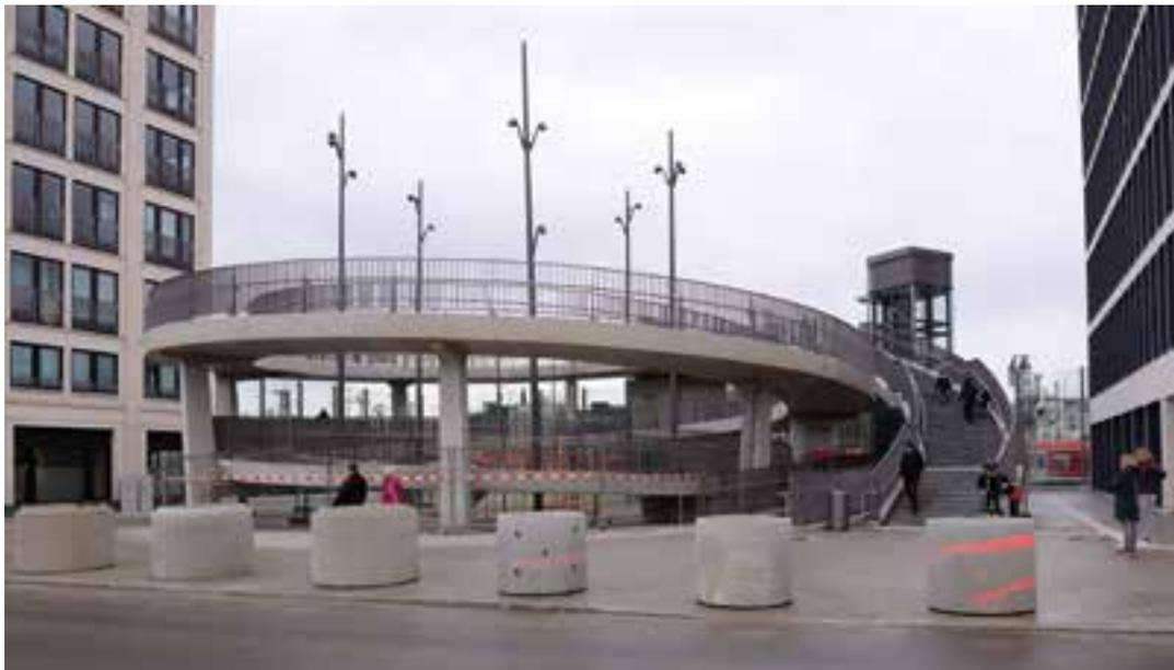
23 Spindelrampe Nord mit Treppe, Aufzug und Lärmschutzwand
