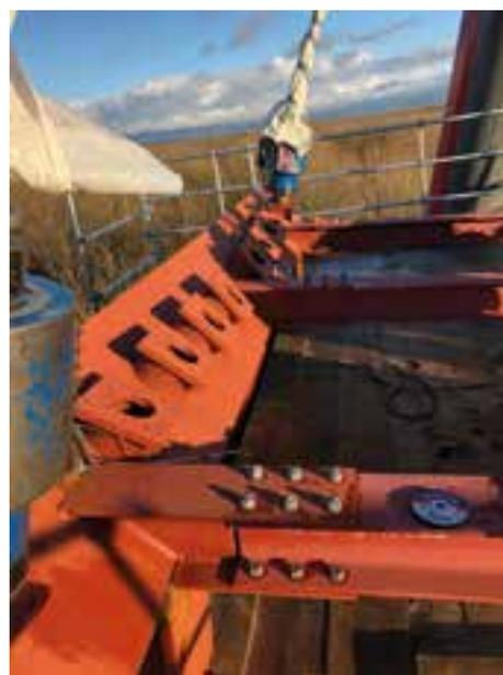
**14 15** Montage der Hilfspylone und Seilverankerung am Pylonkopf
