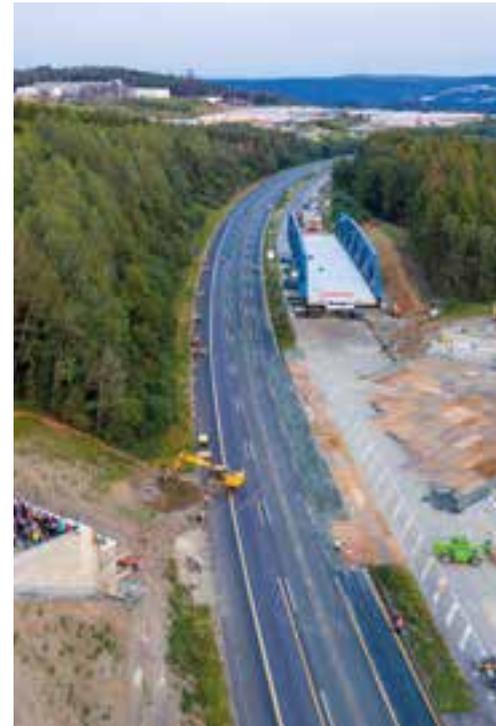
**19** Nördliche Brücke mit Betonfahrbahn vor dem Einfahren
