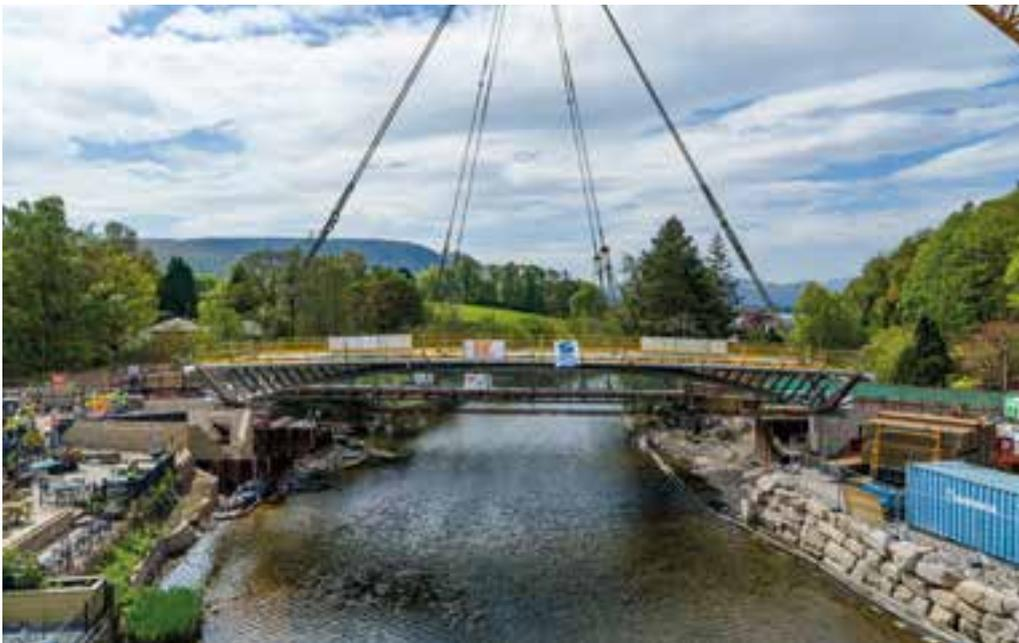
12 13 Einheben und Absetzen des Brückenbauwerks
