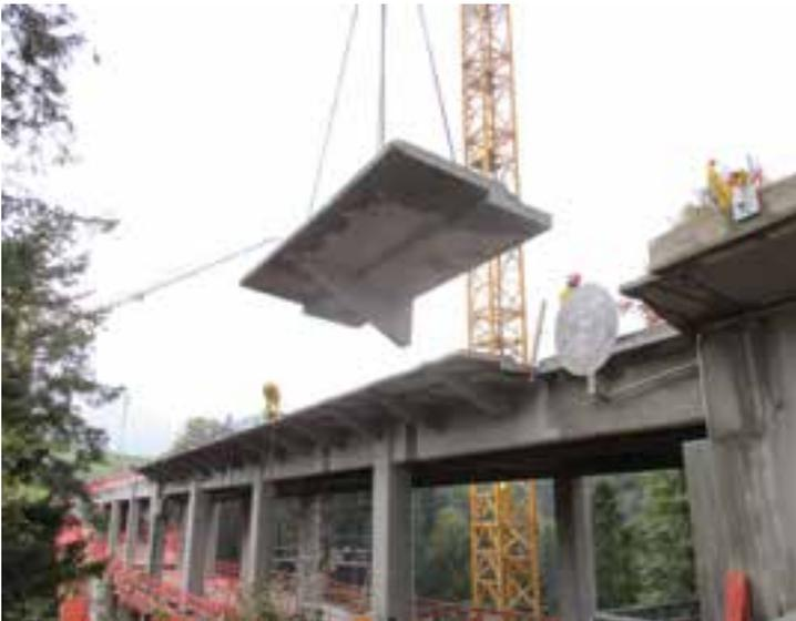
9 Aushub eines Kragarmteilstückes
