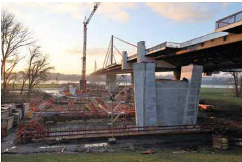
4 Baugruben der Achsen 50–80 und Kragarmentfernung am Bestandsbauwerk
